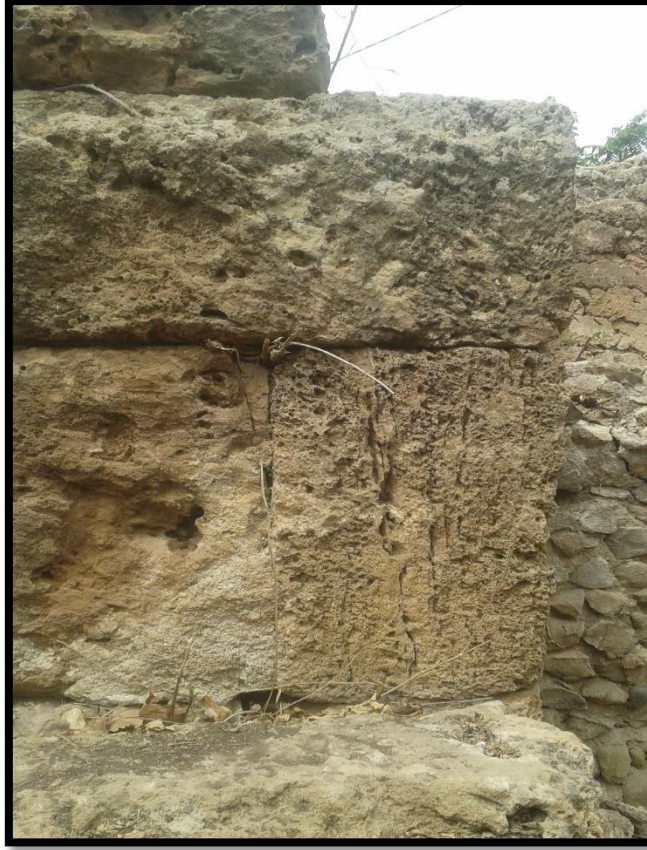
الصورة رقم ( 15): تخشن السطح بفعل الرياح
