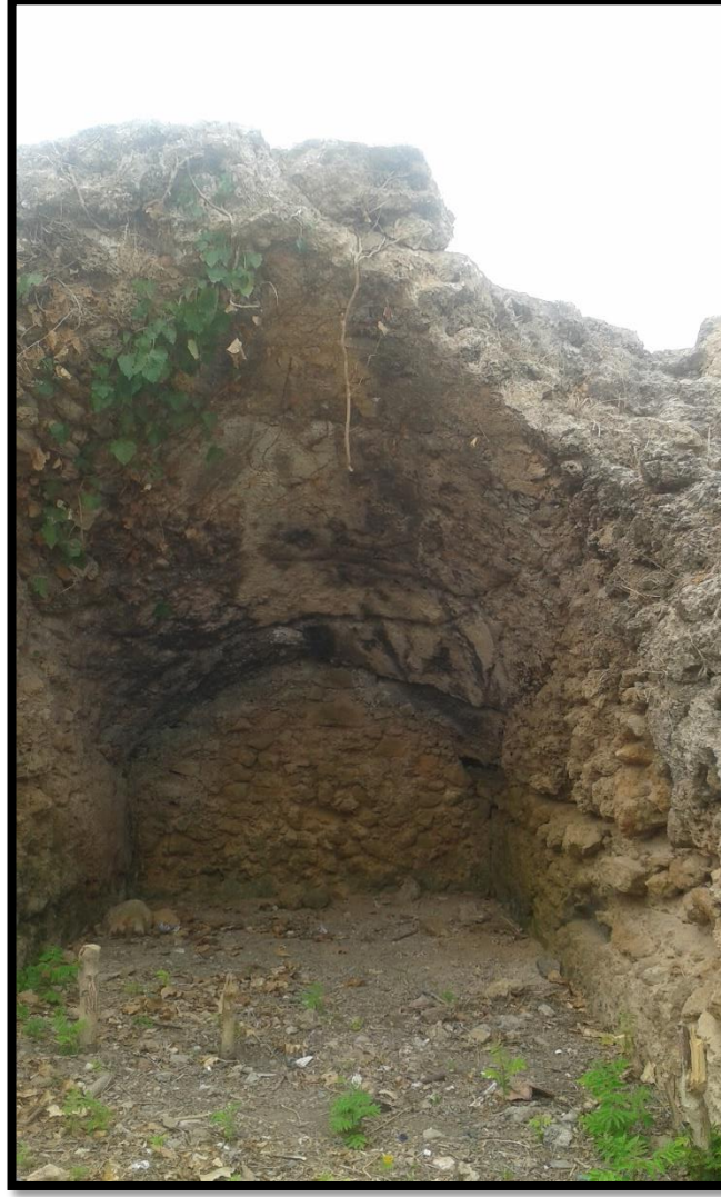
الصورة رقم (10) :تركيبه القبو
