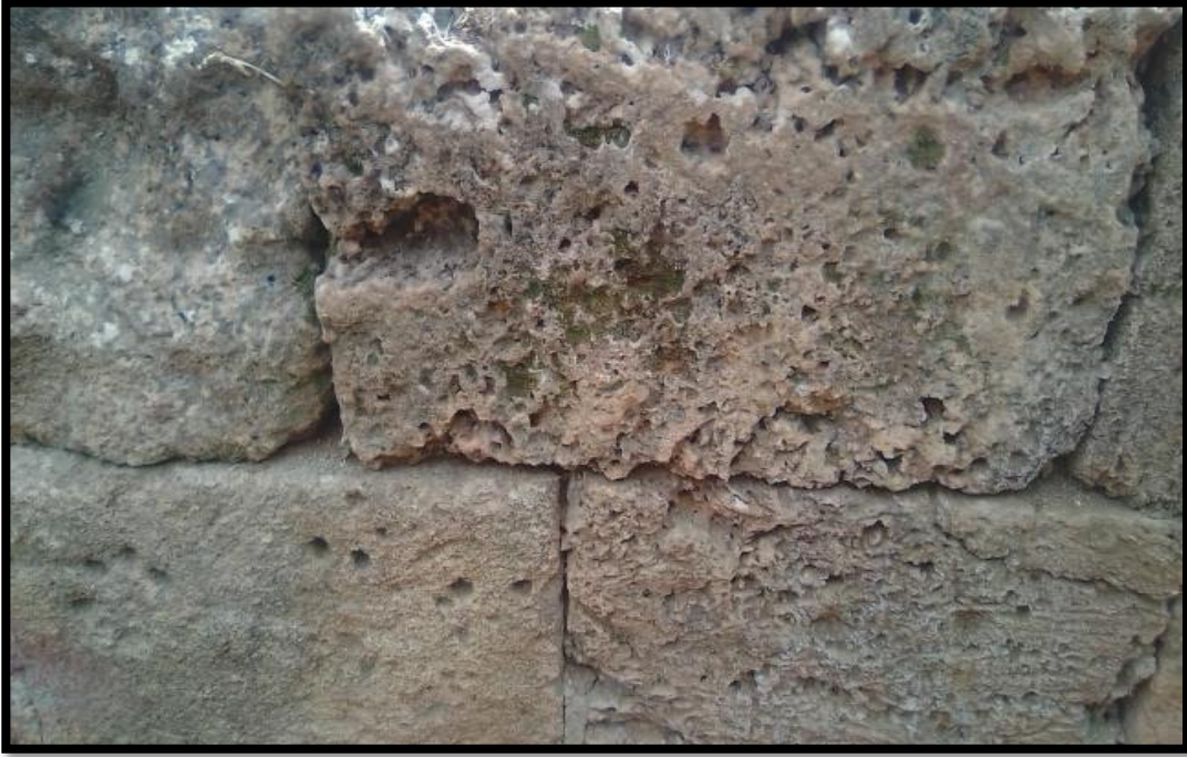
الصورة رقم (14): تجاويف وثقب بفعل الرياح
