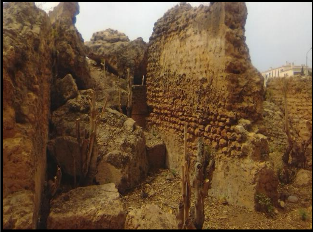
الصورة رقم(06): أجزاء لغرفة على الواجهة الشمالية.
