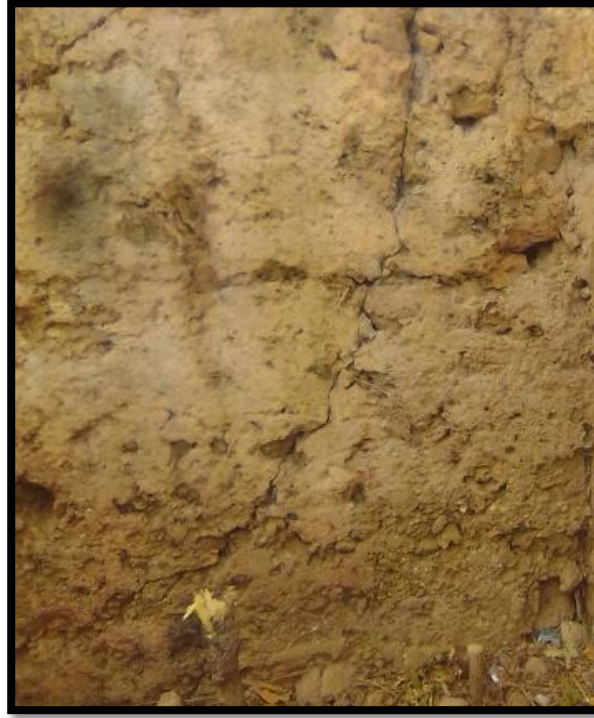
الصورة رقم (19): تأثير الحرارة على الأسطح
