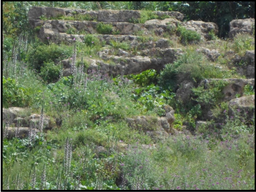
الصورة رقم (31) نمو النباتات سبب ضغط للأحجار
