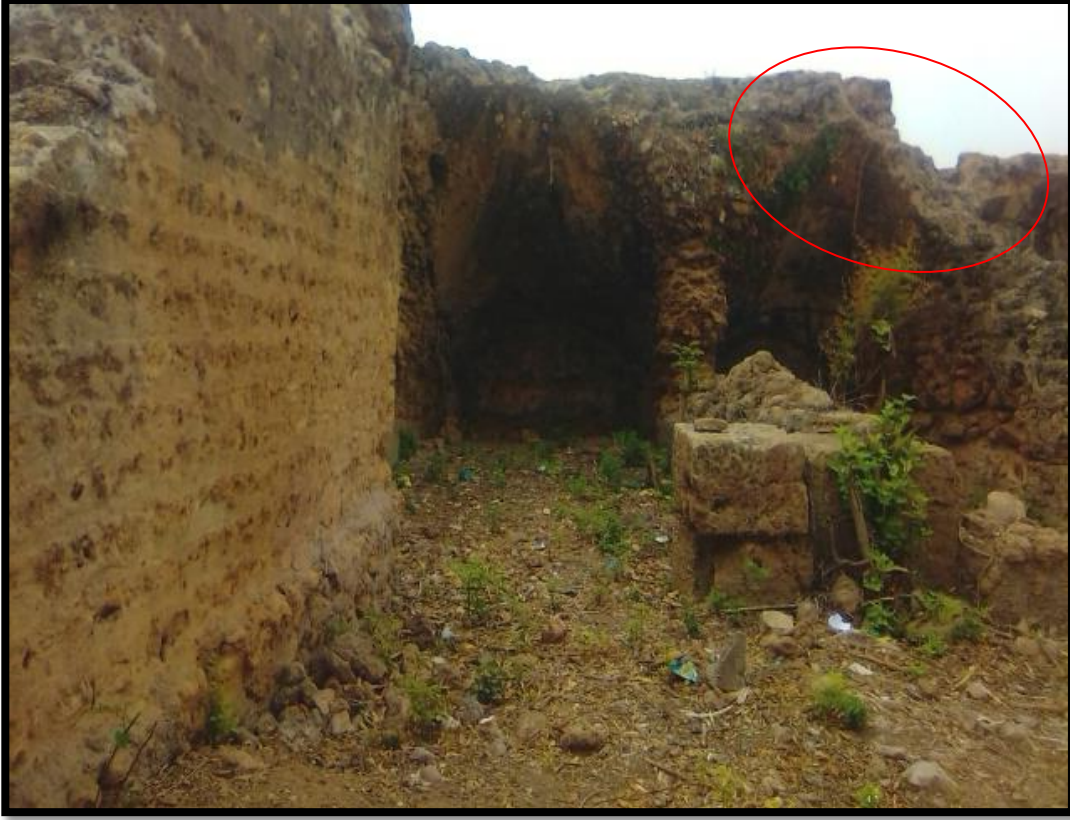
الصورة رقم (18): سقوط أجزاء من الأقبية
