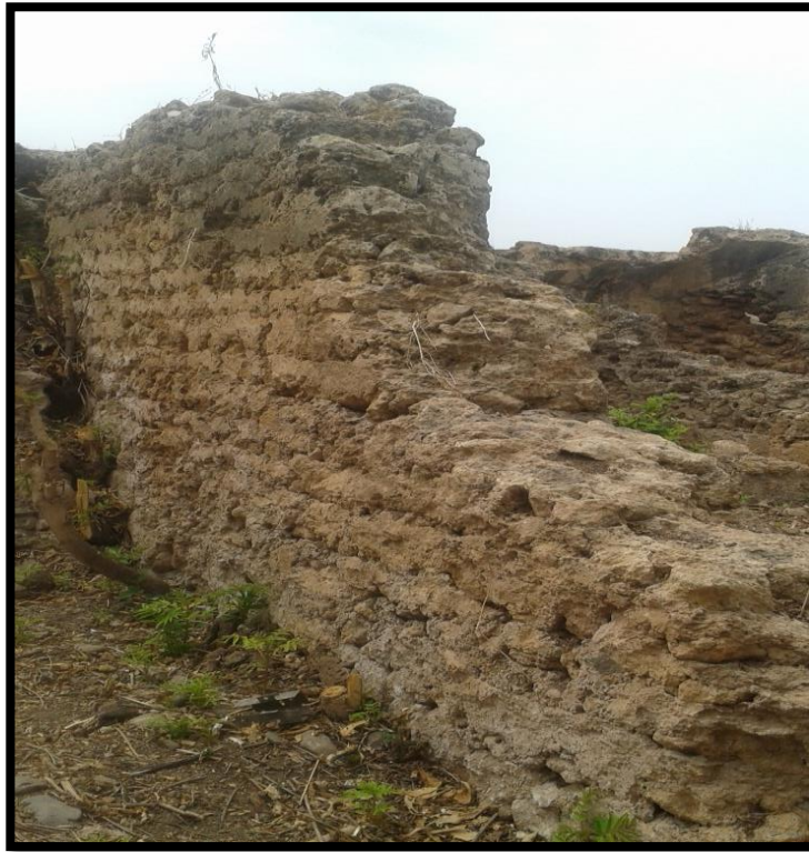
الصورة رقم (12): زوال التغطية بفعل الأمطار.
