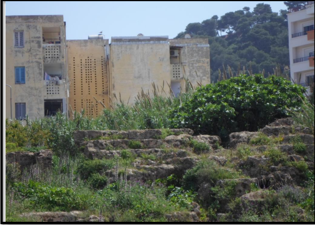
الصورة رقم (29): تجاوز الإرتفاع على حساب المبنى الأثري
