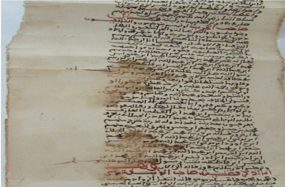
الصورة 127 : آثار الرطوبة
