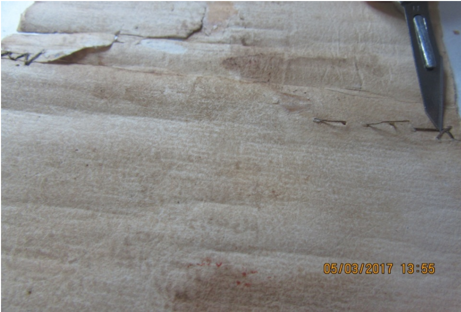
الصورة 136 : إزالة الترميم القديم ميكانيكياً
