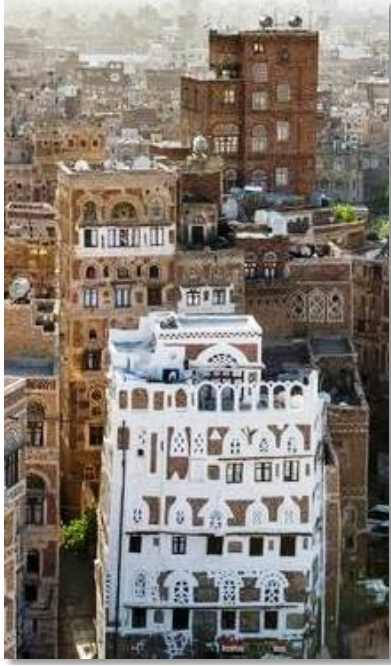
الصورة رقم (132) واجهة من واجهات المباني بعد الترميم
