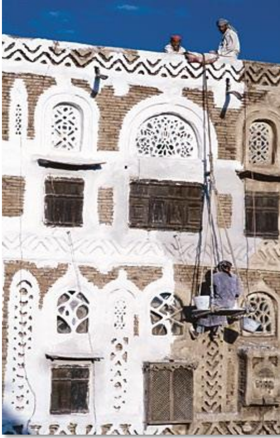
الصورة رقم (100) ترميم القمريات
