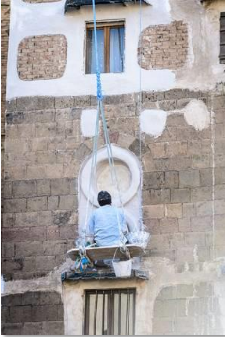
الصورة رقم (131) واجهة مبنى أثناء الترميم
