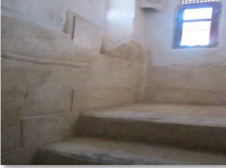
الصورة رقم(66) درج المبنى
