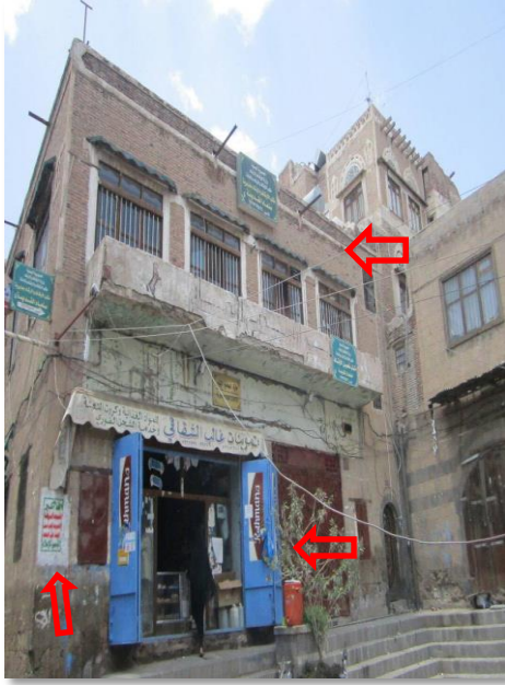
الصورة رقم (106) أبواب حديدية وقمريات جصية مفقودة
