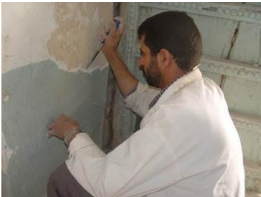
الصورة رقم (134) ترميم الطبقات الجصية وتثبيت الزخارف من الداخل
