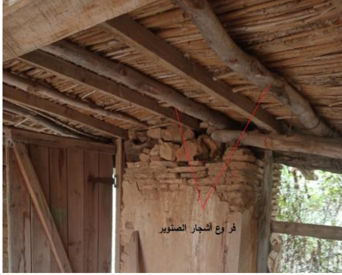
الصورة 32: استعمال جذوع أشجار الصنوبر في التسقيف
