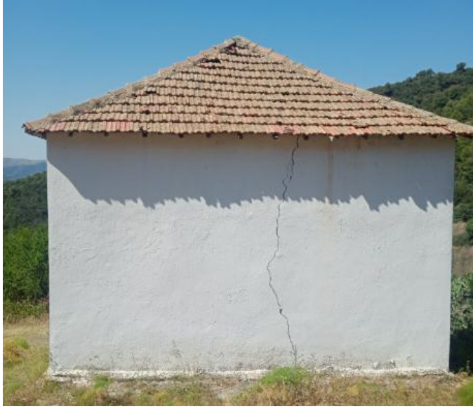
الصورة 44: التسقيف الخارجي لضريح سيدي سالم
