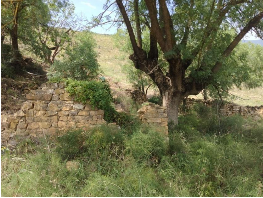
الصورة 24: بقايا زاوية لسيخ
