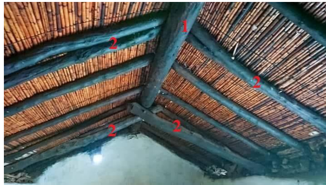
الصورة 34: استخدام القنطاس من خشب الكاليتوس (1) والعوارض من أنواع متعددة بين الصنوبر والعراعر والبلوط (2)
