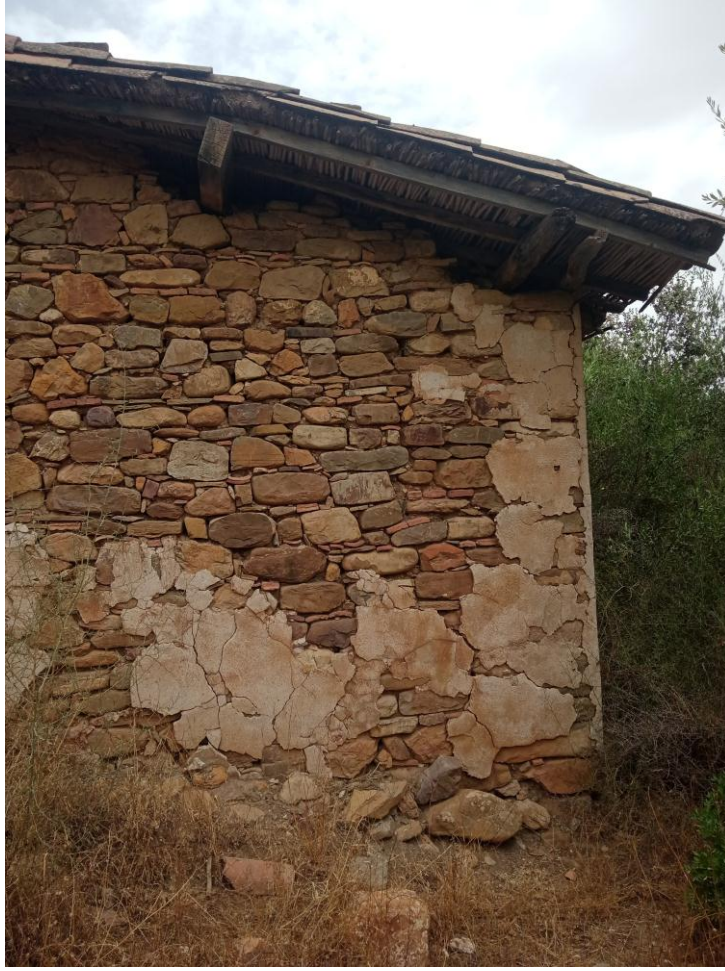
الصورة 42: السقف يرتكز على عوارض خشبية (ضريح سيدي علي بن سليمان)
