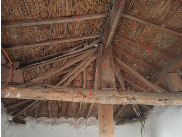
الصورة 39: المكونات الخشبية للتسقيف الجملوني بزوايا منطقة الاخضرية
