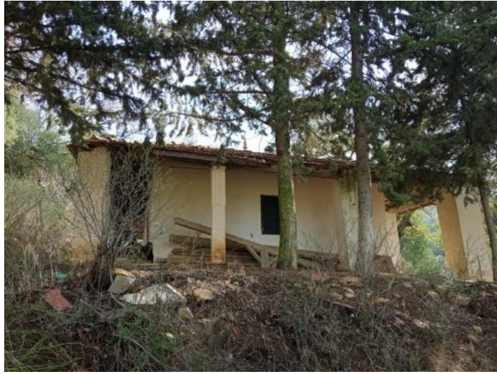
الصورة 02: الأرضية التي شيدت عليها الزاوية
