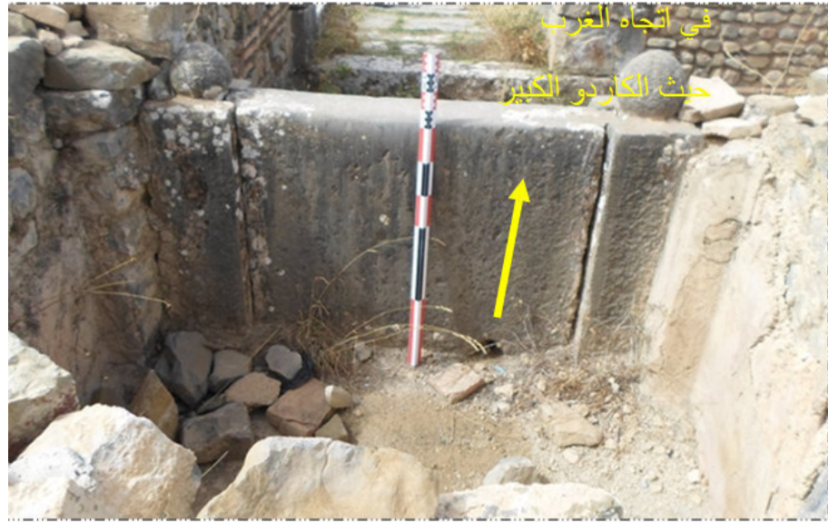
صورة رقم 107: ثقب تصريف المياه في الاتجاه الغربي للحمامات (تصوير الطالب)
