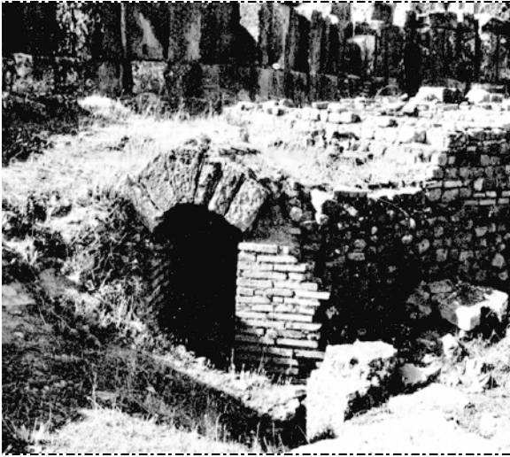
صورة رقم 132: صورة من الأرشيف لقناة تصريف مياه الحمامات الجنوبية 1
