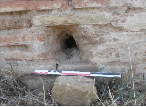
صورة رقم 51: فتحة تصريف مياه القاعة الباردة (تصوير الطالب) صورة رقم 52: فتحة تصريف مياه الحوض البارد (تصوير الطالب)
