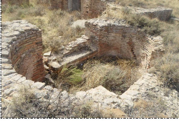
صورة رقم 98: الحوض الشمالي للقاعة الباردة (تصوير الطالب)
