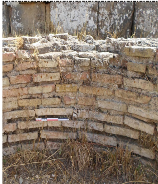
صورة رقم 140: تقنية بناء الحوض البارد بالآجر (تصوير الطّالب)
