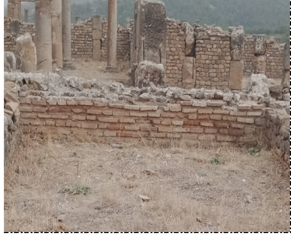
صورة رقم 134: تقنية البناء بالآجر بالحّمّامات الجنوبية (تصوير الطّالب)
