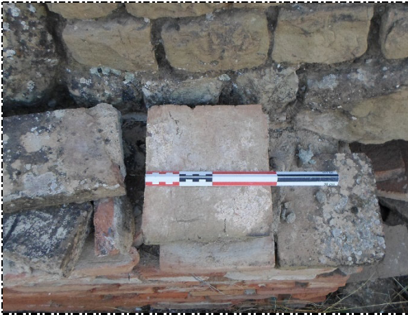
صورة رقم 43: عينة من البلاطات الآجورية لأعمدة الهيبيوكوست (تصوير الطالب)
