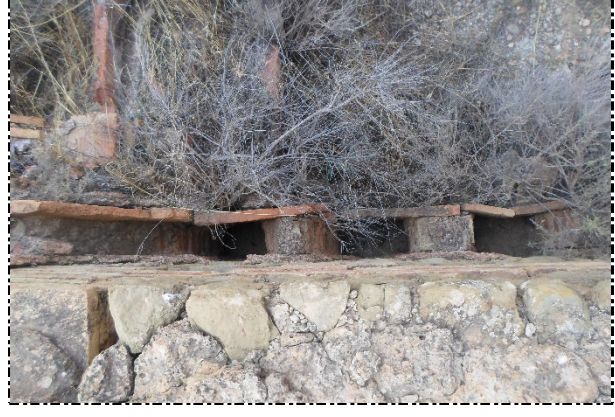
صورة رقم 95: فتحات التسخين العمودي للقاعة الساخنة الشرقية (تصوير الطالب)
