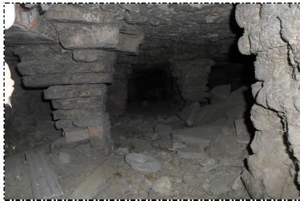
صورة رقم 12: الأعمدة الحاملة لأرضية القاعة الساخنة الشمالية (تصوير الطالب)
