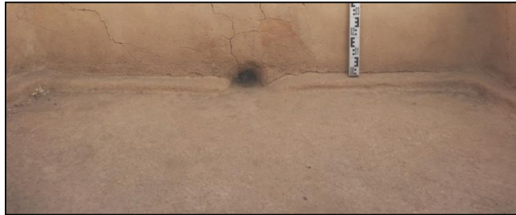
الصورة رقم 47: مظهر لأرضية الحوض "ح4" النصف الشرقي
