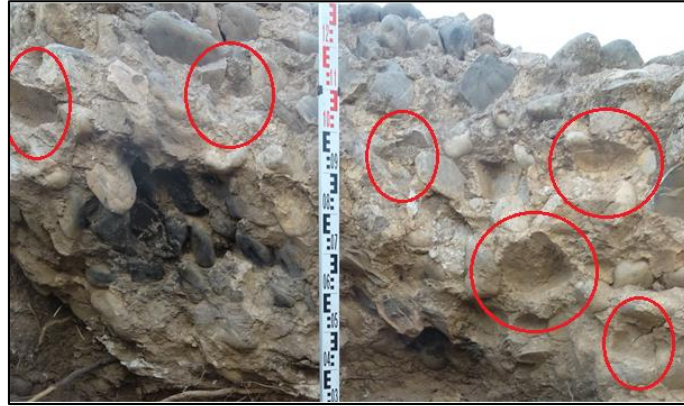
الصورة رقم 113: سوابل افلات الحجر عن الملاط الجيري
