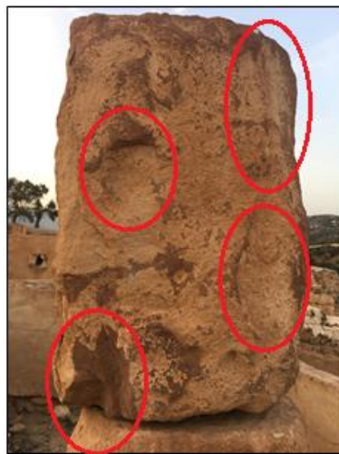
الصورة رقم 116: توضح فقدان الحجارة لأجزاء منها
