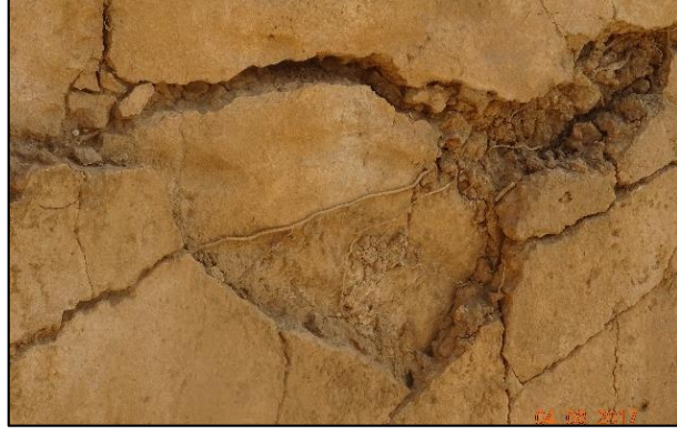
الصورة رقم 104: تأثير التلبيس لعامل الحرارة المفاجئ انفصال الطبقة الثانية عن الطبقة الأولى
