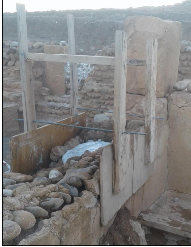
الصورة رقم 122: توضح وصلات ربط تعمل على ربط سطحي الجدار مع بعضهما
