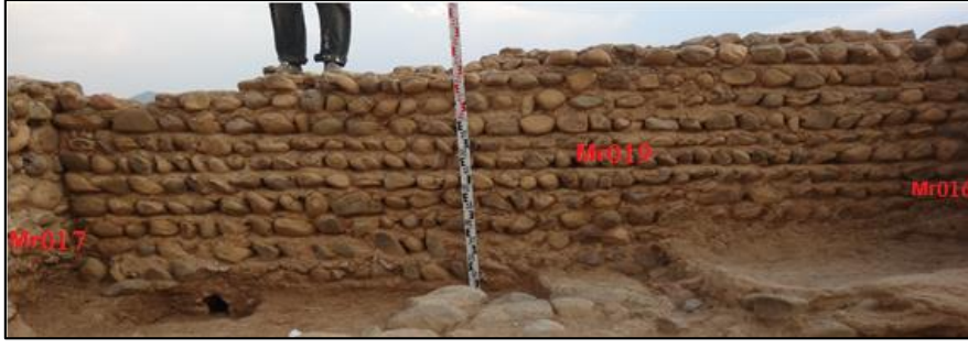
الصورة رقم 89: منظر شمالي للسور Mr019
