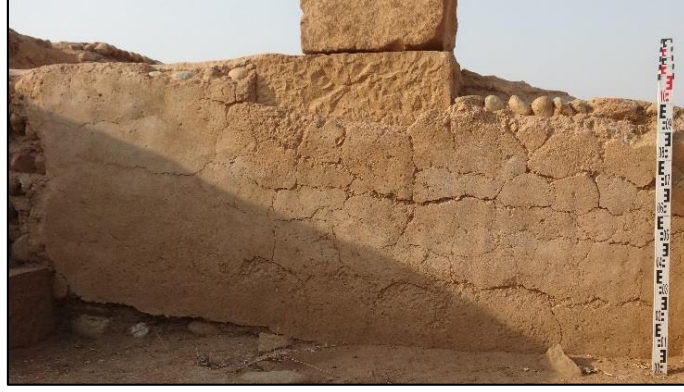
الصورة رقم 105: توضح تأثير التحرك الحراري على الهيئة المعمارية
