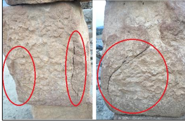
الصورة رقم 114: توضح فراغات أثناء التشكل للحجارة العلوية الثانية لـ Sb027
