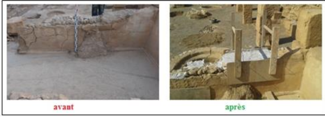
اللوحة رقم 32: توضح للسور Mr005 قبل وبعد التدخل.
