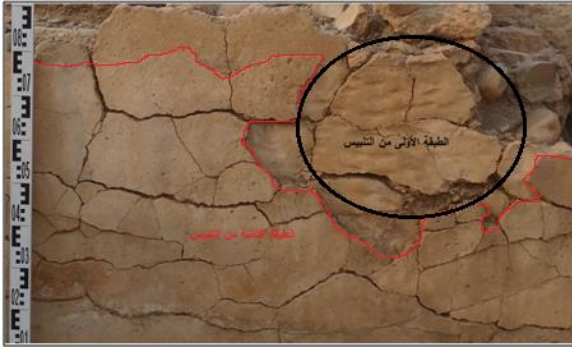
الصورة رقم 60: تبين توضع الطبقتين من التليس Mr006.
