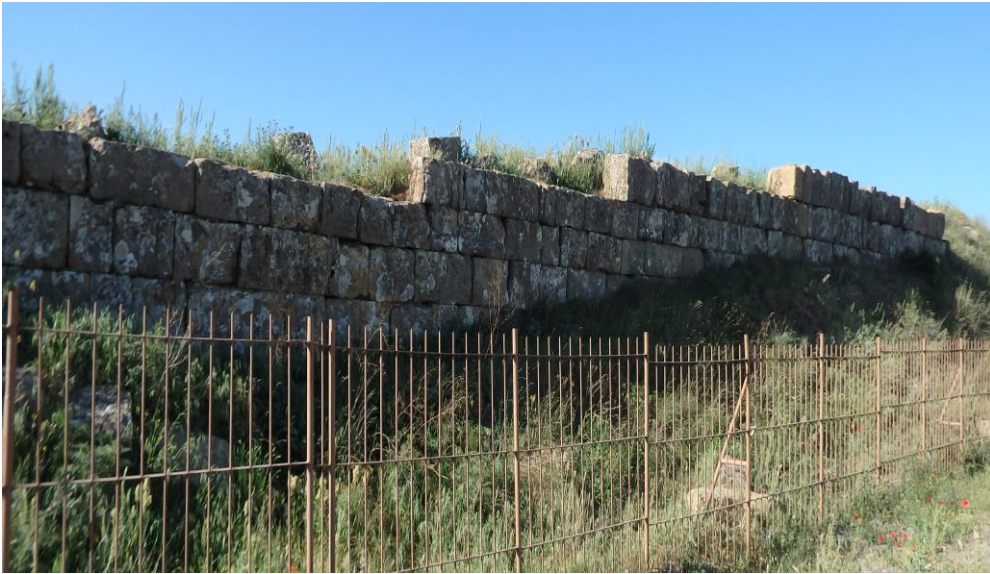
صورة رقم 02 : تبين تقنية الكوادراتوم المستعملة في اسوار المدينة
