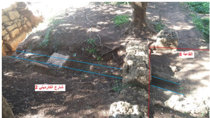
صورة رقم (221): قناة صرف مياه حوض القاعة 8 (حمامات خاصة) بمنزل اللوتيس. (عن الطالب، 2016/03)
