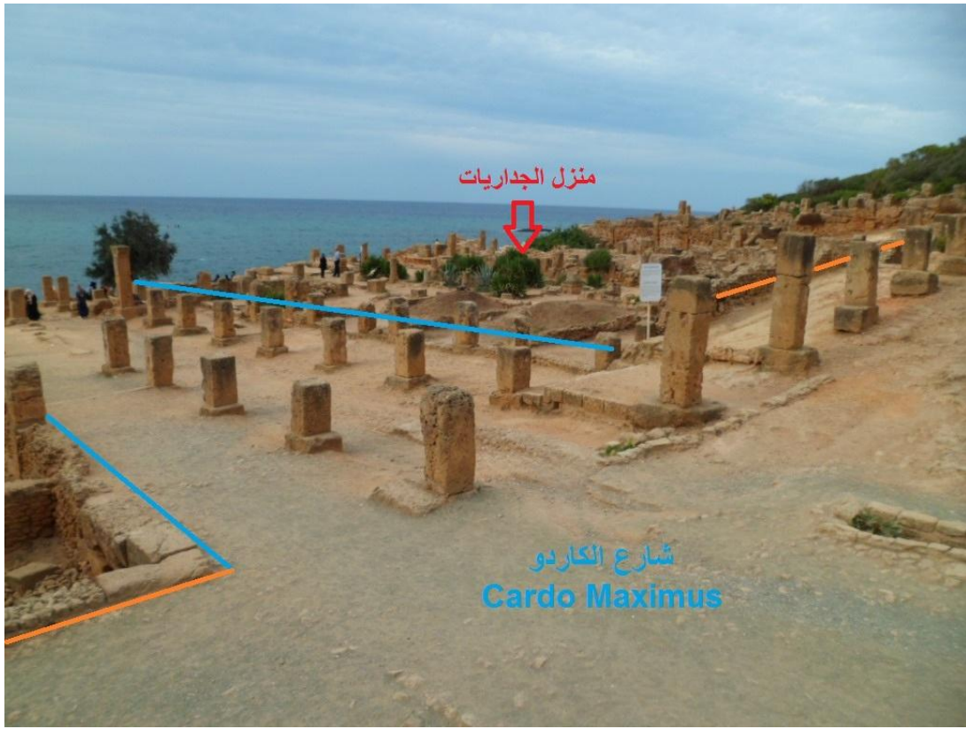
صورة رقم (14): الواجهة الغربية لمنزل الجداريات. (عن الطالب، 2015/08)
