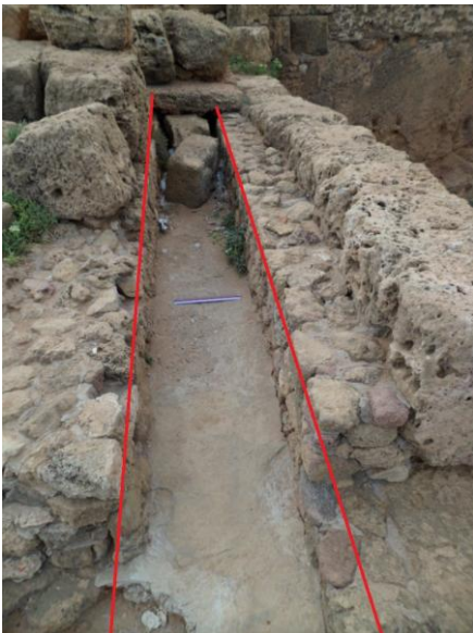
صورة رقم (220): النهاية الشمالية لقناة صرف حمامات منزل الجداريات. (عن الطالب، 2015/08)
