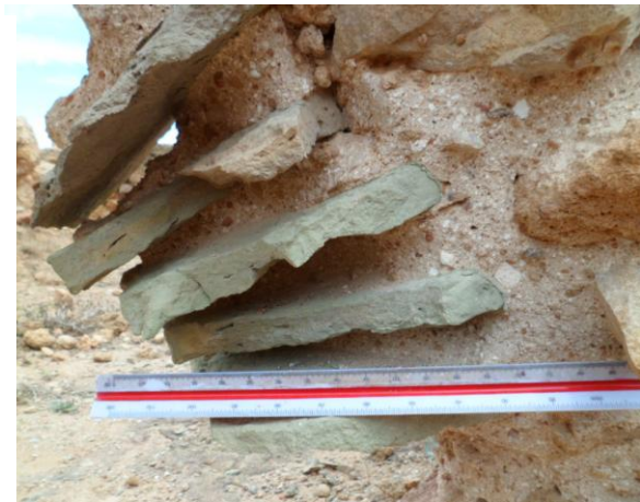
صورة رقم (194): استعمال الأجر لإنشاء الممر الحراري بالقاعة الساخنة ( II ) (الحمامات الخاصة بمنزل الجداريات). (عن الطالب، 2015/08)
