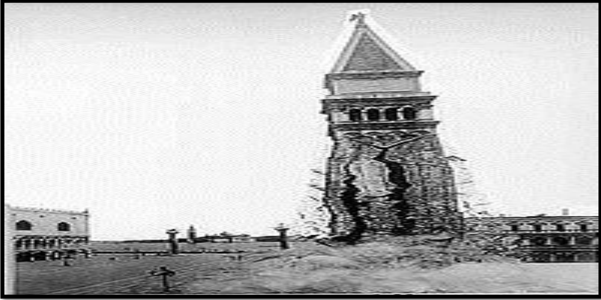
الصورة (32): برج القديس مرقس أثناء الانهيار سنة 1902.
