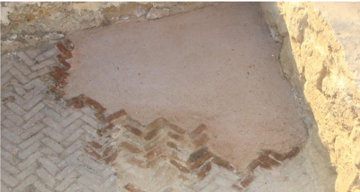
الصورة (21): الأرضيات قبل الترميم
