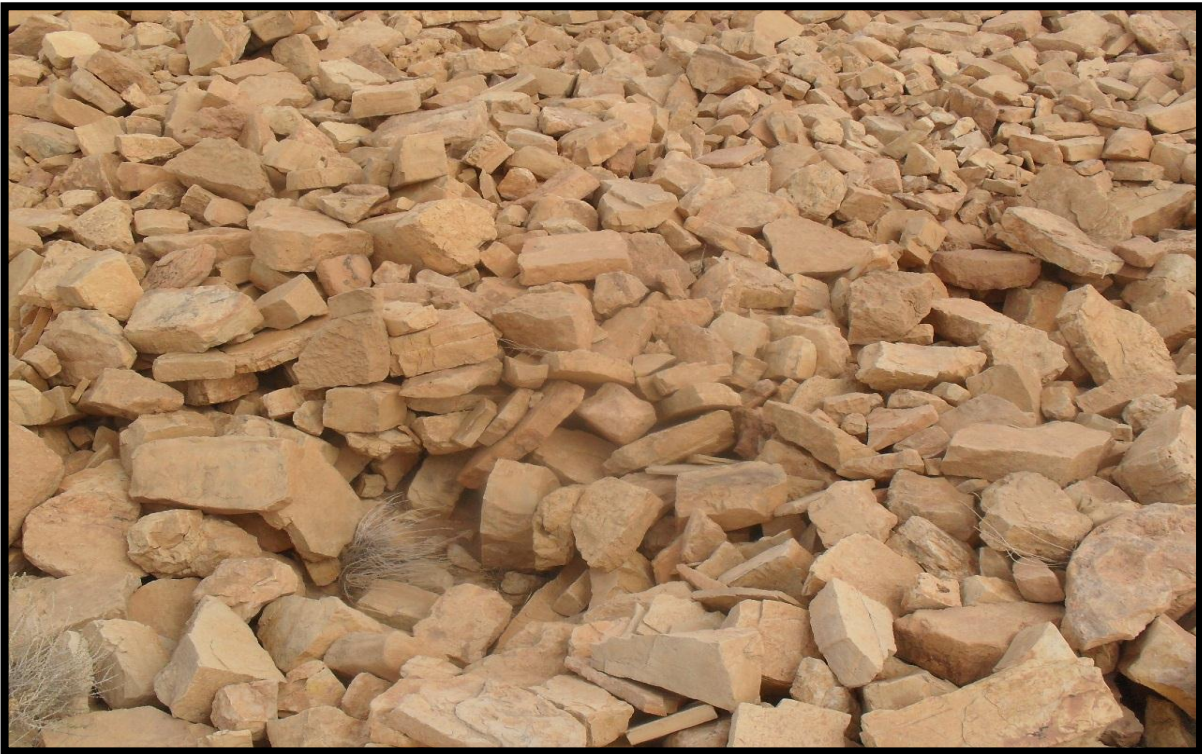
الصورة (10): ركام حجري لأحد مباني القلعة جراء الانهيار الكلي
