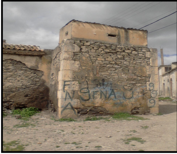
الصورة (د) : الركن الشرقي للبرج
