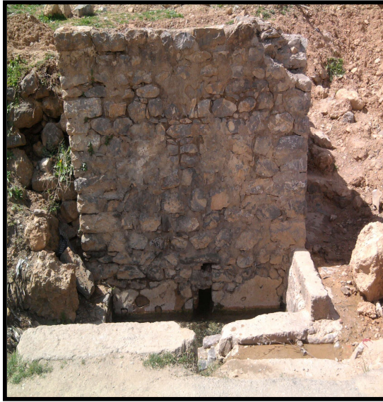
الصورة (ج) : جزء من جدار حمام أولاد سيدي الشيخ بمنطقة حمام أولاد سيدي الشيخ
