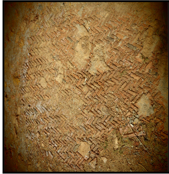
الصورة (ج) : أرضية مبلطة بطريقة السنبله بالحمام
