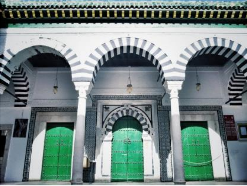
الصورة رقم 126: واجهة المسجد بمداخله الثلاث المشرفة على الصحن
