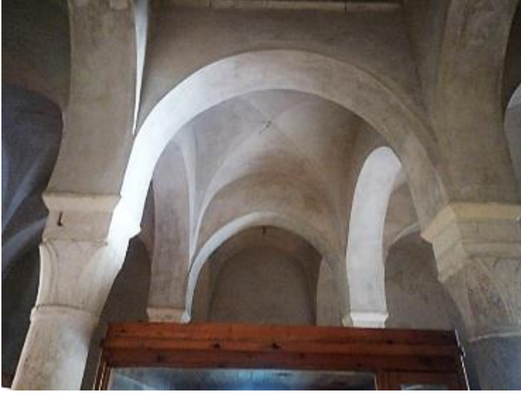
الصورة رقم 88: التسقيف بالأقبية المتقاطعة
