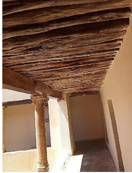
الصورة رقم 43: إحدى غرفة الطلبة بالطابق العلوي
