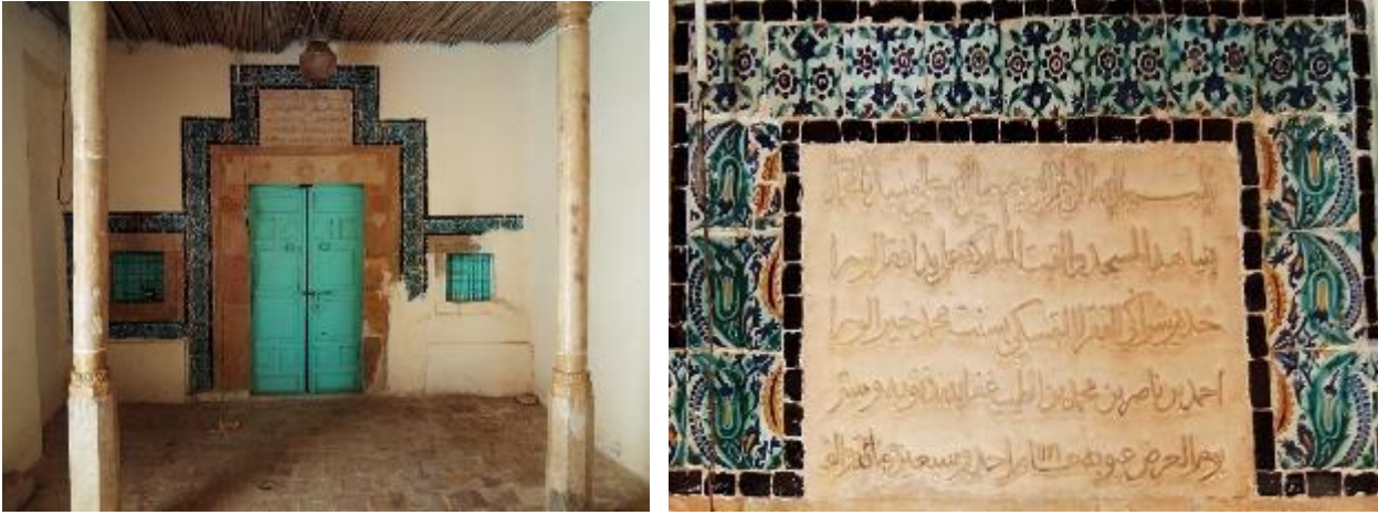
الصورة رقم 47: الكتابة التأسيسية أعلى مدخل ضريح الشيخ سيدي مبارك
