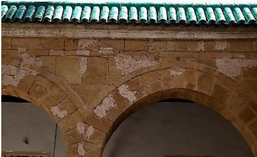
الصورة رقم 100: ترميمات على الواجهة الجنوبية المطلّة على الصحن
