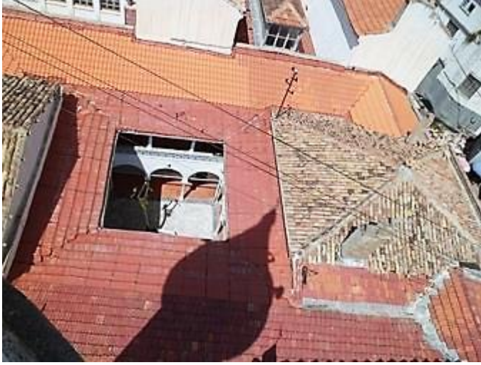
الصورة رقم 63: التسقيف الخارجي للمدرسة ويظهر الشكل للهرمي لسقف المقبرة العائلية
