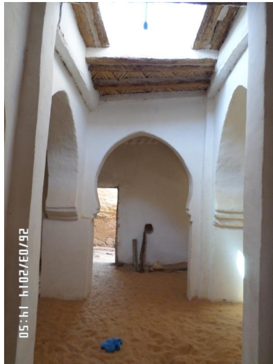
الصورة رقم 151 : الدعامات المتعامدة بمسجد قصر تاغيت ( عن الطالب )
