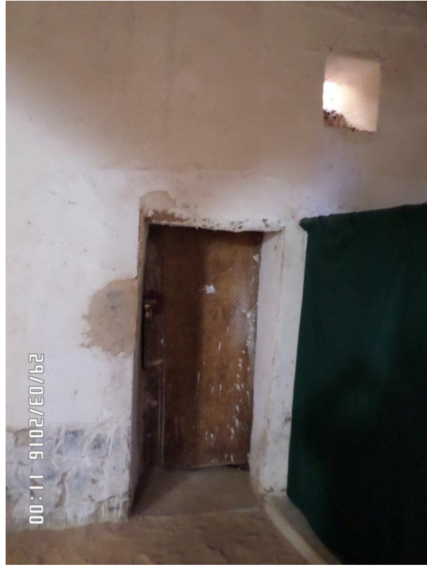
الصورة رقم 118 : المدخل الغربي لبيت الصلاة بمسجد قصر بني عباس ( عن الطالب )
