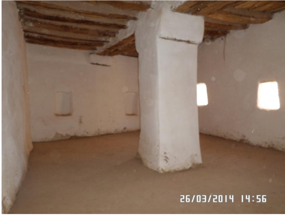
الصورة رقم 142 : المحضرة بمسجد قصر تاغيت ( عن الطالب )
