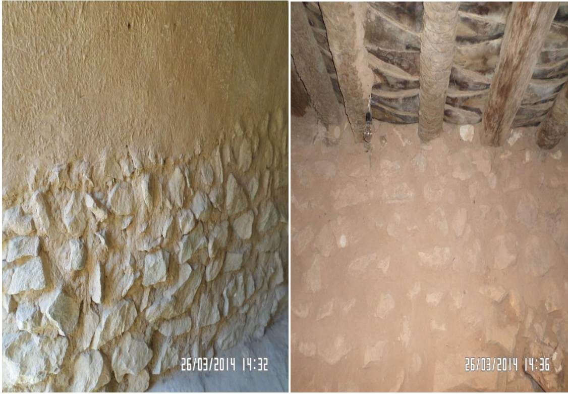
الصورة رقم 170: طريقة المزج بقصر تاغيت ( عن الطالب )
