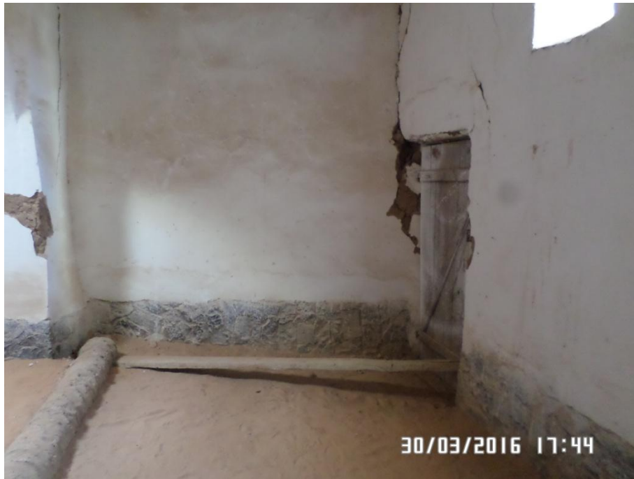
الصورة رقم 119 : المدخل الشمالي لبيت الصلاة بمسجد قصر بني عباس ( عن الطالب )
