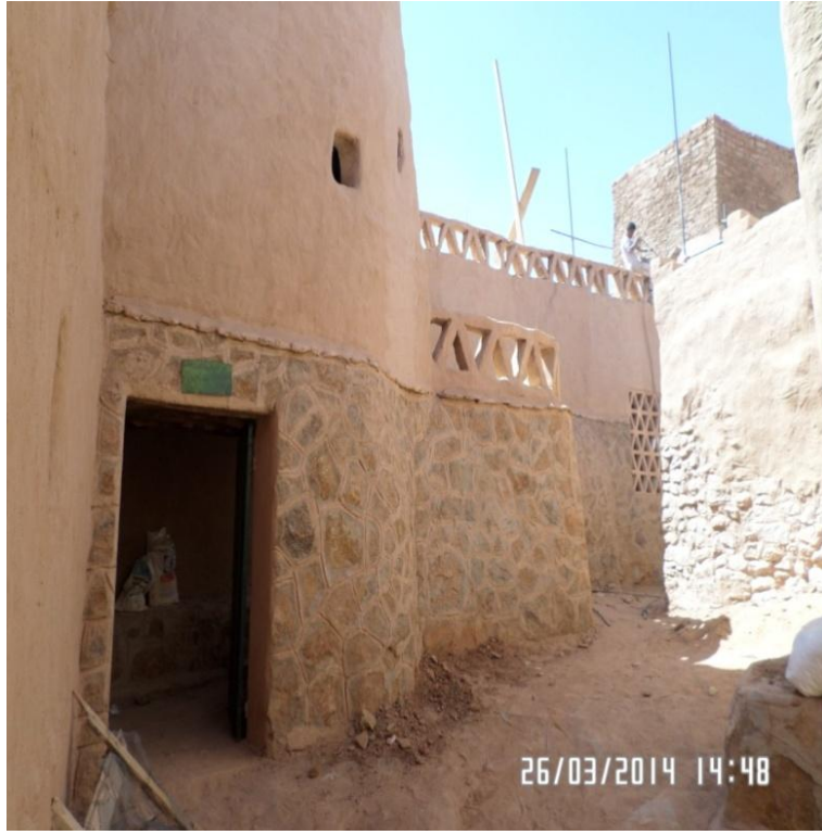
الصورة رقم 110 : واجهة المسجد من الجهة الشرقية قصر تاغيت ( عن الطالب )
