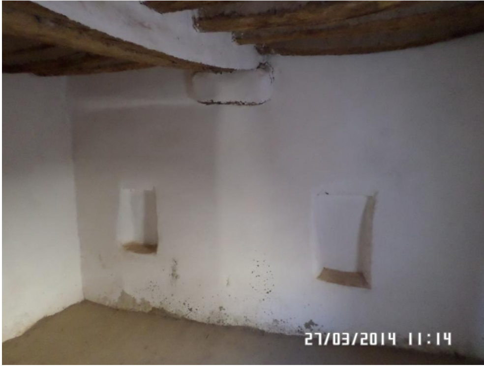
الصورة رقم 162 : استعمال الجير في تغطية جدران الغرف بقصرين ( عن الطالب )
