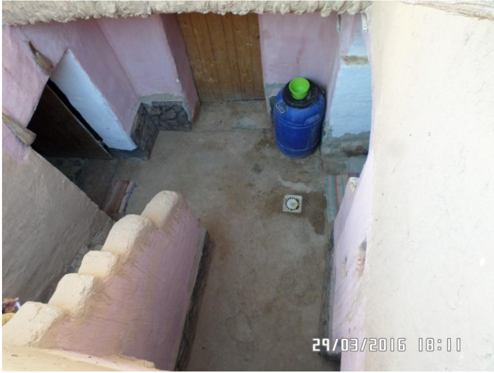
الصورة رقم 84 : صحن منزل النموذج الثالث قصر بني عباس ( عن الطالب)
