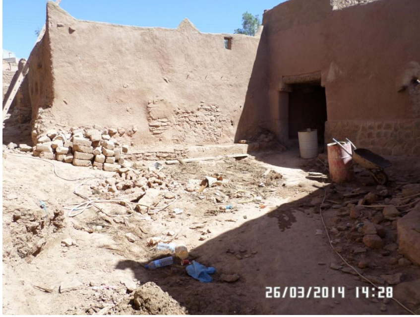
الصورة رقم 23 : الرحبة الرئيسية لقصر تاغيت اثناء عملية الترميم ( عن الطالب)
