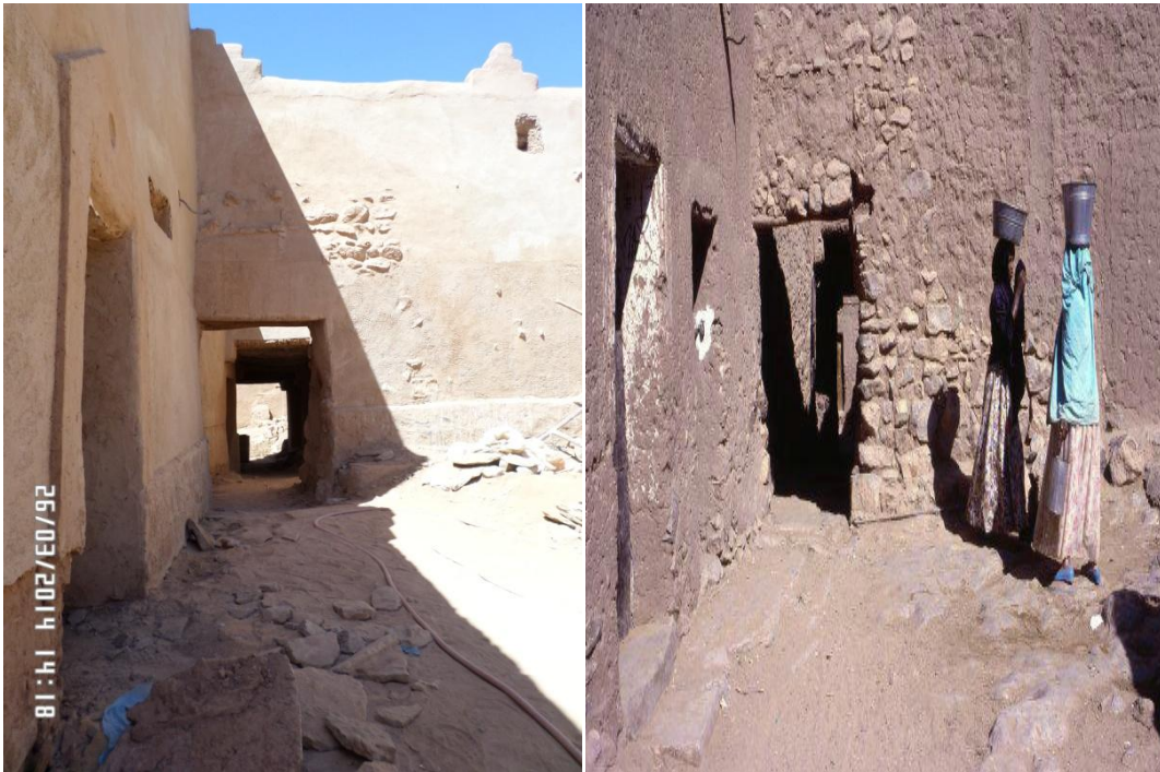
الصورة رقم 103: المدخل الرئيسي بالجهة الجنوبية قصر تاغيت ( عن الطالب )
