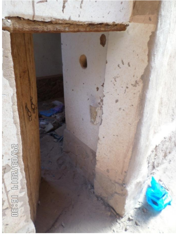
الصورة رقم 72: مدخل منزل النموذج الثالث بقصر تاغيت ( عن الطالب)
