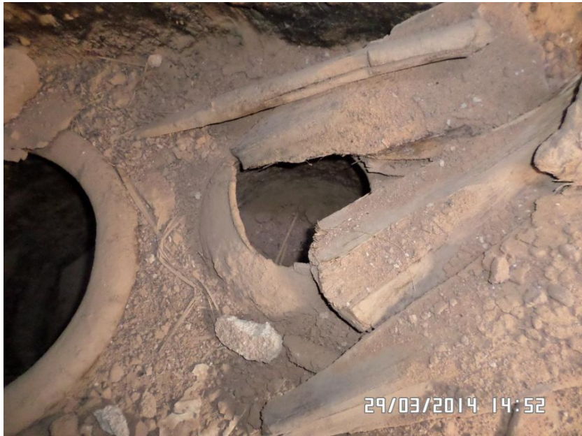
الصورة رقم 52: المخازن الارضية بقصر تاغيت ( عن الطالب )
