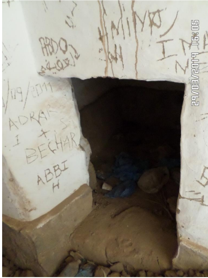
الصورة رقم 51: احد المخازن بمنازل قصر تاغيت ( عن الطالب )
