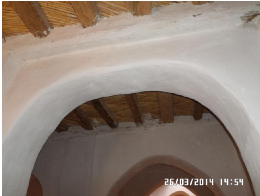
الصورة رقم 153 : القعد الحدوي غير منتظم بمسجد قصر تاغيت ( عن الطالب )
