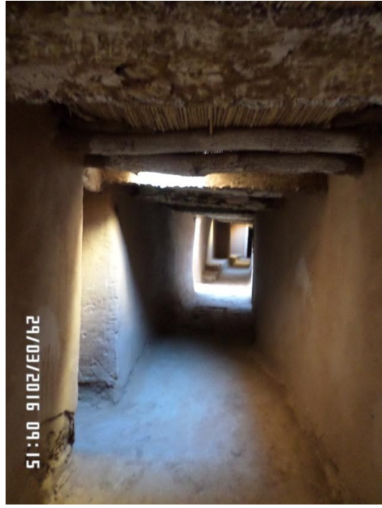
الصورة رقم 37 : الشارع الرئيسي بقصر بني عباس ( عن الطالب)
