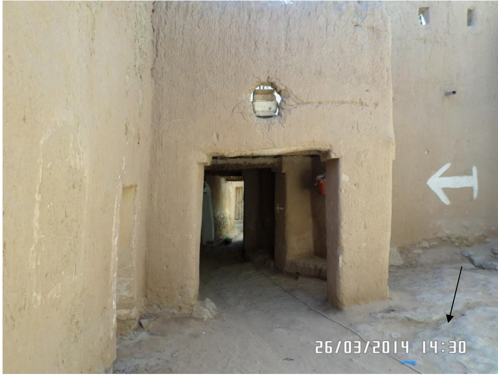
الصورة رقم 25: رحبة المقيزرة بقصر تاغيت ( عن الطالب )
