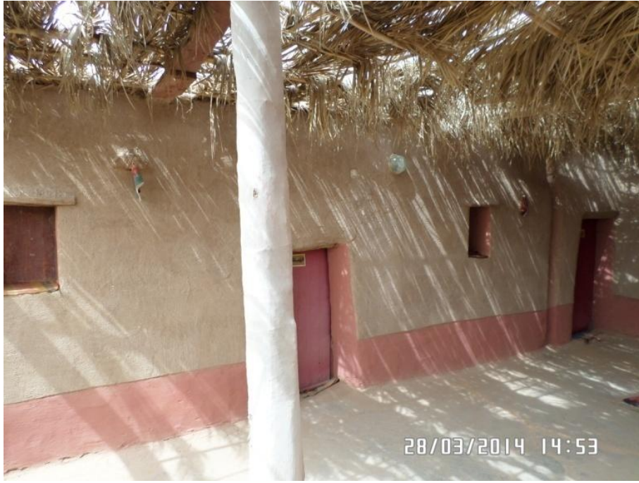
الصورة رقم 65 : سطح منزل النموذج الول بقصر تاغيت ( عن الطالب)
