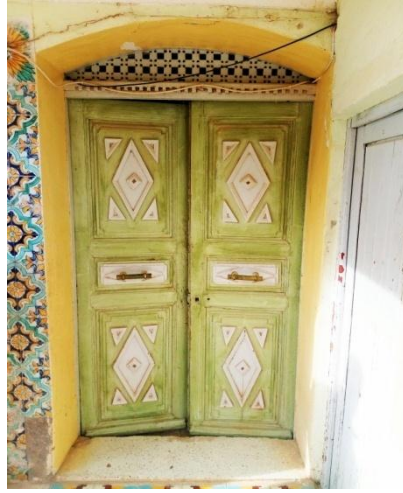
صورة2: المدخل الشرقي المسجد الجديد
