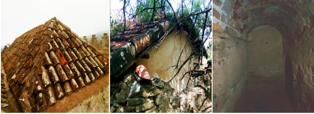
صورة 4: تسقيف برميلي س يعقوب صورة 5: تسقيف جملوني بقرومة صورة 6: تسقيف جملوني بسيدي يعقوب
