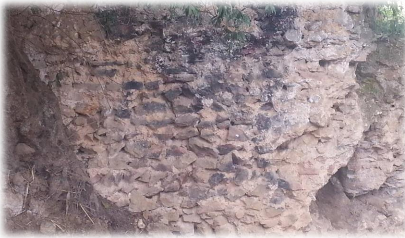
الصورة رقم 58: تقنية الأنسرتوم في جدار البناية. (من عمل الطالبة).
