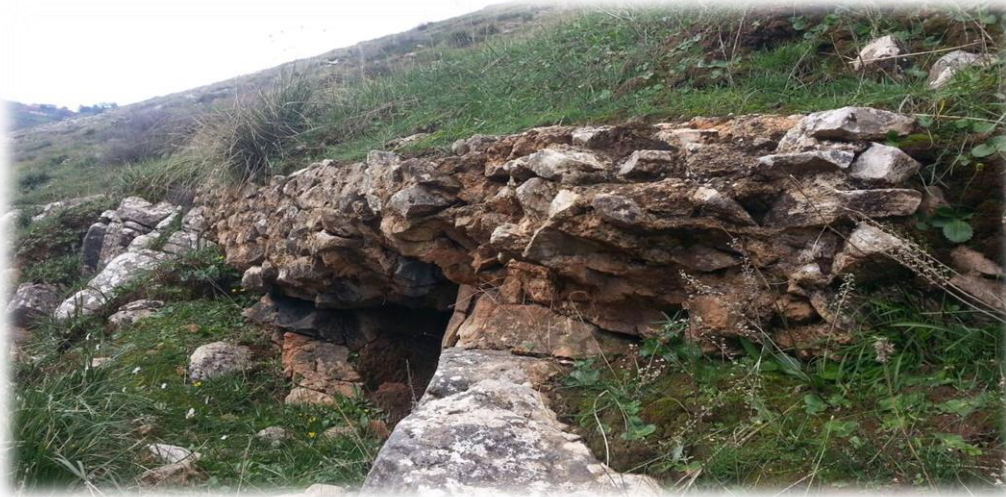
الصورة رقم 70: تقنية بناء القناة مع الحجارة الداعمة لها في مقطع آخر. (من عمل الطالبة).
