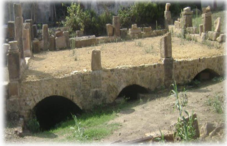
الصورة رقم 161: خزانات تيقزيرت (عن عمل الطالبة)
