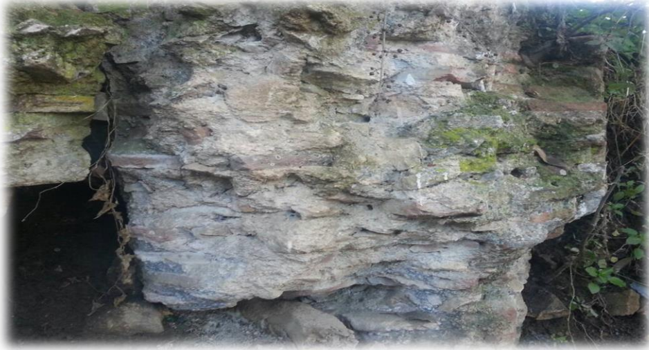
الصورة رقم 119: إستعمال التوفا في أحد خزانات المياه بجمعة صحاريج (عن عمل الطالبة).
