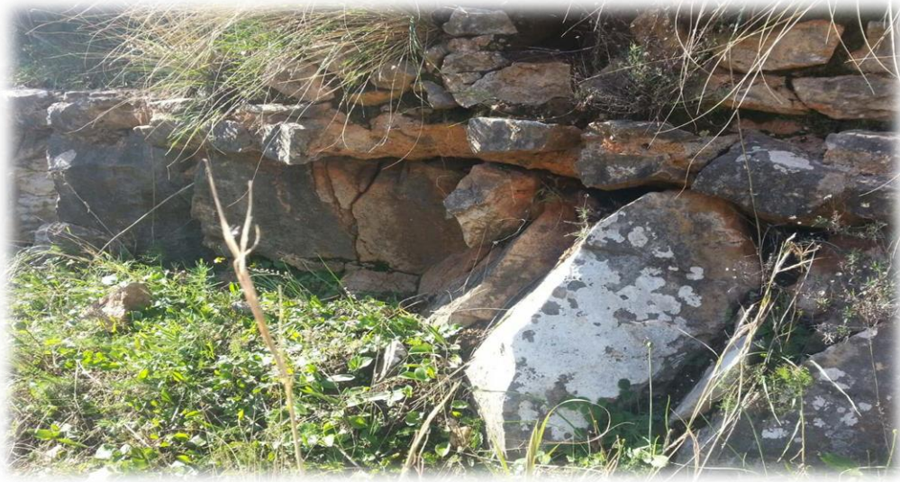
الصورة رقم 69: تقنية بناء القناة مع الحجارة الداعمة لها. (من عمل الطالبة).
