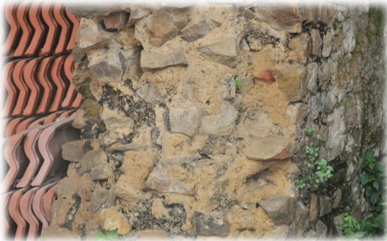
الصورة رقم 132: إستخدام الملاط بخزانات المياه بأزفون (عن عمل الطالبة).
