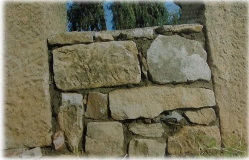
الصورة رقم 29: التقنية الإفريقية في الغرف الغربية بعد عملية الترميم. (من عمل الطالبة)
