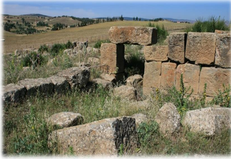
الصورة رقم 140: جدران مدينة رايبدوم بتقنية الحجارة المنحوتة (عن عمل الطالبة).
