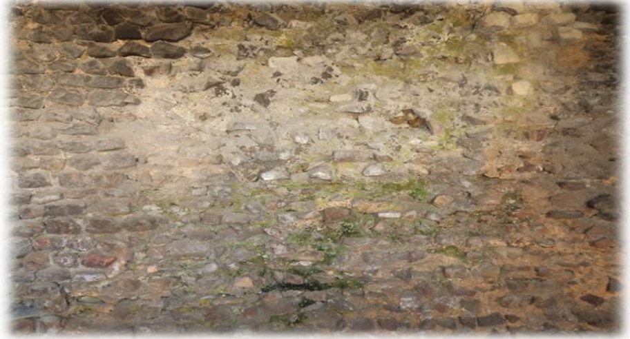
الصورة رقم 116: إستعمال التوفا في صهاريج مدينة أزفون (عن عمل الطالبة).
