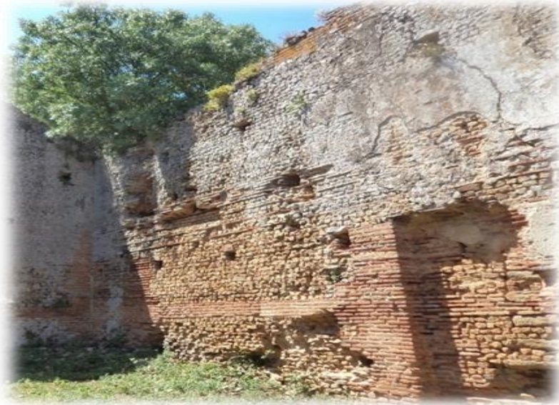
الصورة رقم 120: إستعمال الآجر في بناء الحمامات الكبرى بأزفون (عن عمل الطالبة).
