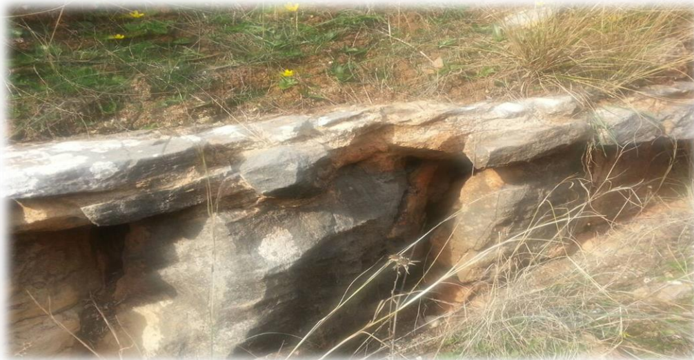
الصورة رقم 71: تقنية بناء القناة مع الحجارة الداعمة لها من الجهة الأخرى. (من عمل الطالبة).
