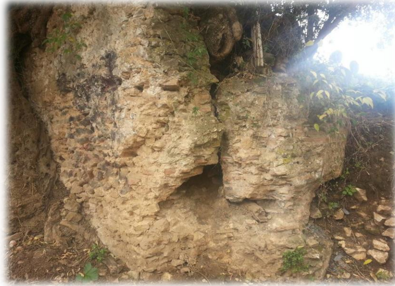
الصورة رقم 55: بقايا البناية (برج المراقبة). (من عمل الطالبة).
