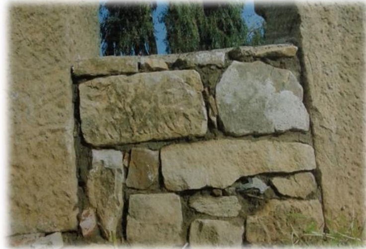
الصورة رقم 147: التقنية الإفريقية في الغرف الغربية لحمامات تيقزيرت (عن عمل الطالبة).
