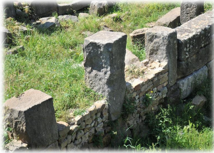
الصورة رقم 146: التقنية الإفريقية في جدران منازل مدينة تيقزيرت (عن عمل الطالبة).
