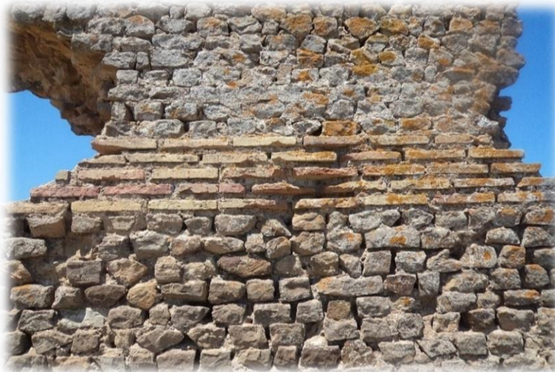
الصورة رقم 121: إستعمال الآجر في بقايا الكنيسة بتاقسابت (عن عمل الطالبة).
