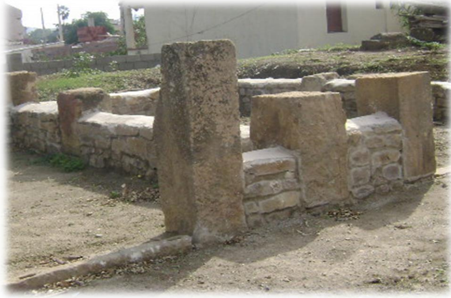
الصورة رقم 31: تقنية الكوادراتوم بالغرف الشرقية للحمامات. (من عمل الطالبة)
