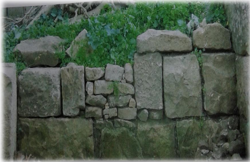
الصورة رقم 30: تقنية النظام الكبير بالجدار الجنوبي للصحاريح (من عمل الطالبة).
