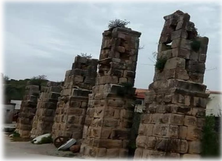
الصورة رقم 156: أعمدة جسر قناة توجة (عن عمل الطالبة).
