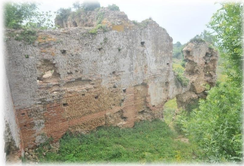
الصورة رقم 150: التقنية المركبة في حمامات أرفون (عن عمل الطالبة).
