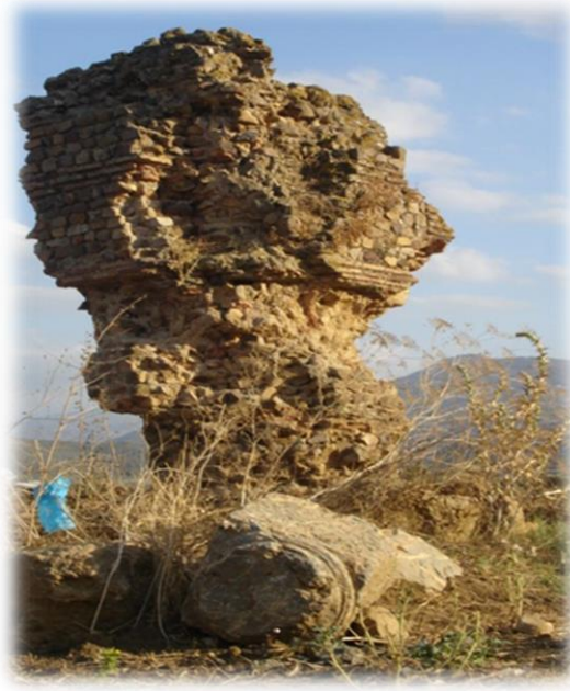
الصورة رقم 91: بقايا لضريح بضواحي تكلات (من عمل مديرية الثقافة لولاية بجاية).
