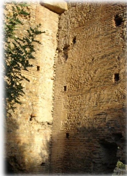
الصورة رقم 149: بناء جدران حمامات توبوسوكتو بالتقنية القائمة على الآجر (عن عمل الطالبة).
