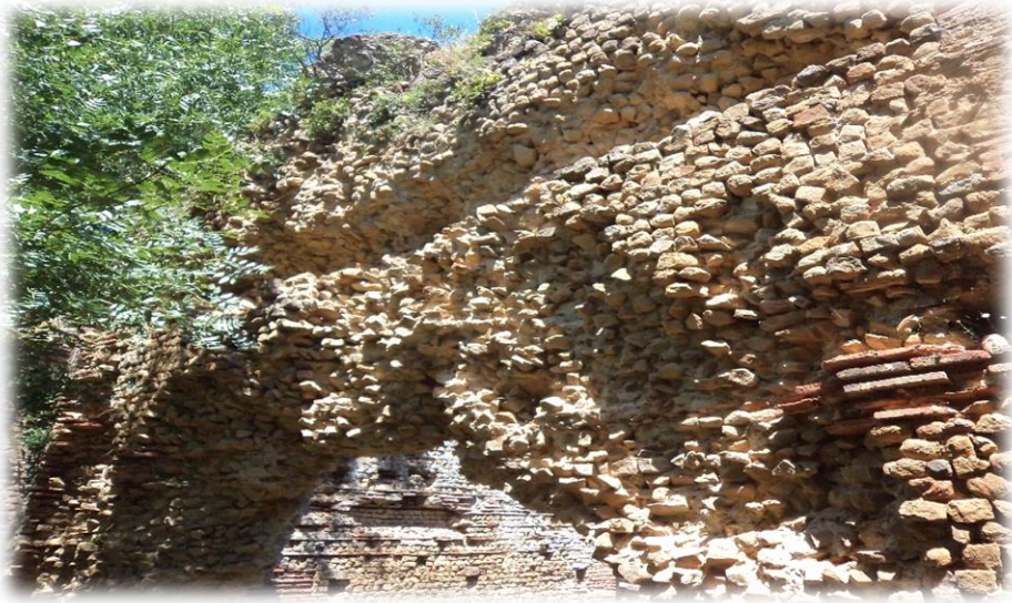
الصورة رقم 115: إستعمال التوفا في الحمامات الكبرى بأزفون (عن عمل الطالبة).
