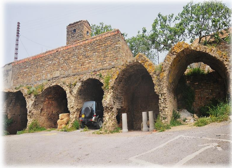
الصورة رقم 162: خزانات المياه بأزفون (عن عمل الطالبة)
