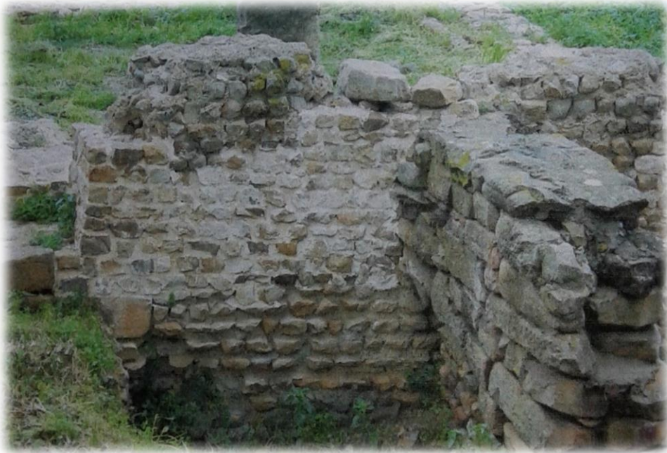
الصورة رقم 33: الممرات الحرارية في الغرف الغربية (من عمل الطالبة).
