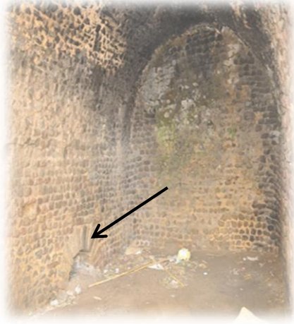
الصورة رقم 53: أحد خزانات المياه بأزفون. الصورة رقم 54: الفتحة الرابطة بين الخزانات.
