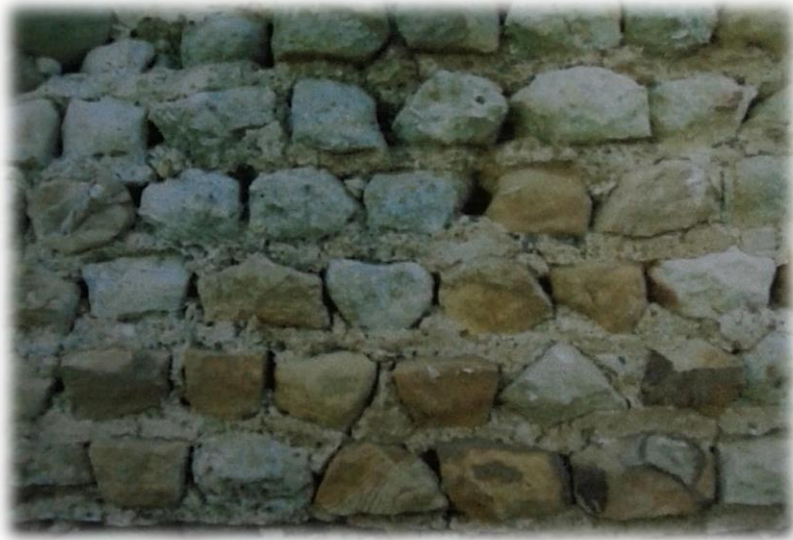
الصورة رقم 28: تقنية الأنسرتوم في الغرف الغربية (من عمل الطالبة).
