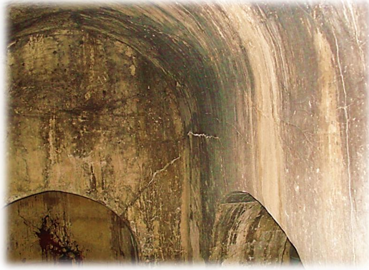
الصورة رقم 173: مبنى مكتشف ببجاية يظهر نظام التسقيف المقرب (خزانات للمياه) (عن عمل الطالبة).
