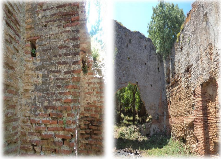
الصورة رقم 148: إستخدام التقنية القائمة على الآجر في بناء حمامات مدينة أزفون (عن عمل الطالبة).
