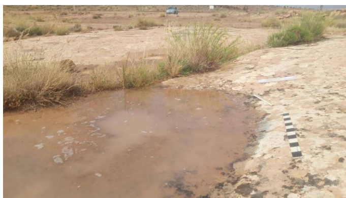
(الصورة رقم : 3 تمثل ركود مياه الأمطار فوق الجدارية )
