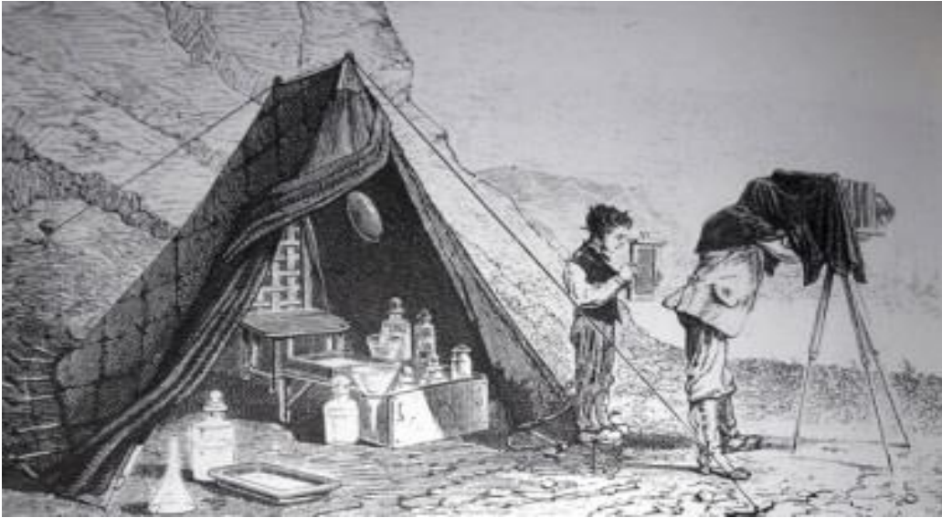
الشكل 07: ورشة عمل المصور في الميدان، حوالي عام 1850م، يعود النقش إلى القرن التاسع عشر. استخدام الكولوديون الرطب يتطلب وجود مخبر التصوير الفوتوغرافي بالقرب من مكان التقاط الصورة.
