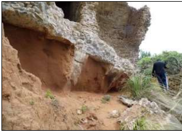
صورة تبين تآكل أرضية الخزان الرملية
