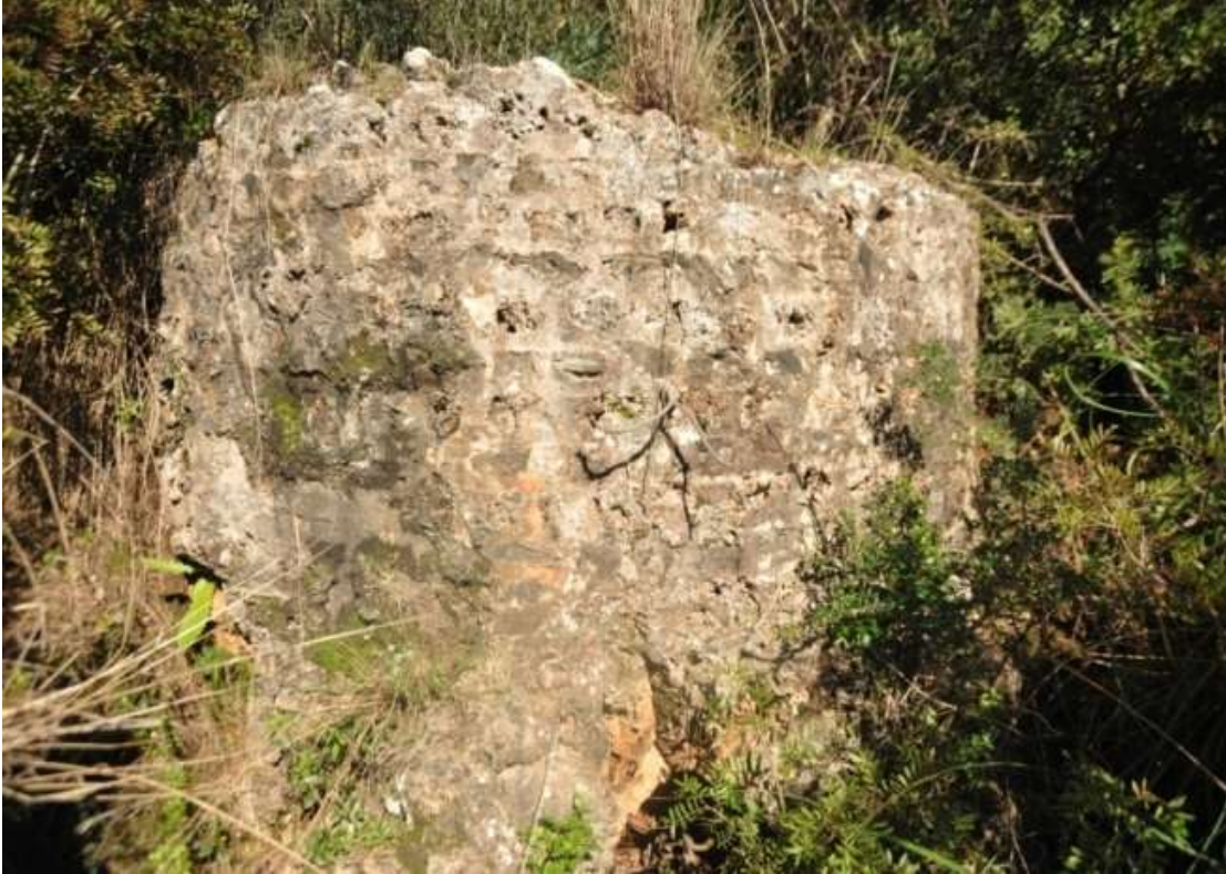
صورة ب 26 جانبية لبئر متصل بقناة لنقل المياه
