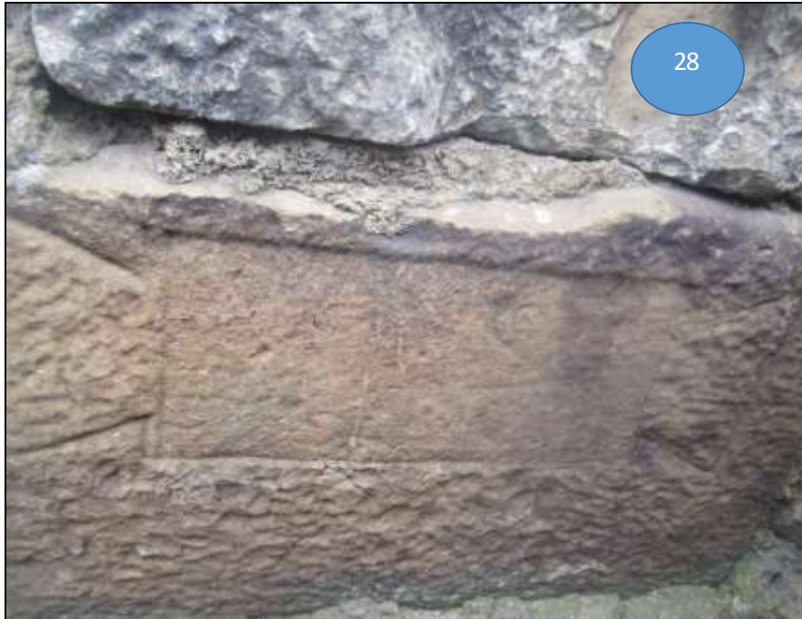
الصورة 27 و28: بعض الحجارة والنقيشات التي أعيد استعمالها في المباني الجديدة بحي الخربة.
