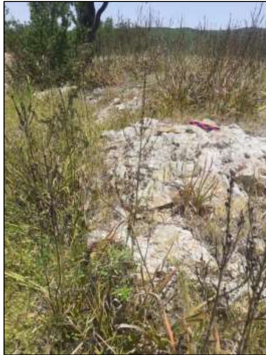
الصورة ب 39 تمثل سطح الخزان الموجود تحت الأرض
