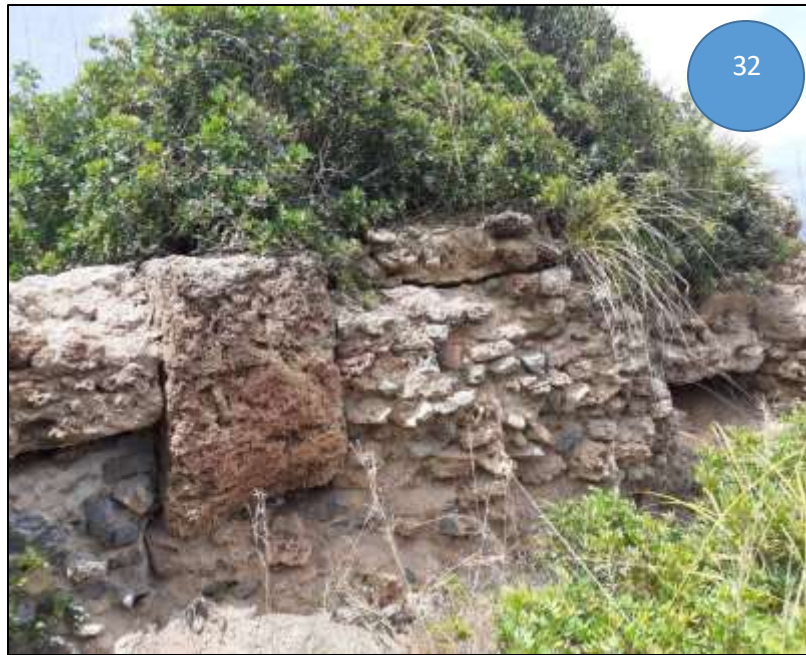
الصورتان 31،32: منظر لكتلة من المباني بموقع وادي ببيبي، وجدار بتقنية النظام الافريقي
