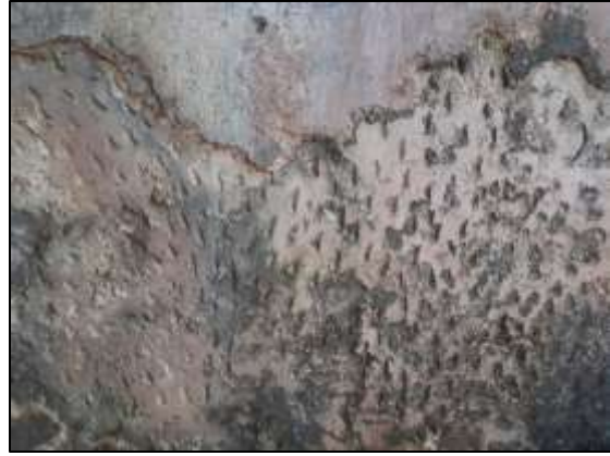
صورة ب 13 تهيئة الجدار للتلبس عن طريق النقر
