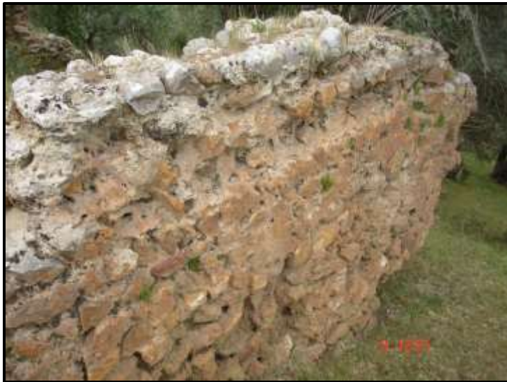
الصورة ب: تقنية الملء remplissage التي بنيت بها جدران الأبنية.
