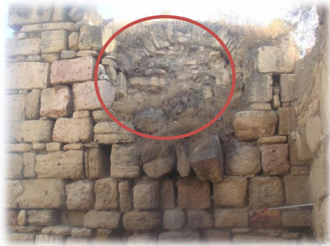
صورة (159): انزلاق التربة و الحجرة جراء مرور الشاحنات
