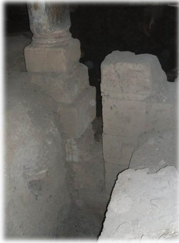
صورة (141): بناء الأساسات
