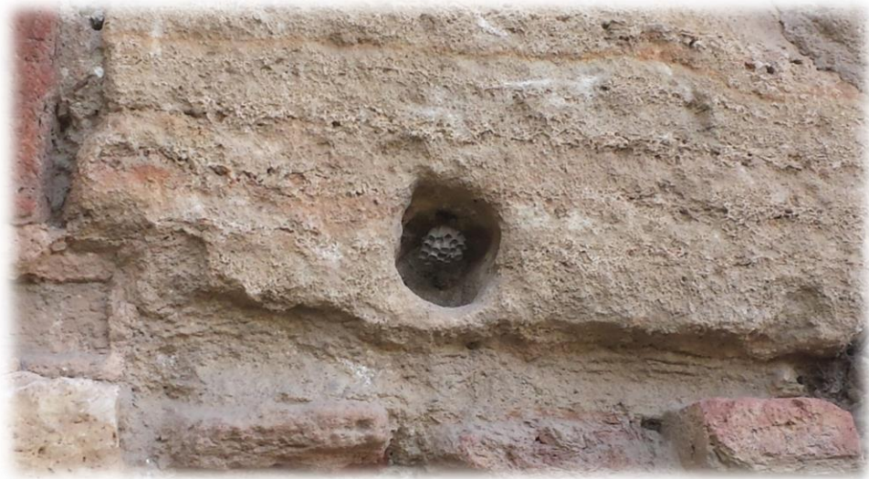
صورة (173) : التآكل النخري
