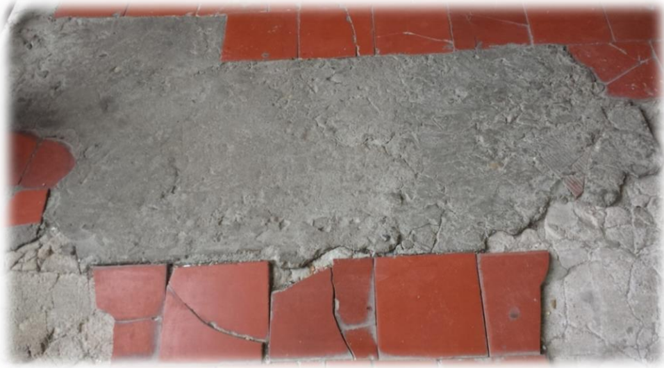
صورة (169):سوء الترميم أو ما يعرف بسياسة الترقيع
