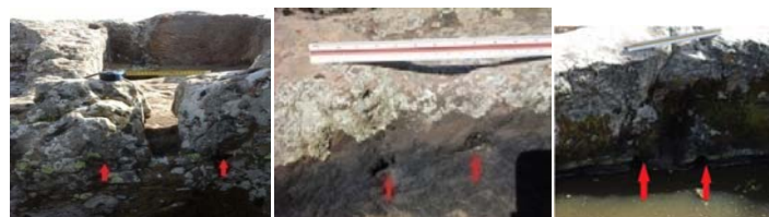
Fig.18 : Les creux de la paroi intérieure des bassins sous les orifices de vidange, pressoirs des sites n° 07,08,14.
