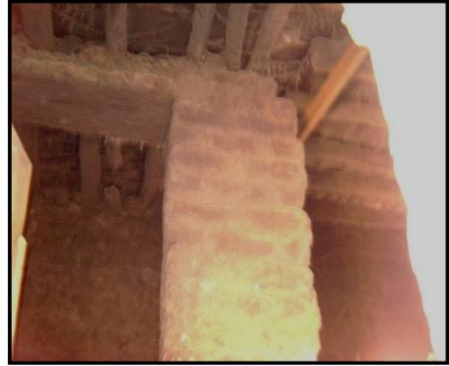
06/ا- دعامات لتقوية أسوار المبنى
