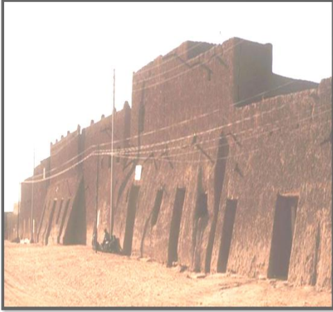
06/ب- دعامات لتوسعة الغرف (السواري) ورفع السقف
