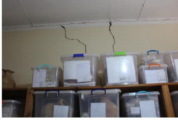
صورة رقم 57: اثر الزلزال على المبنى
