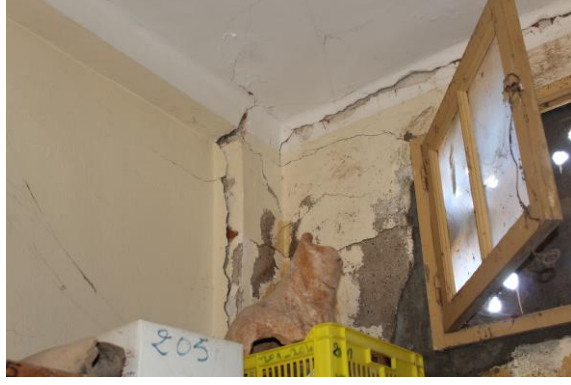
صورة رقم 58: ثقوب وتشققات في المبنى
