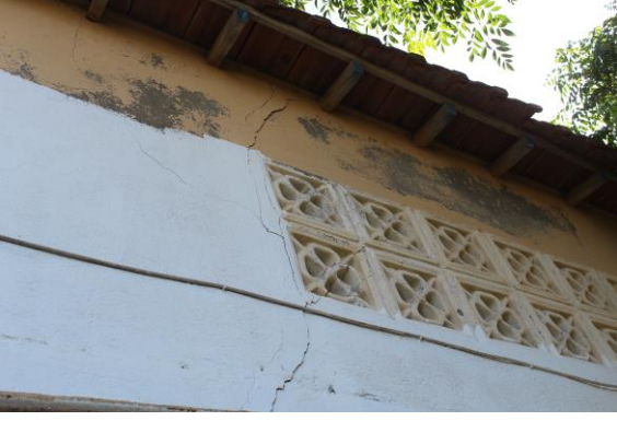
صورة رقم 57: اثر الزلزال على المبنى
