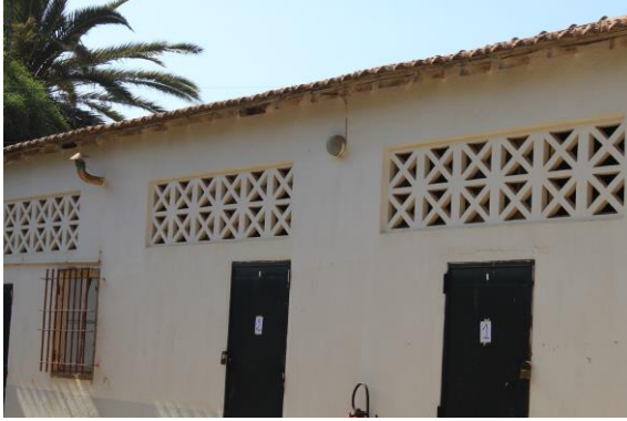
الصورة رقم 32: نظام التهوية بالشبابيك
