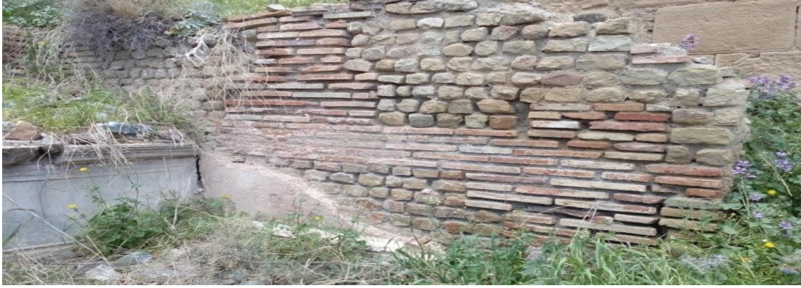
الصورة 127: صورة للجدار الغربي للمعبد مبني بالتقنية المختلطة وبه آثار لصق الرخام
