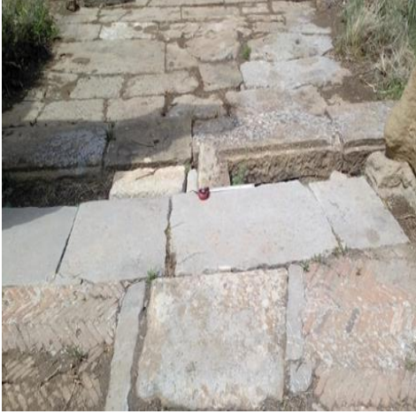
الصورة 104: قناة صرف تحت الجدار الخاص بواجهة الساكراريوم
