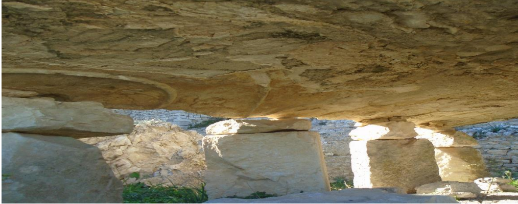
صورة رقم 51: سقف القاعة المركزية
