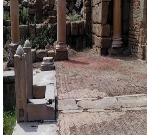
صورة 103: قناة صرف شمالية للحوض (الرواق الشمالي للحوض)
