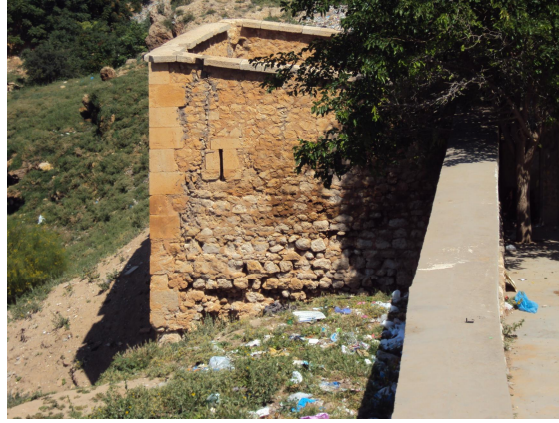
الصورة رقم (08): بقايا برج مراقبة بالسور الجنوبي لمدينة معسكر خلال الفترة الحالية
