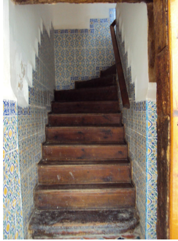
الصورة رقم (123): سلم المحكمة بعد الترميم الأول
