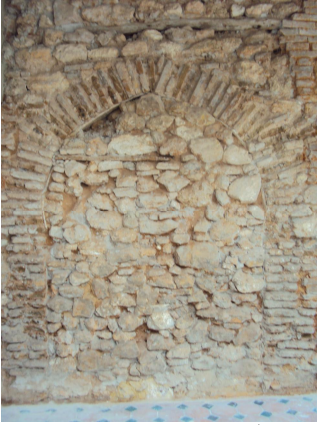
الصورة رقم (124): الشكل الأصلي لأبواب حجرات المحكمة يظهر خلال عملية الترميم الثانية وهو مسدود
