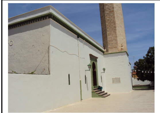
الصورة رقم (41): الواجهة الرئيسية لجامع عين البيضاء
