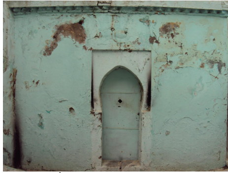
الصورة رقم (72): الواجهة الرئيسية لضريح سيدي بوسكرين
