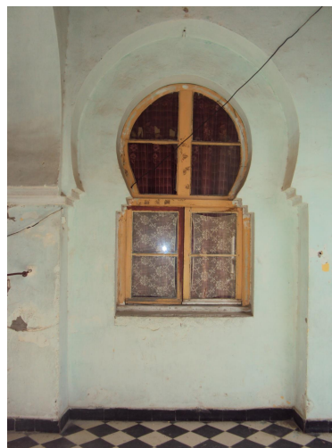
الصورة رقم (111): نموذج من نوافذ منزل الميزابي
