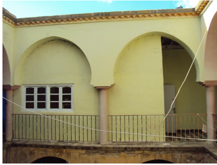
الصورة رقم (110): غلق الرواق الغربي بالطابق العلوي في منزل الميزابي
