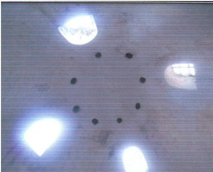
الصورة رقم (131): طريقة التهوية والإضاءة في القاعة الساخنة بحمام البركة
