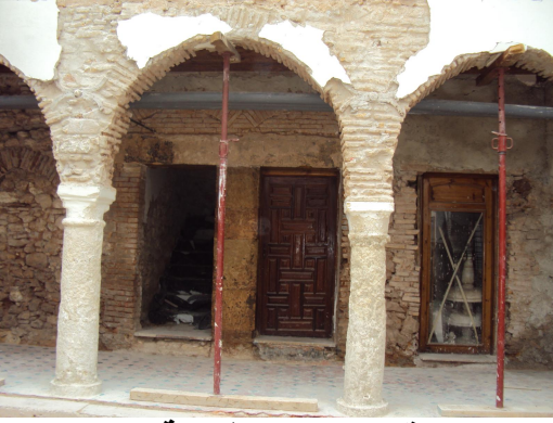
الصورة رقم (119): طريقة بناء العقود والجدران بالمحكمة تظهر خلال الترميم الثاني
