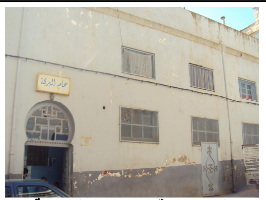
الصورة رقم (125): الواجهة الرئيسية لحمام البركة
