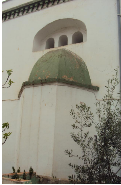
الصورة رقم (52): المظهر الخارجي لمحراب جامع عين البيضاء
