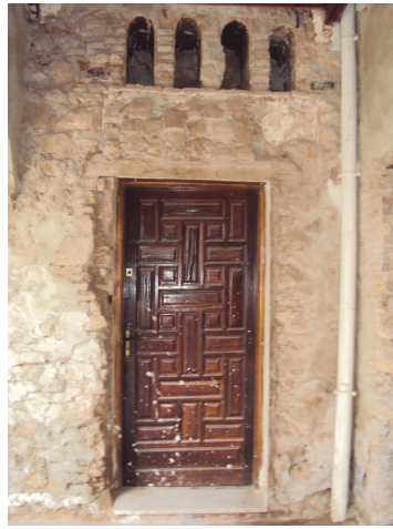
الصورة رقم (120): شمسيات الحجرة الثانية التي طمست بعد الترميم الأول تظهر خلال عملية الترميم الثاني
