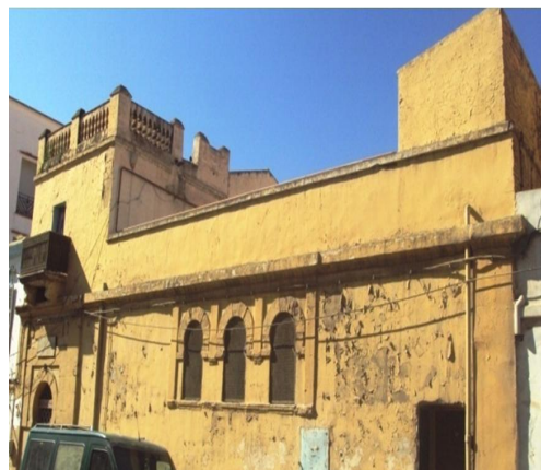
الصورة رقم (157): الواجهة الرئيسية لحمام الباي (الازدهار)
