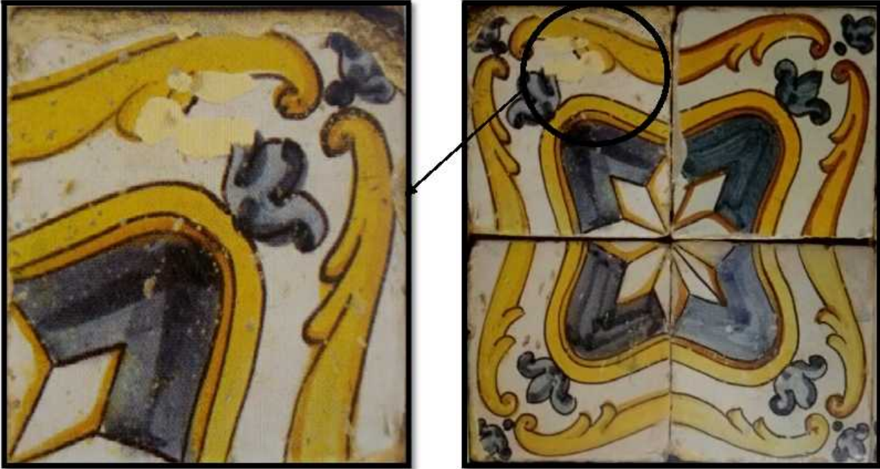
صور (43) توضح ظاهرة تقشر سطح بلاطات الزليج.
