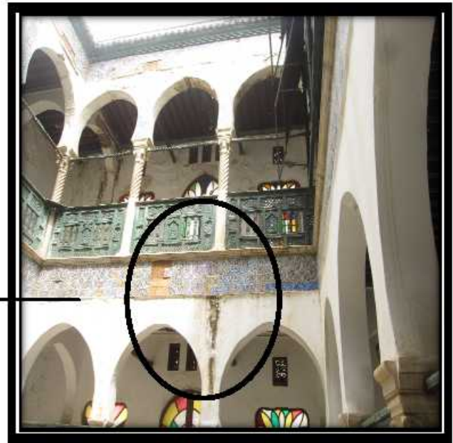
صورة (52) تظهر آثار السيول التي تسقط بعض واجهات البلاطات.
