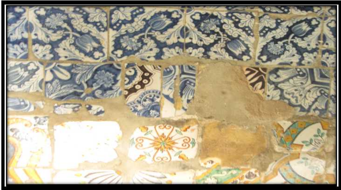
صورة (49) تبين استعمال الاسمنت في عمليات الترميم.
