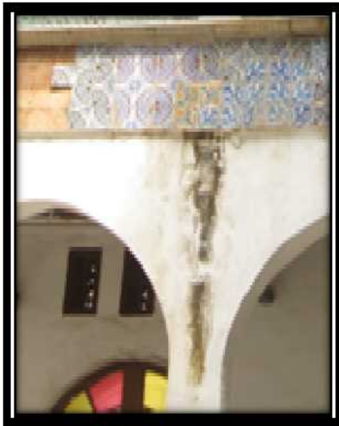
صورة (52) تظهر آثار السيول التي تسقط بعض واجهات البلاطات.
