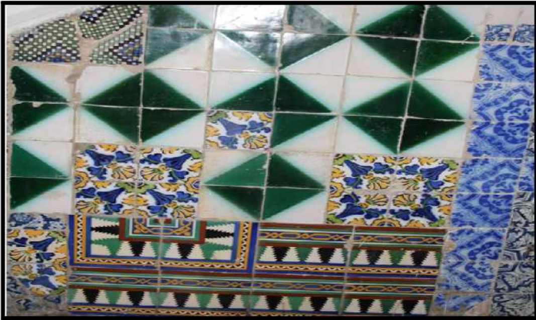
الصورة(48) تبين الترميم الخاطئ الوضع العشوائي للمربعات الخزفية.
