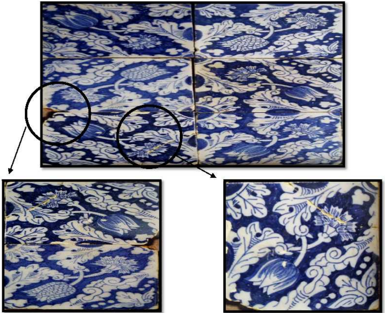
الصور (44) تبين مظاهر تشقق وتكسر بلاطات الزليج.
