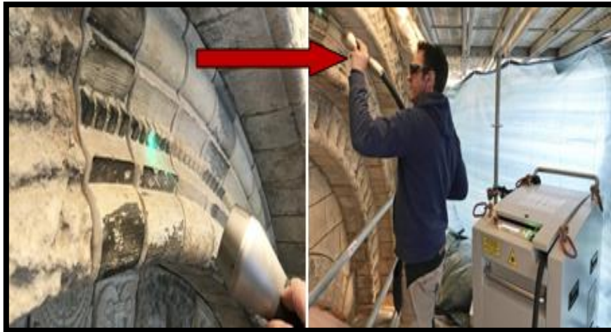
الصورة 04: التنظيف بآلة الليزر
