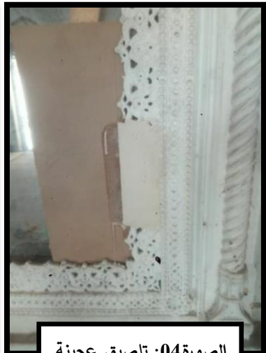
الصورة 04: تلصيق عجينة الجص
