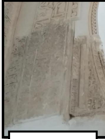
الصورة 02: نوعين من الترميم بعقد الغربي ببيت الصلاة
