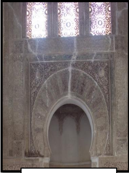
الصورة 02: شقوق بمحراب مسجد أبي الحسن قد تم ترميمها
