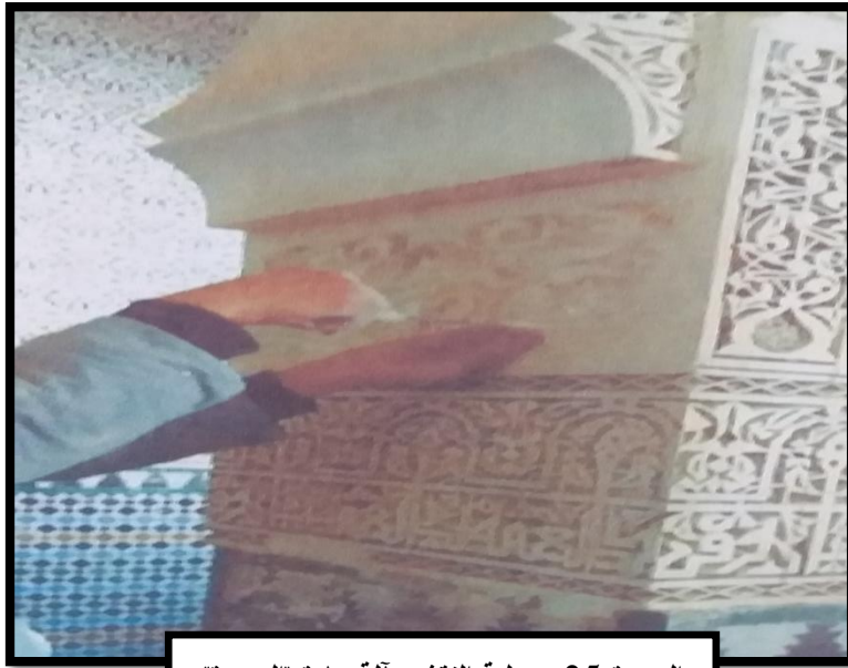
الصورة 25: عملية النقش بآلة حادة "الحديدية"
