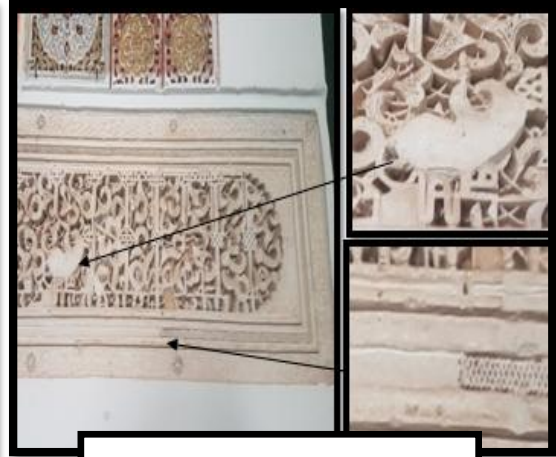
الصورة 01: ترميم الزخارف وتوقيف التلف بالمحراب
