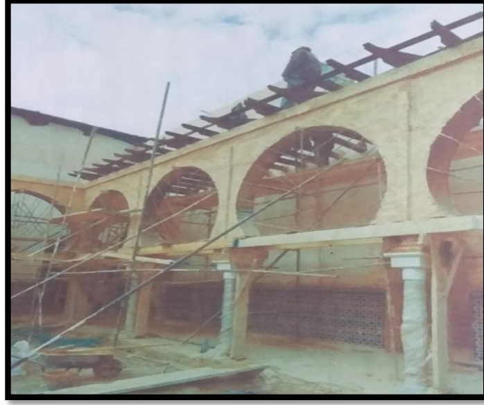
الصورة 23: تقنية بناء العقود الحدودية
