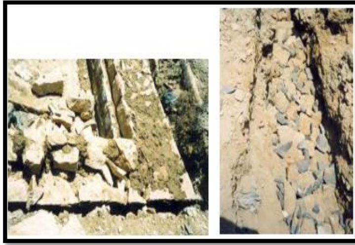
الصورة 22: طريقة إنشاء الأساسات قديما
