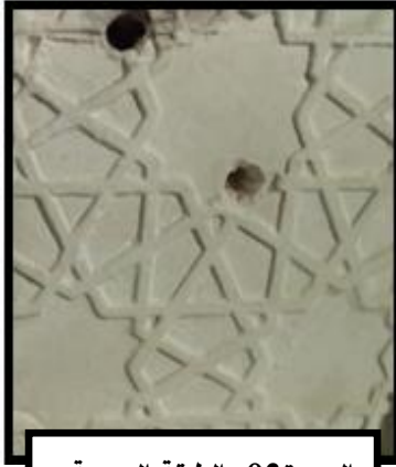
الصورة 03: الطبقة الجصية الأصلية بعد التنظيف
