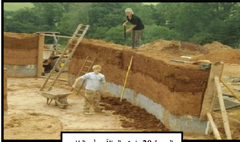
الصورة 20: استعمال الآجر في البناء
