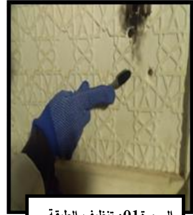
الصورة 01: تنظيف الطبقة الخارجية بالماء والفرشاة
