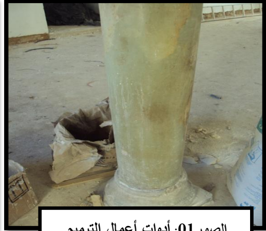
الصورة 01: أدوات أعمال الترميم داخل قاعة الصلاة
