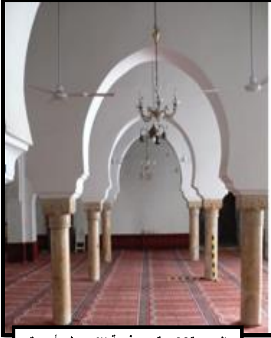
الصورة02: عقود حدوية تتكى على أعمدة رخامية
