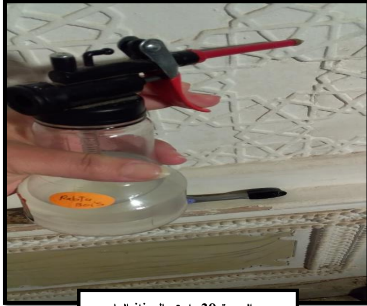
الصورة 39: استعمال رذاذ الماء للتنظيف
