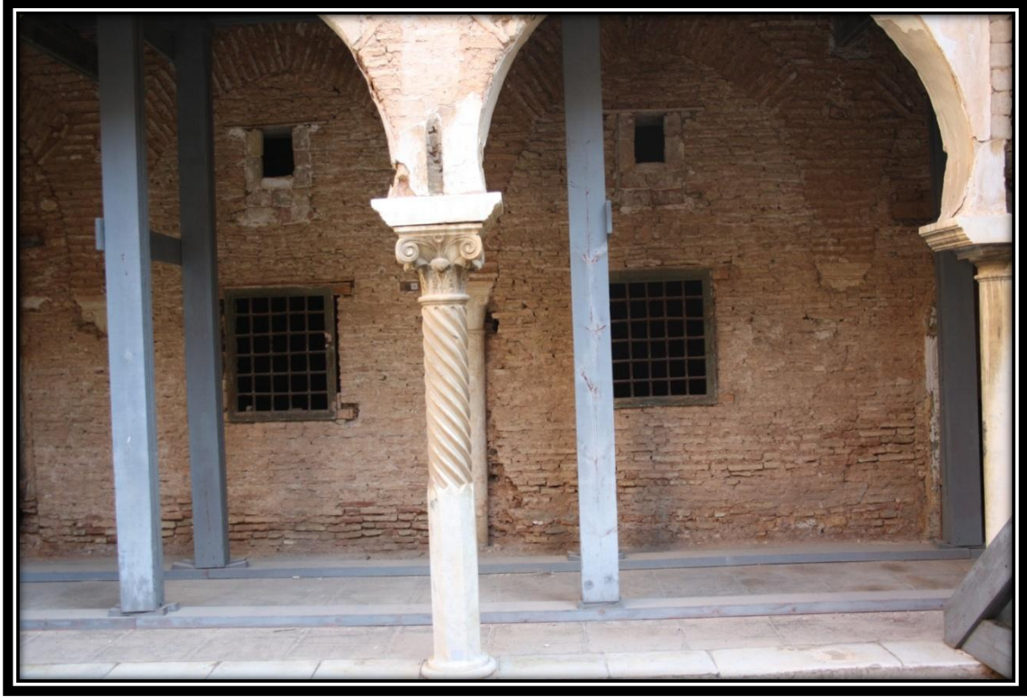
صورة رقم 7: الاضرار الاحقة بالاعمدة المركبة...
