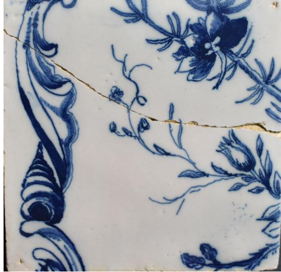
الصورة رقم 29: تشقق وتكسر المربعات الخزفية
