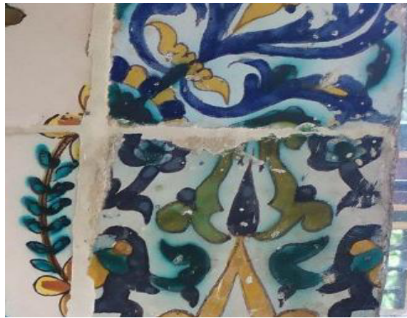
الصورة رقم 28: تقشر سطح التزجيج
