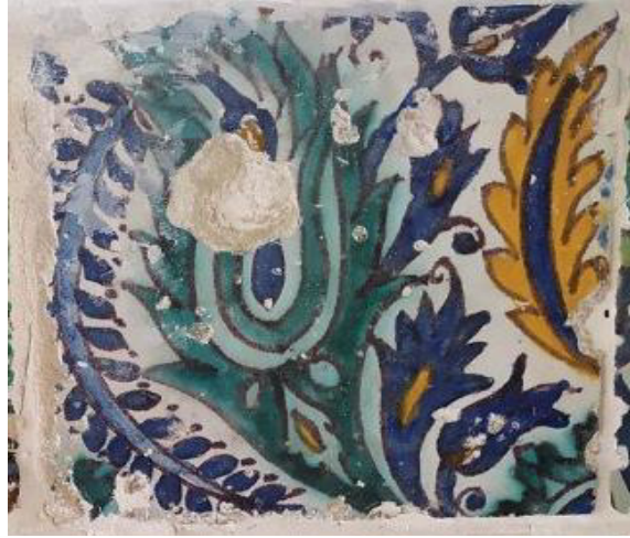
الصورة رقم 27: التفتت الحبيبي للمربعات الخزفية
