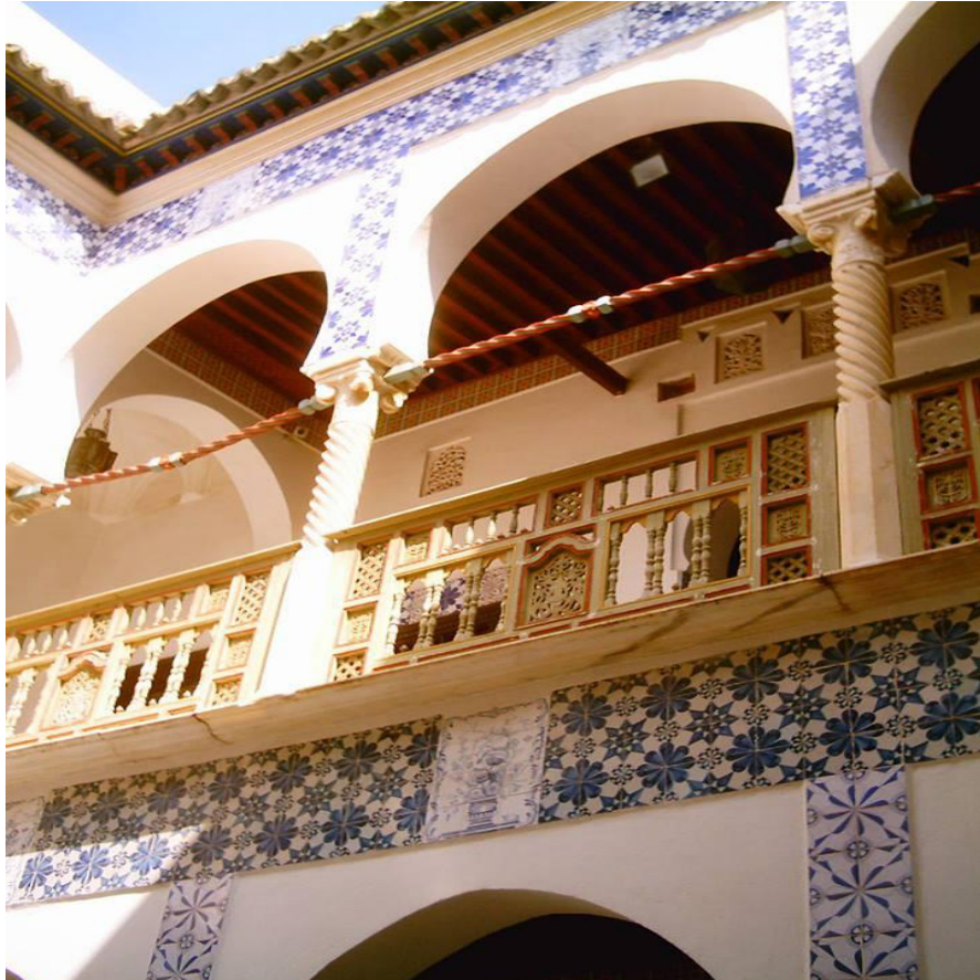
الملحق رقم 03: المربعات الخزفية بالواجهة المطلة على فناء الحصن 23
