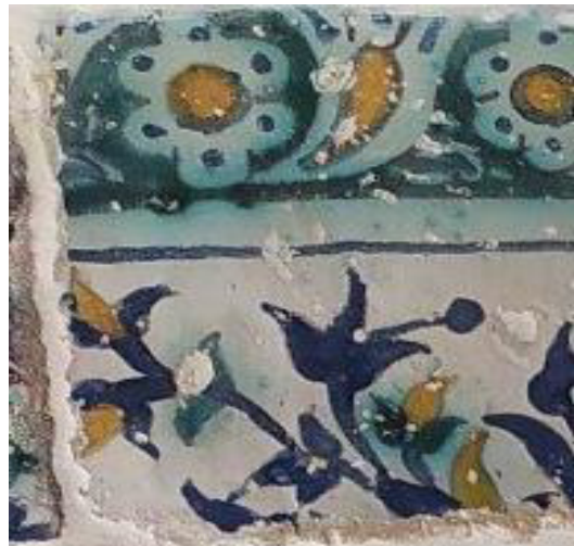
الصورة رقم 32: تبلور الأملاح بالمربعات الخزفية
