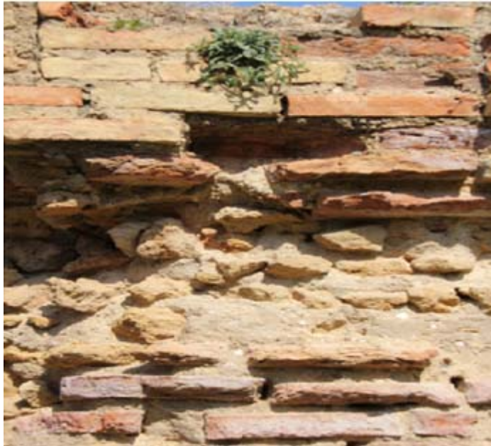
( الصورة رقم 70 ) ملاط خشن ممزوج بالحصى.
