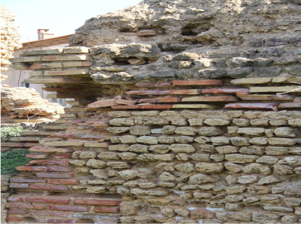
( الصورة رقم 43 ) : جدار بتقنية المزدوجة المتناوبة.
