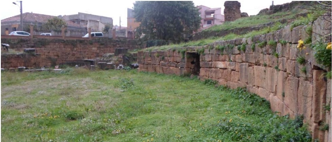
( الصورة رقم 80) استعمال الحجارة المصقولة دون ملاط.
