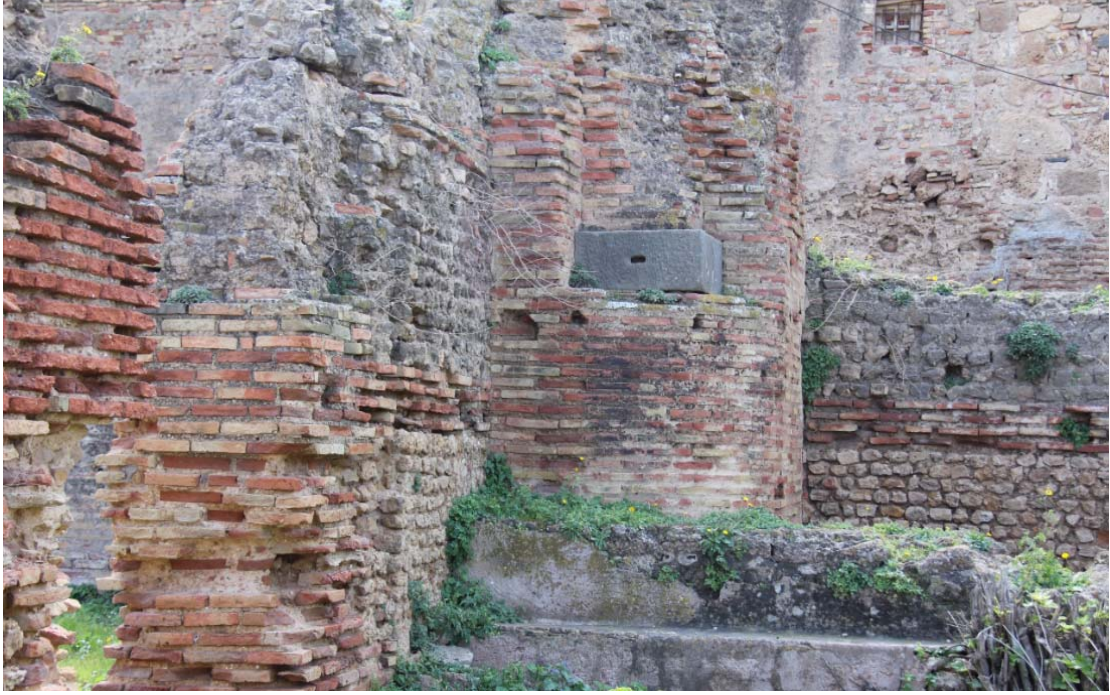
(الصورة رقم 74 ) جدار يجمع بين عدة تقنيات البناء في الحمامات الغربية .
