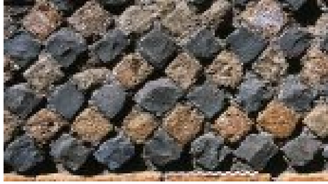
(الصورة رقم 15) جدار بتقنية المعينات (RETICULATUM)
