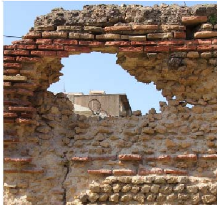
(الصورة رقم 71 ) جدار بتقنية المختلطة
