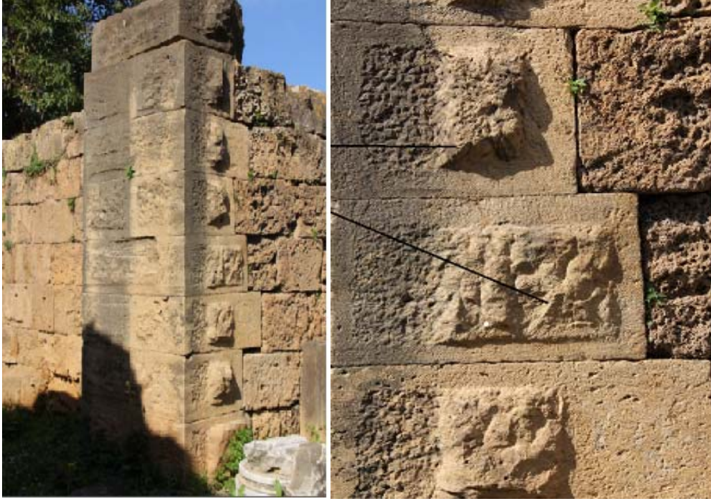
(الصور رقم 77- 78) نتوءات على الحجارة عند مدخل المسرح.
