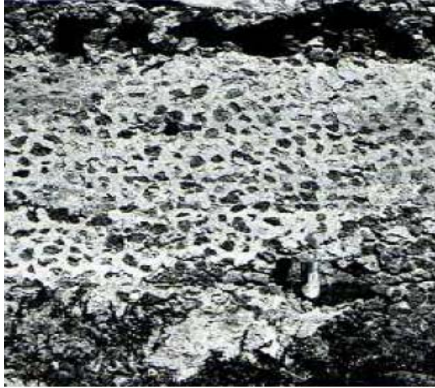
(الصورة رقم 14) جدار بالتقنية الغير منتظمة بمدينة " بومبيي " عن كتاب
