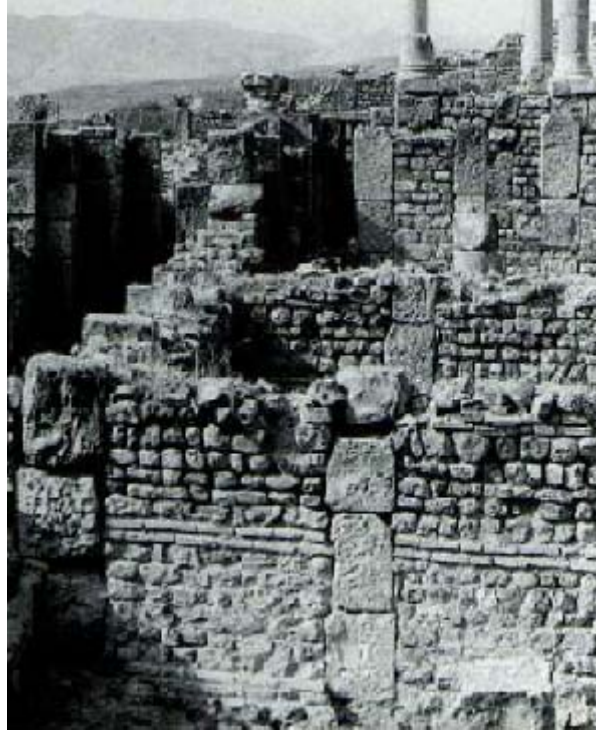
(الصورة رقم 19 ) جدران بالتقنية الافريقية بحي المنازل في مدينة جميلة
