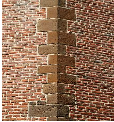
(الصورة رقم 20) بناء زاوية الجدار بحجارة منحوتة مستطيلة.
