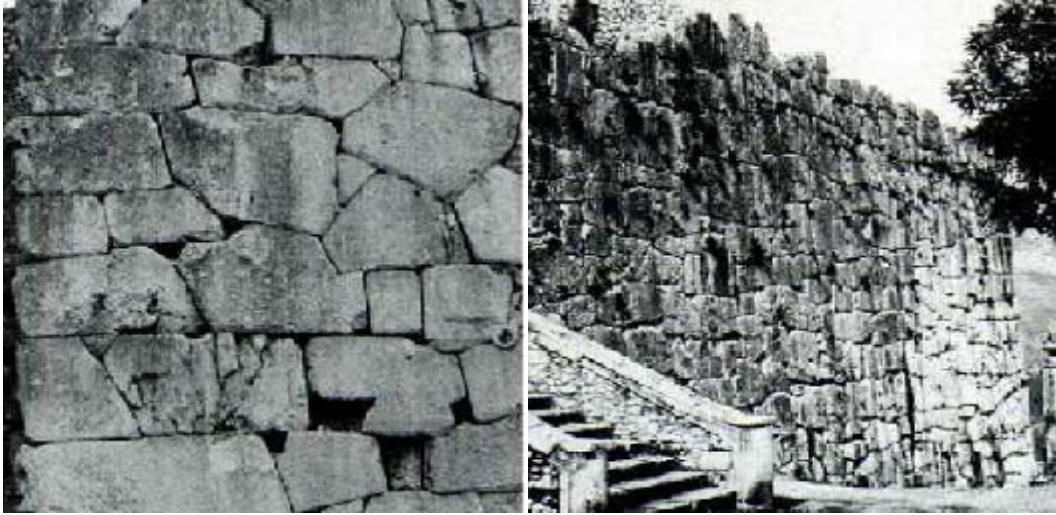
(الصور رقم 10 و 11) جدران بتقنية "السليسيوم" من كتاب LA CONSTRUCTION ROMAINE, p113 .
