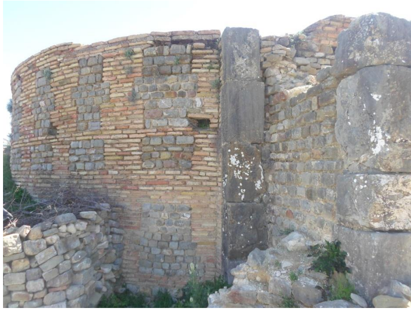
صورة رقم (03) التقنية الإفريقية المستعملة في الجدران الخارجية لبيت التعميد
