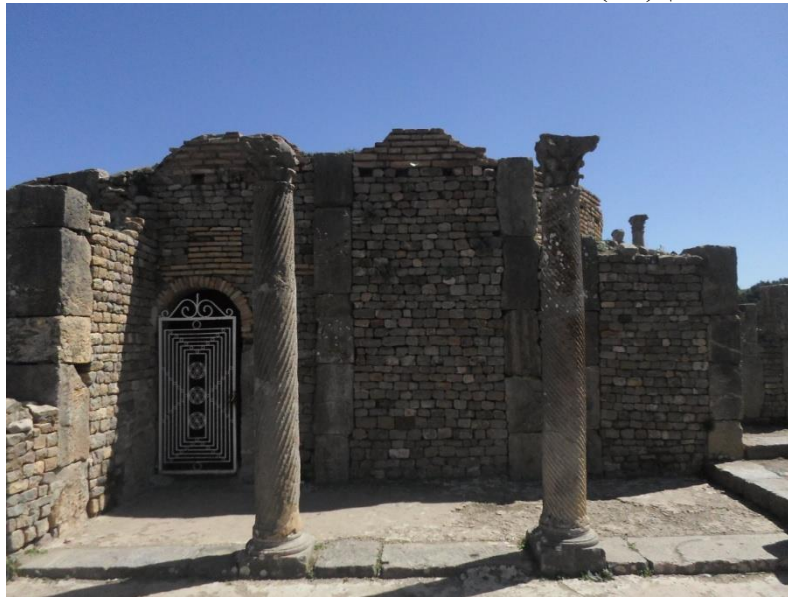
صورة رقم (16) المدخل الرئيسي لبيت التعميد
