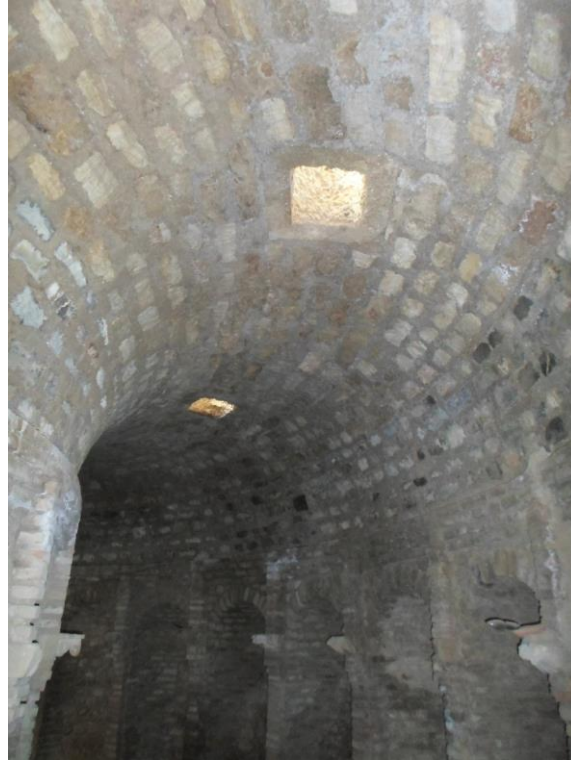
صورة رقم ( 12 ) : فتحات التهوية برواق بيت التعميد
