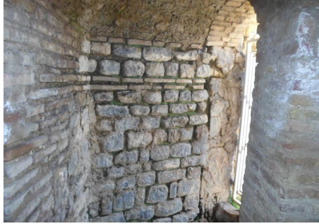
صورة رقم ( 13 ) : تقنية الججارة غير منتظمة في الجدران الداخلية بيت التعميد
