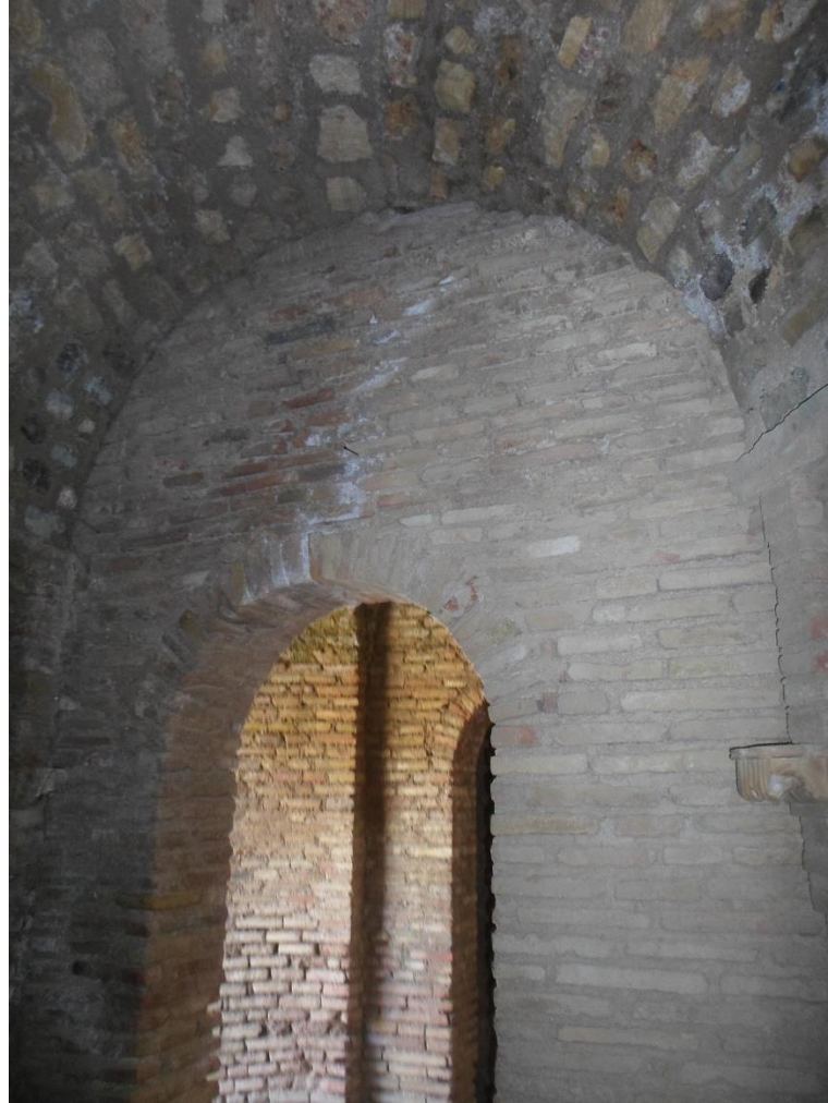
صورة رقم ( 14 ) : إحدى مداخل غرف بيت التعميد عن الطالب
