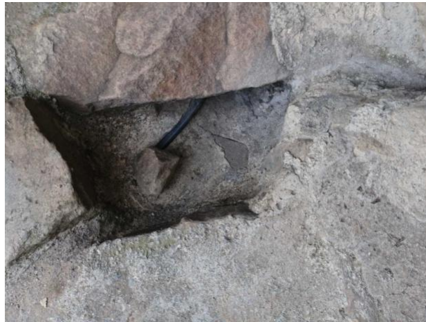
صورة 18: بلوعة لصرف المياه (تدعى تازوليكنت) (المصدر: عمل شخصي للطالبتين، سنة 2022)
