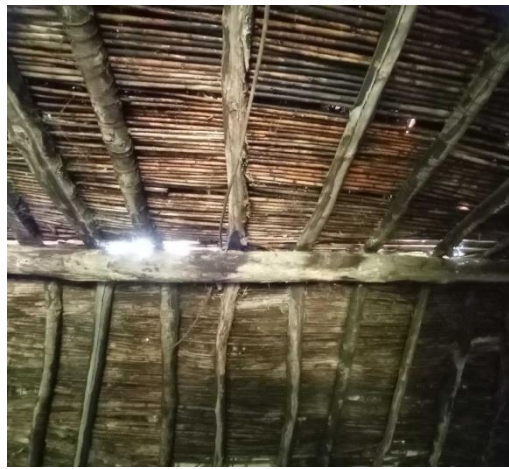
صورة 20: الجدار الحامل للسقف (يدعى أجفو ألماس) (المصدر: عمل شخصي للطالبتين، سنة 2022)
