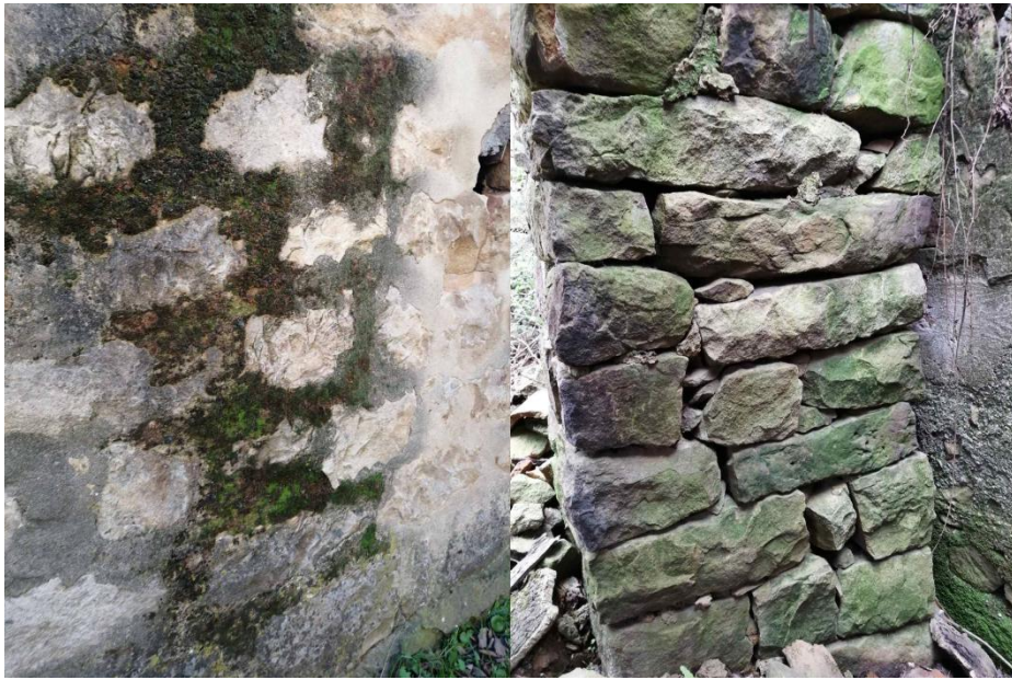
صورة 22: تغير لون حجارة البناء بالمسكن الريفي ببوزقن بمنطقة تيزي وزو (المصدر: عمل شخصي للطالبتين، 2022)
