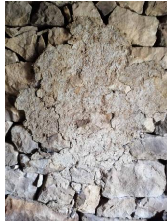
صورة 26: تقشر طلاء الجدران وانفصاله عن الحجارة (المصدر: عمل شخصي للطالبتين، 2022)
