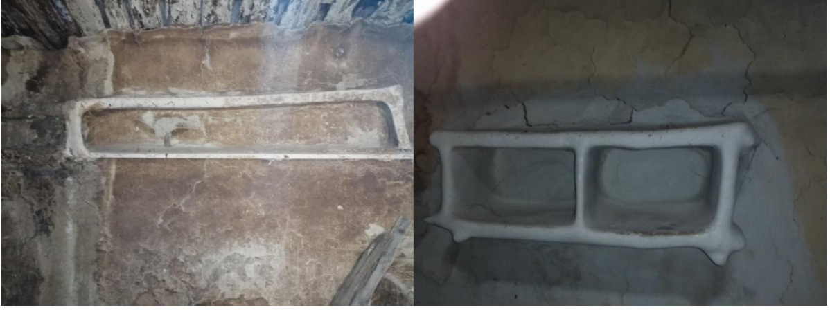
صورة 11: خزانة لحفظ الأواني المنزلية (تدعى المرفع) (المصدر: عمل شخصي للطالبتين، سنة 2022)
