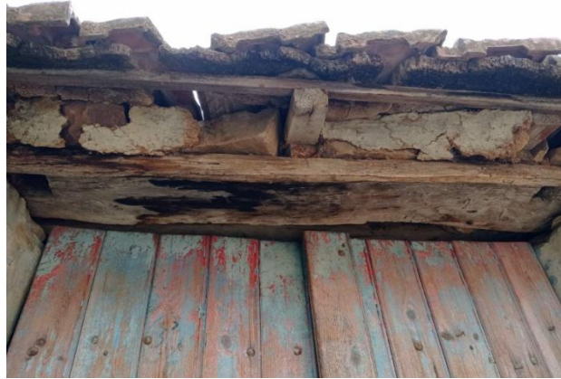
صورة 14: ساكف الباب الخارجي للمنزل (تدعى أقنضري) (المصدر: عمل شخصي للطالبتين، سنة 2022)
