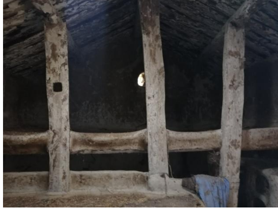
صورة 15: الدعامات العمودية لحمل السقف (تدعى تكجدا) (المصدر: عمل شخصي للطالبتين، سنة 2022)
