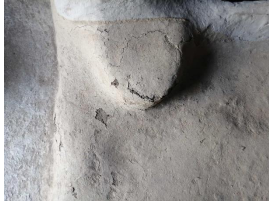
صورة 7: درجة صغيرة يستعان بها للصعود إلى غرفة النوم (تدعى ئاصدارث) (المصدر: عمل شخصي للطالبتين، سنة 2022)
