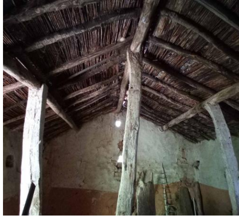
صورة 16: الروافد الأفقية لحمل السقف (تدعى اجقًا) (المصدر: عمل شخصي للطالبتين، سنة 2022)
