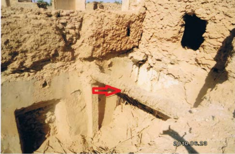
الصورة رقم (43): استعمال جذوع النخيل كعوارض خشبية في حمل السقف بمسكن وادي سوف (عن الطالب)
