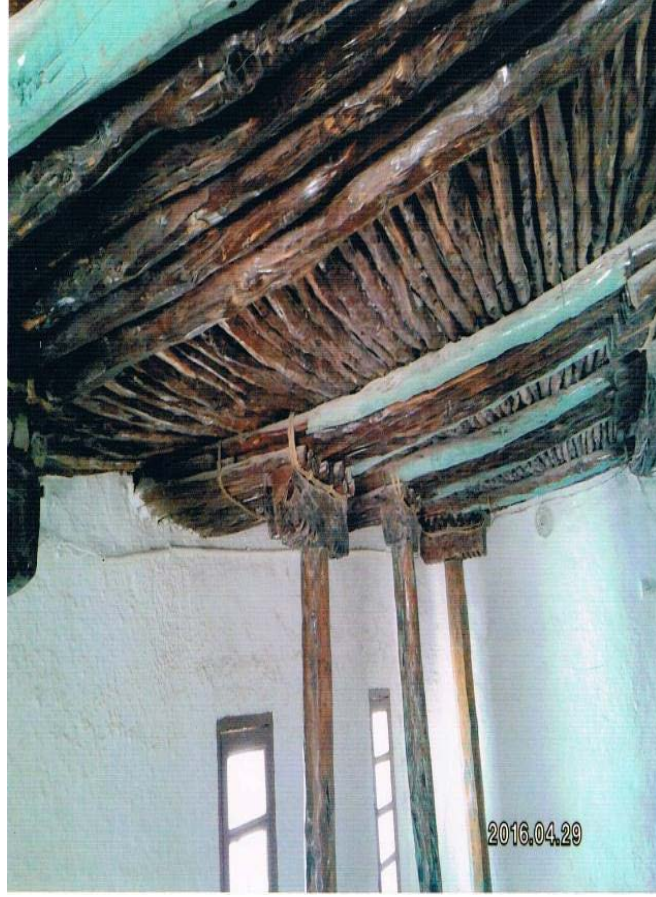
الصورة رقم (22): الأعمدة الحاملة للسقف مسكن بوسعادة
