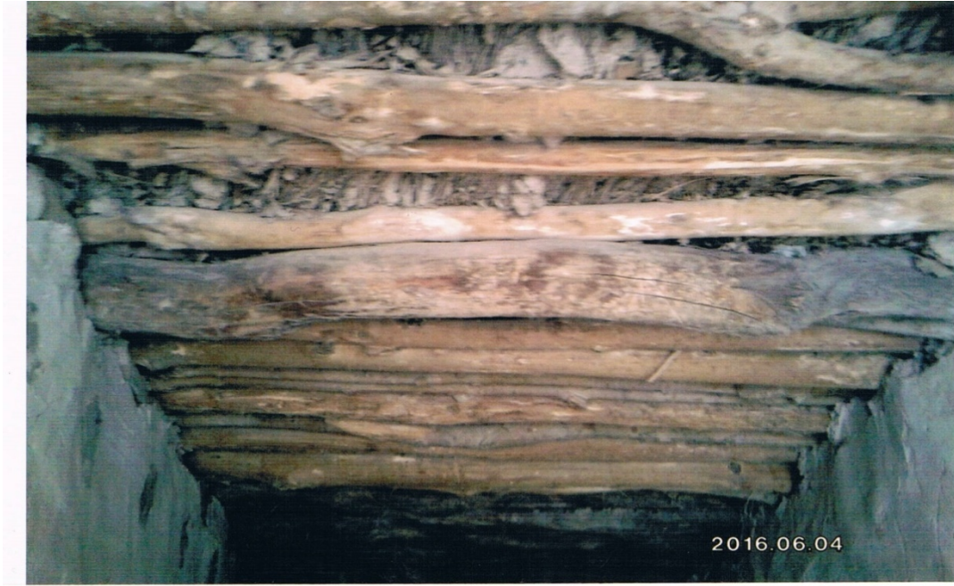
الصورة رقم (12): استخدام أغصان وسيقان الأشجار في نظام التسقيف بمسكن بوسعادة (عن الطالب)
