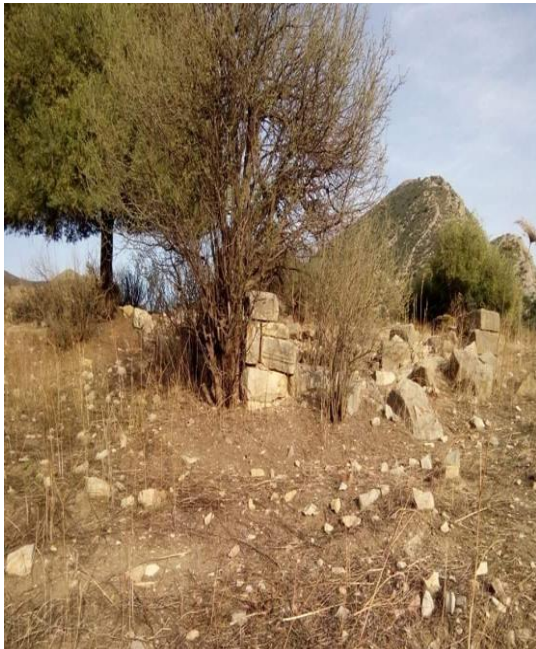
الصورة رقم 48 : بقايا بناية مهدامة
