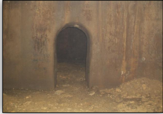
الصورة رقم 81: الفتحة المهيأة في الجدار الفاصل بين غرف الخزان تحت الارض
