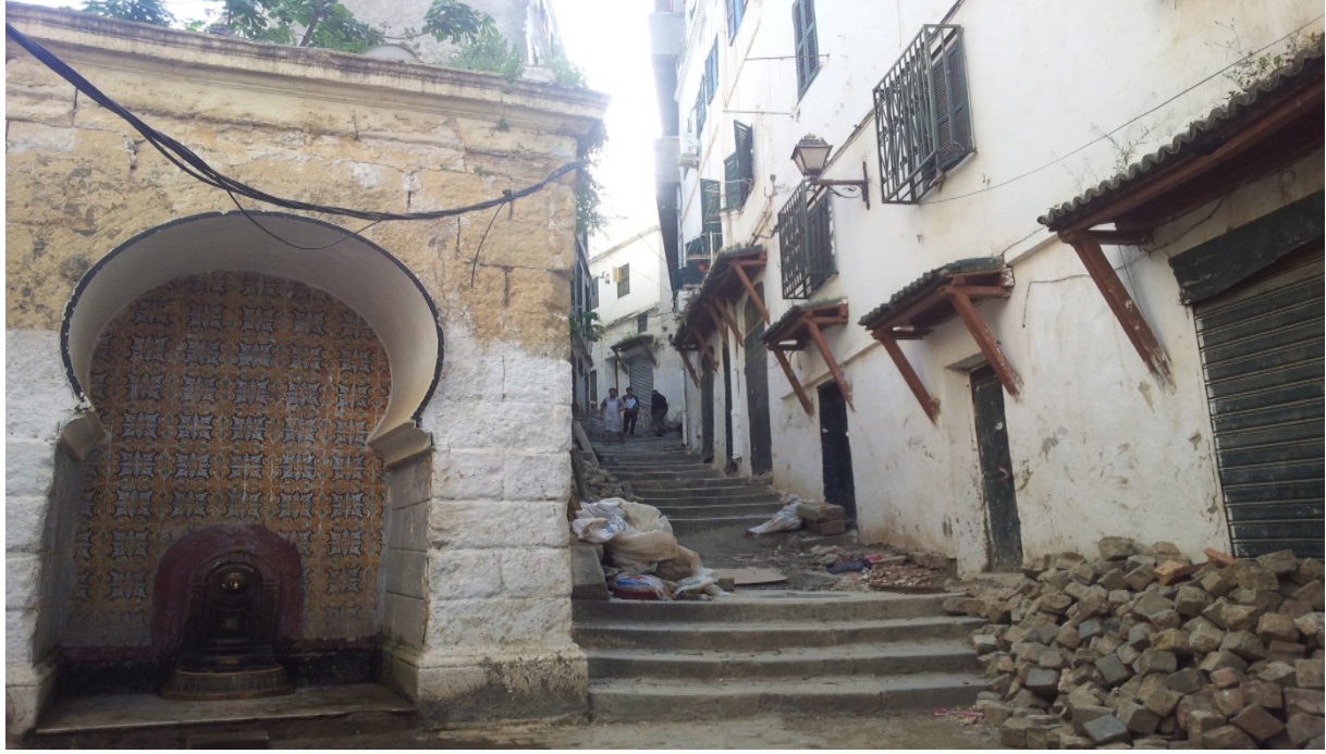
صورة رقم 09: أحد أزقة القصبة قيد الترميم 1
