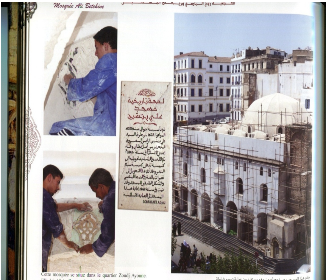
صورة 42 : مسجد علي بن بشين أثناء عملية ترميمه 2
