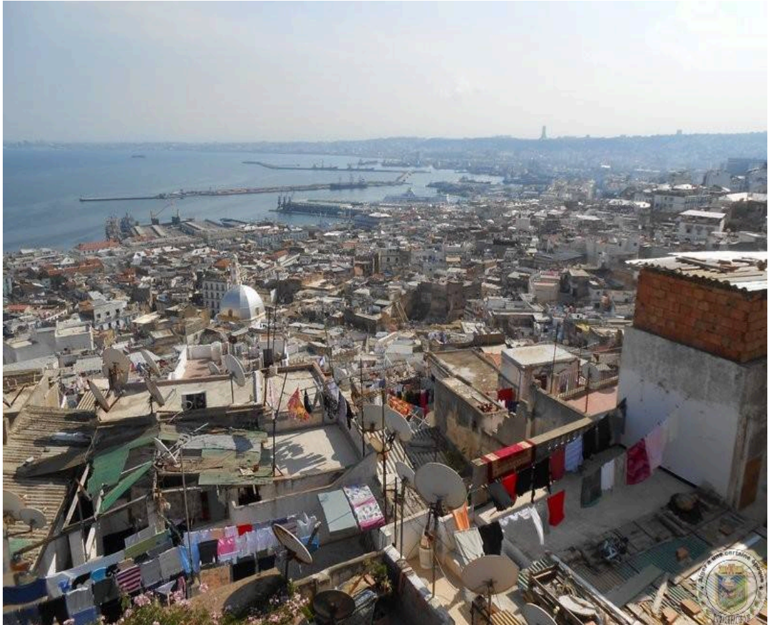
صورة 46: أسطح القصبة بعد البناء العشوائي القصديري عليها 2
