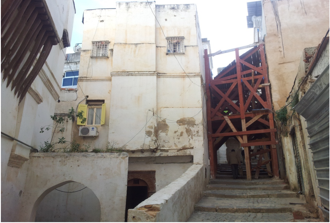
صورة 45: أشغال الترميم بأحد الأحياء بالقصبة 1
