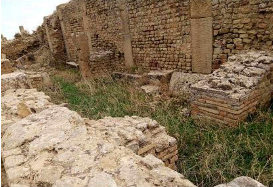
صورة (31): معبد سيريس، جدار سند شمالي لساحة المعبد، صورة مأخوذة من الزاوية الغربية
