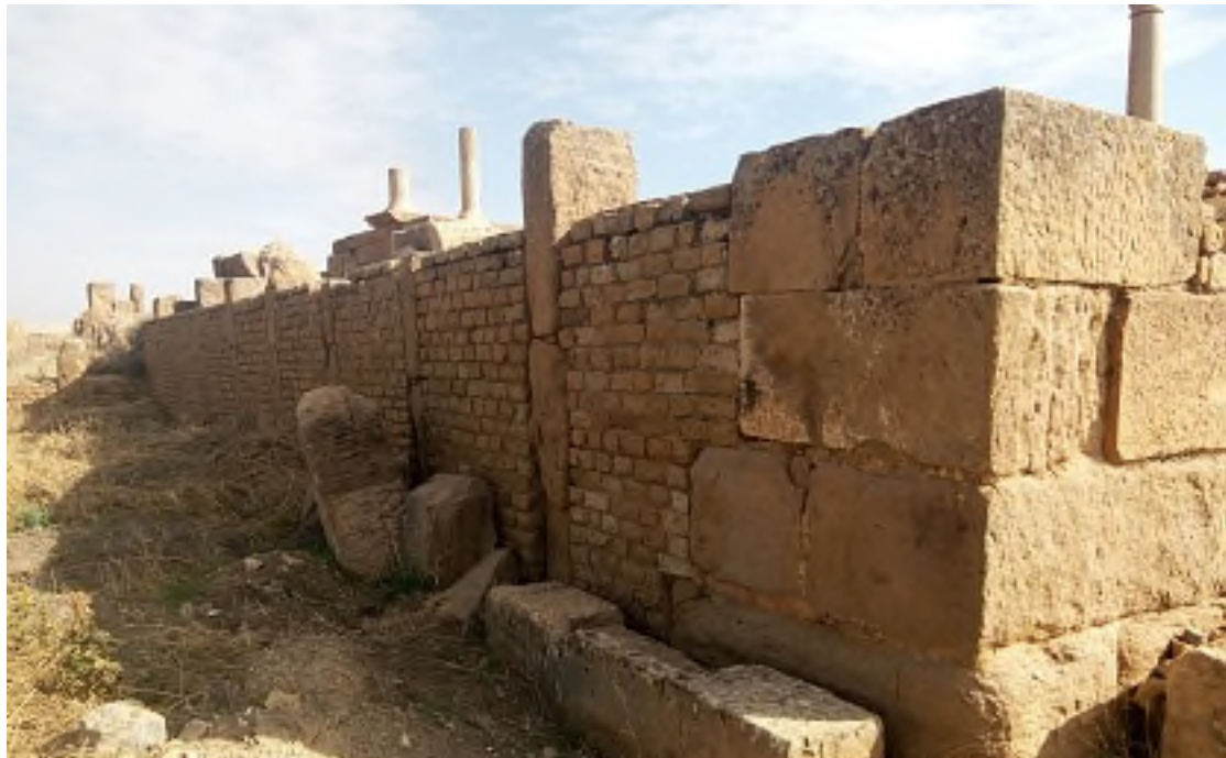
صورة (51): المعبد الحامي، استعمال تقنية Quadratum في انجاز الزاوية الجنوبية الغربية للسور الخارجي
