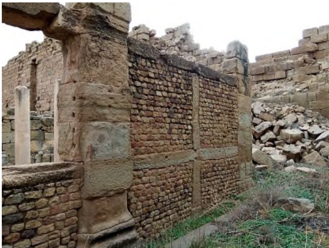
صورة (111) : مجمع المياه السبتيمة، التقنية الافريقية في جدار واجهة القسم المقدس.
