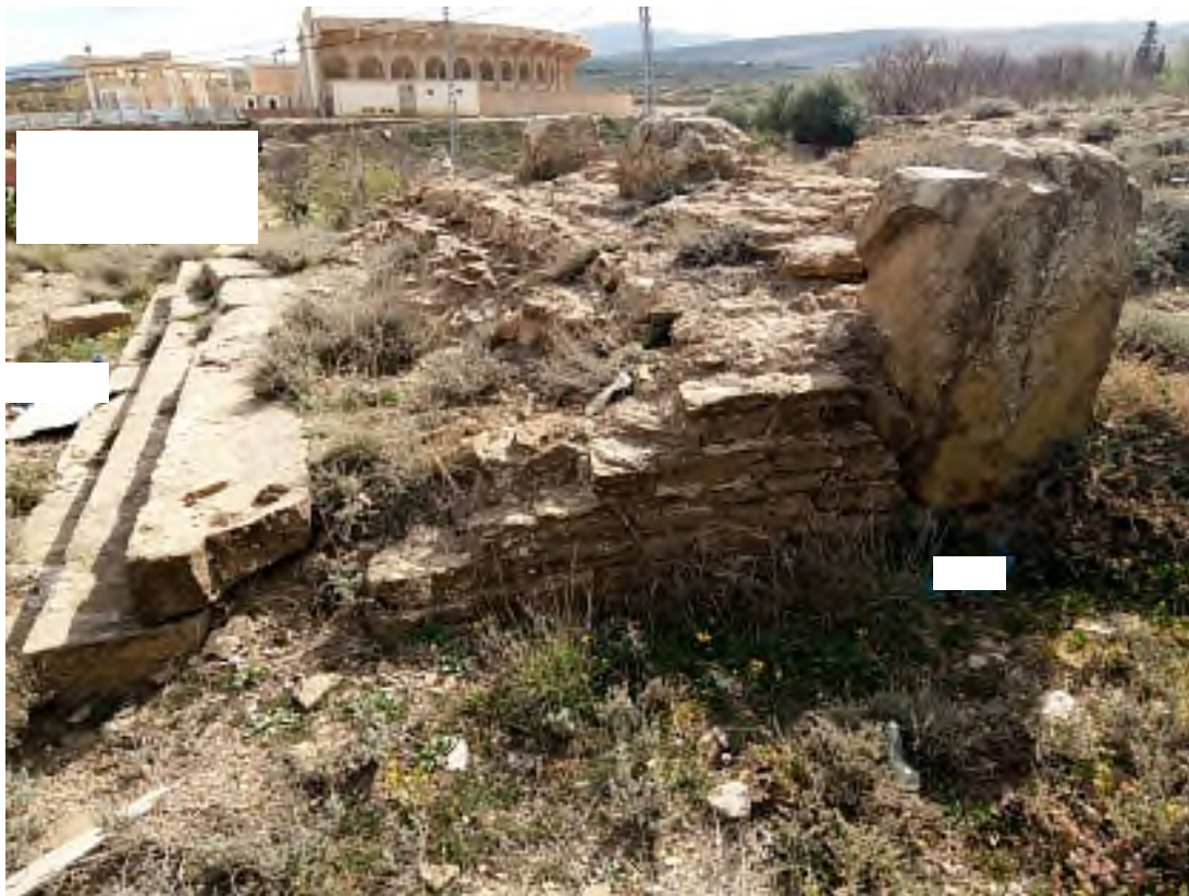
صورة (127): معبد ساتورن، سلم القاعة المقدسة المركزية
