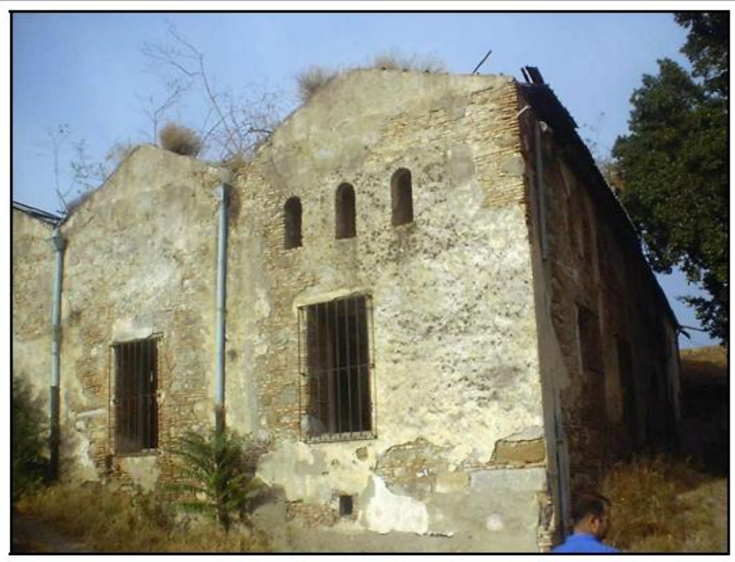
صورة 6: تمثل الواجهة الجنوبية الشرقية لجامع القصبية ببجاية المرجع نفسه، ص 260
