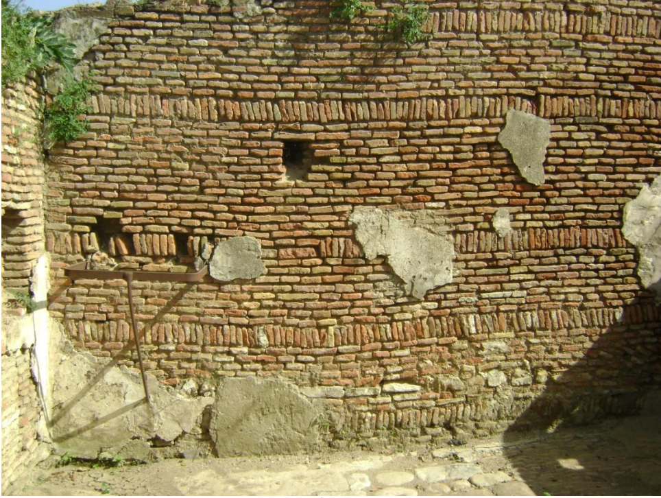
صورة 15: توضيح استعمال Opus Testaceum
