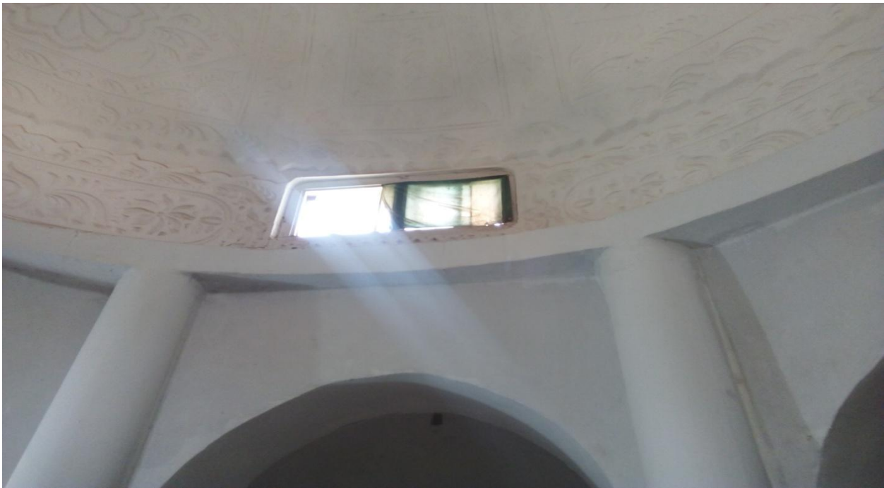
صورة رقم 64 ارتجال في ترميم مبنى العرض
