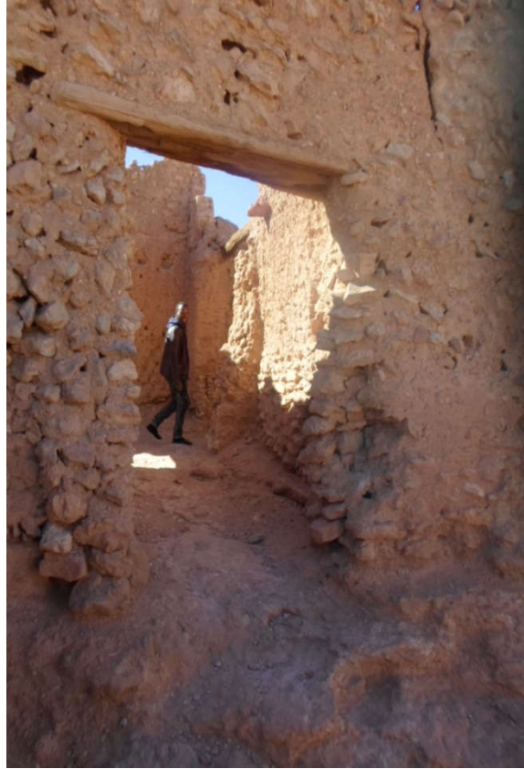
صورة رقم 31 تقنية البناء غير المنتظمة
