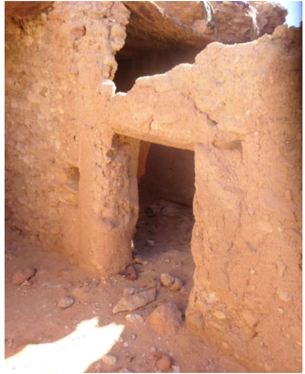
صورة أ مدخل إحدى الغرف
