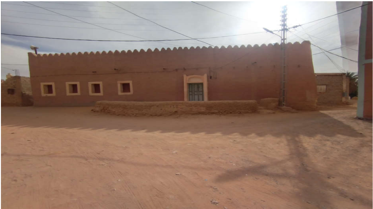
صورة رقم ب الجانب الشمالي للزاوية ويحوي المدخل الرئيسي
