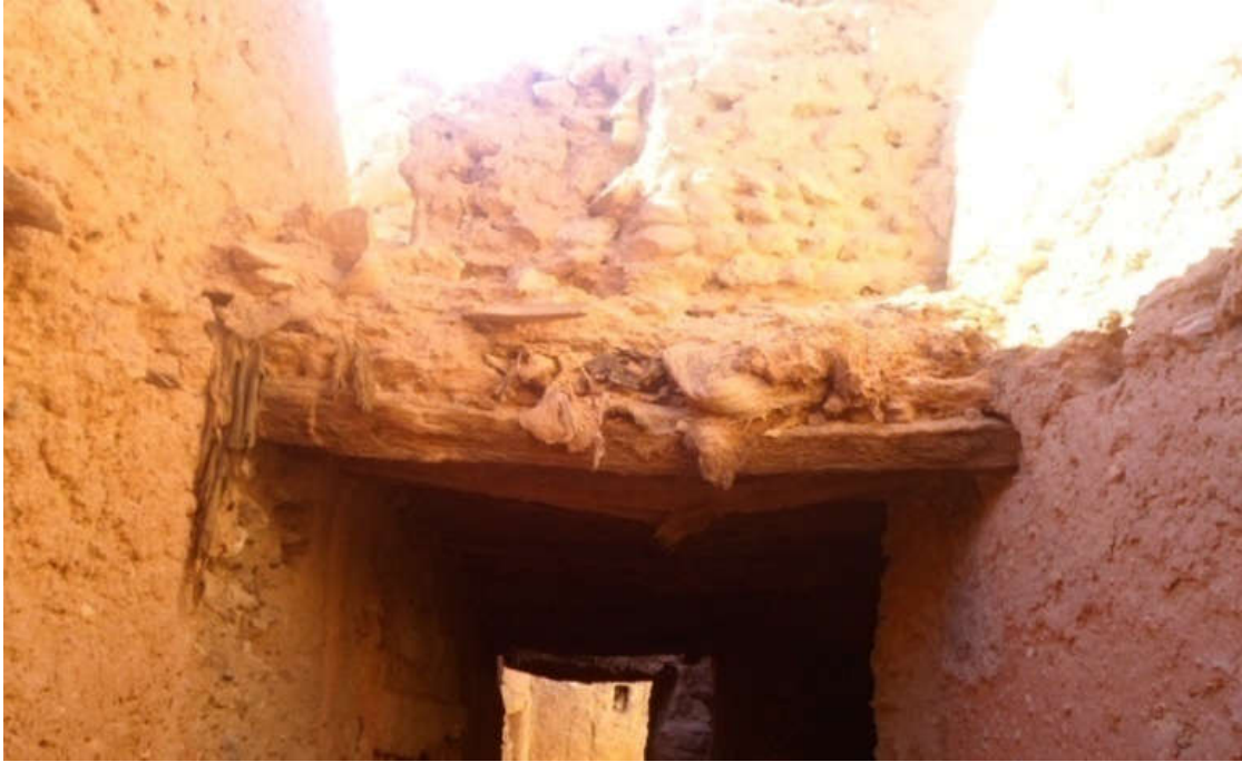
صورة رقم 33 استخدام الخشب في التسقيف
