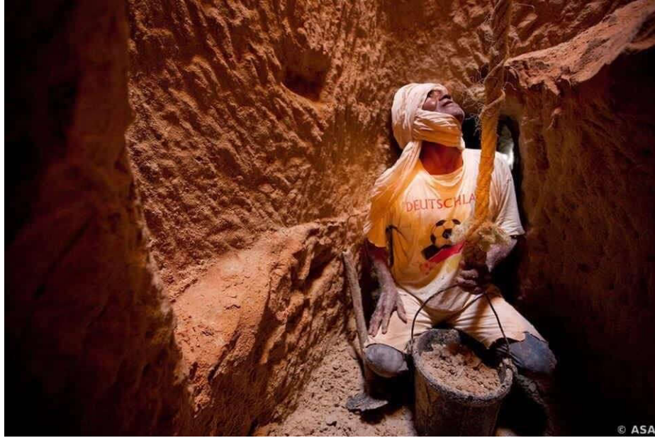
صورة رقم 20 عملية حفر وجذب التراب داخل البئر
