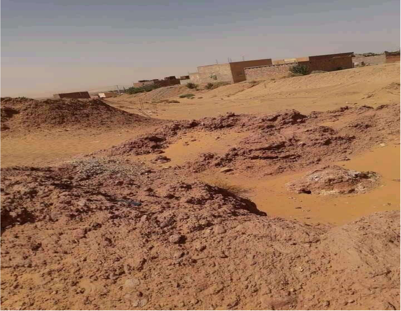
صورة رقم 27 سلسلة آبار فقارة بن الطاهر وهي مغطاة بطبقة من الطين
