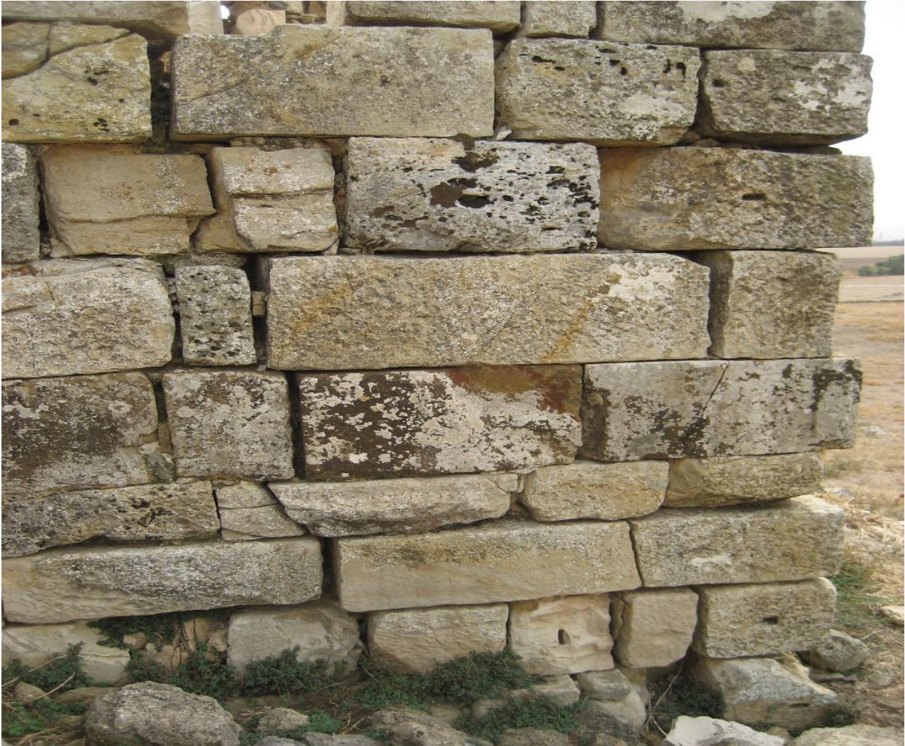
صورة رقم 63 : تقنية البناء المنتظمة الزاوية في تيفاش (تصوير الطالبة)
