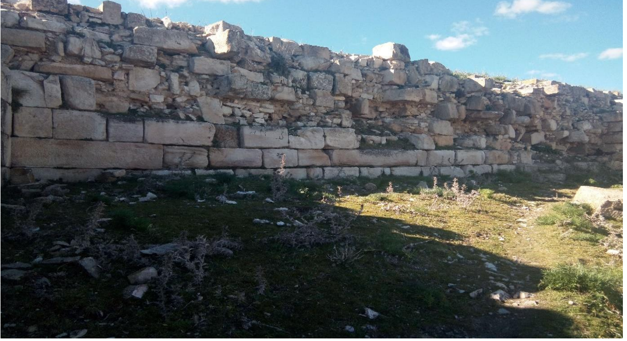
صورة رقم 60 : تقنية البناء في الجهة الشرقية تاورة ( تصوير الطالبة )
