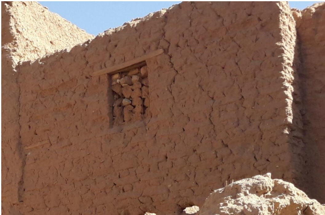
الصورة 23: لجدار بطريقة وضع الطوب أفقيا وعموديا
