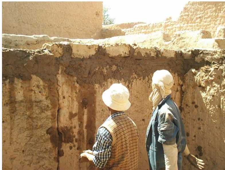
الصورة رقم 57: توضح بناء الجدار، من إعداد الطالبة
