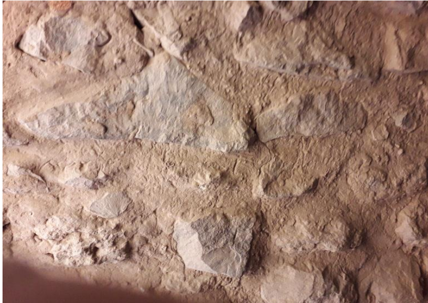
صورة 24: تقنية البناء بالحجارة غير المهذبة غير المنتظمة (الدبش)
