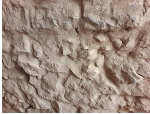
صورة 26: البناء الملاط كمادة أساسية وكمية قليلة من الحجارة (المزج)
