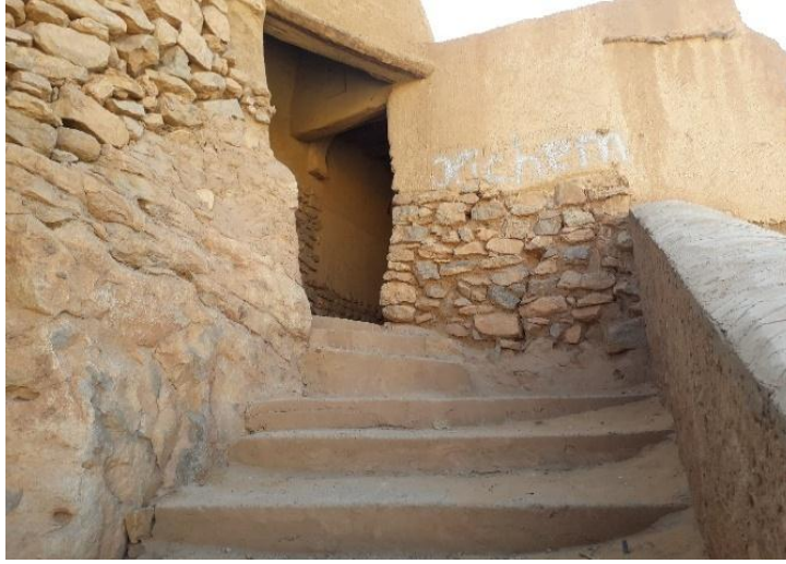
الصورة 6: المدخل الشمالي
