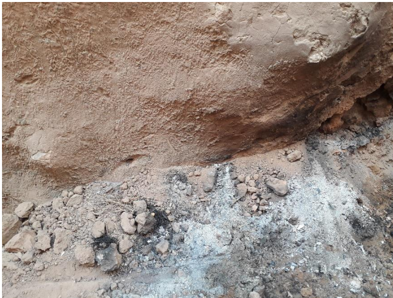
الصورة 31: ناتج الحرائق
