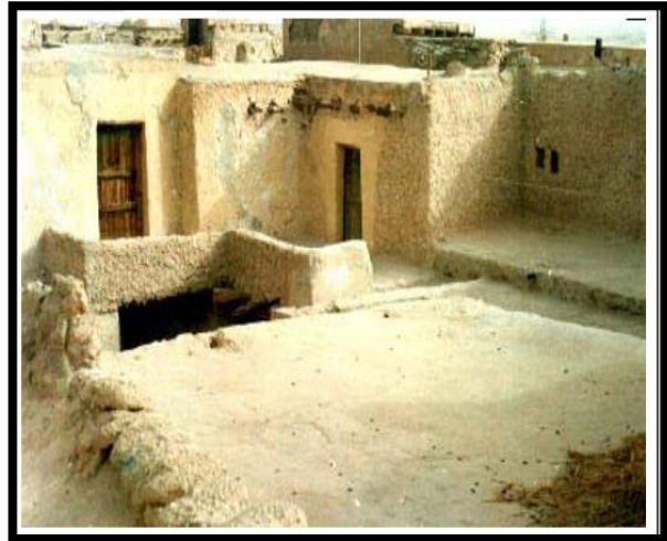
صورة رقم 01 سطح المنزل بقصر مستأوة
