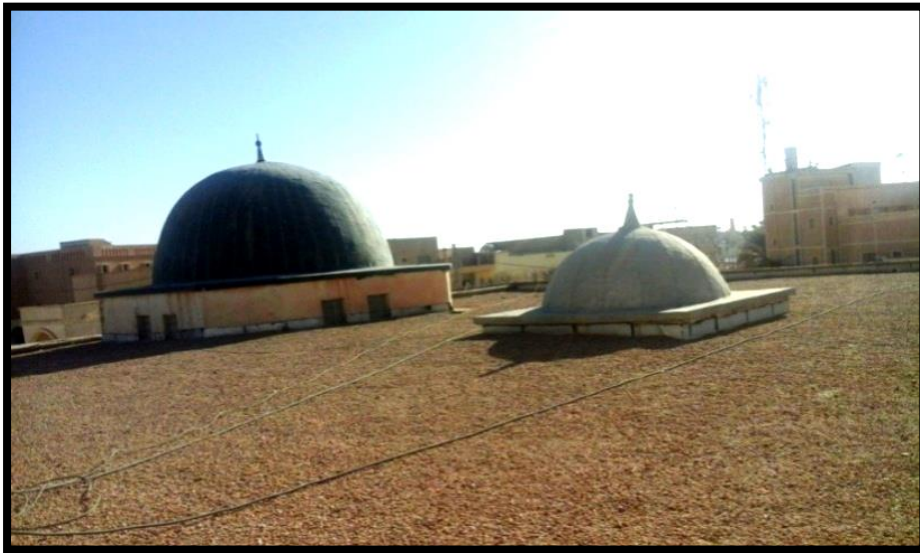
صورة رقم 20 تقنية بناء بالقباب مسجد مستاوة
