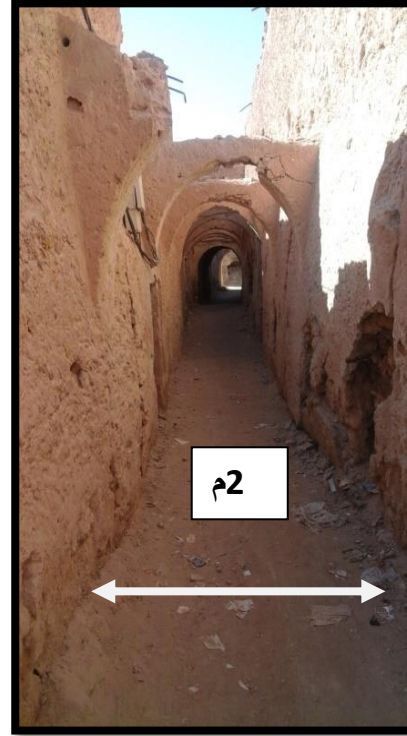
صورة 01 رقم ممرات مسدودة بقصر تبسبست 2م
