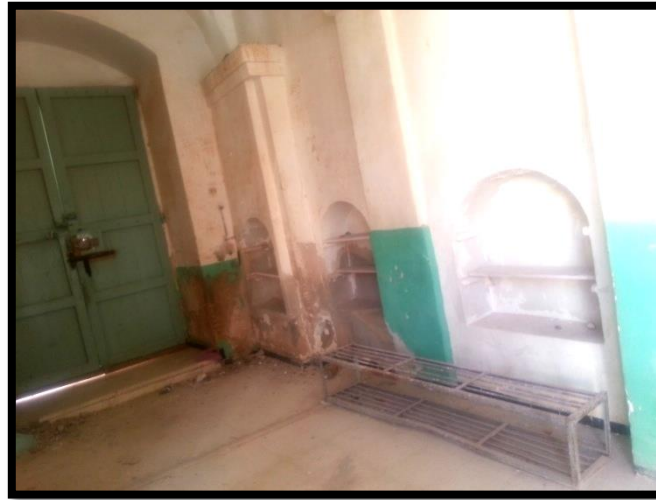
صورة رقم 01 استعمال جذوع النخيل في صناعة الأبواب بمسجد مستاوة
