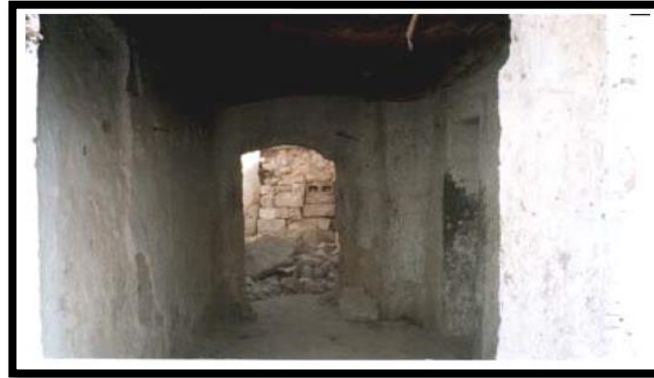
صورة رقم 13 منظر لسقيفة البيوت بقصر مستأوة
