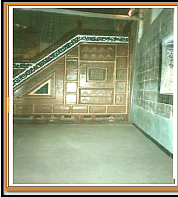
صورة رقم 02 واجهة منبر مسجد مستأوة قبل الترميم
