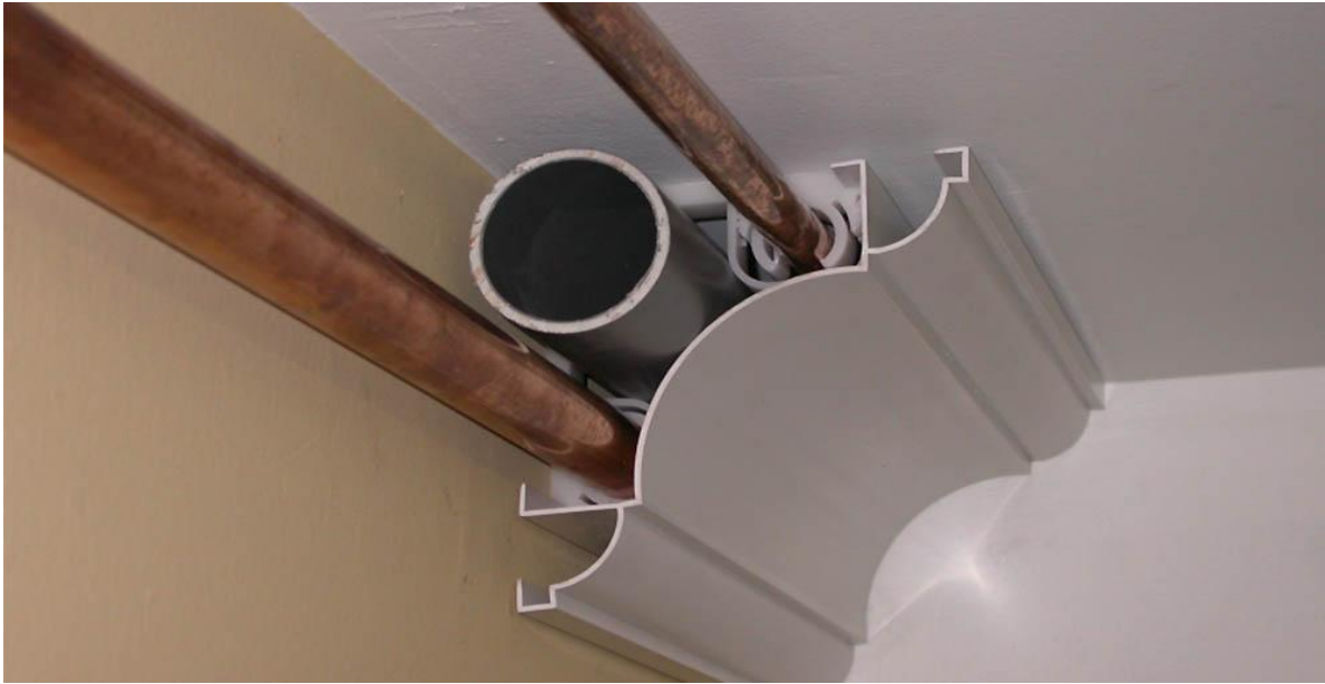
الصورة 22 : تغطية أنابيب المياه بعازل مصنوع من معدن الألمنيوم .
