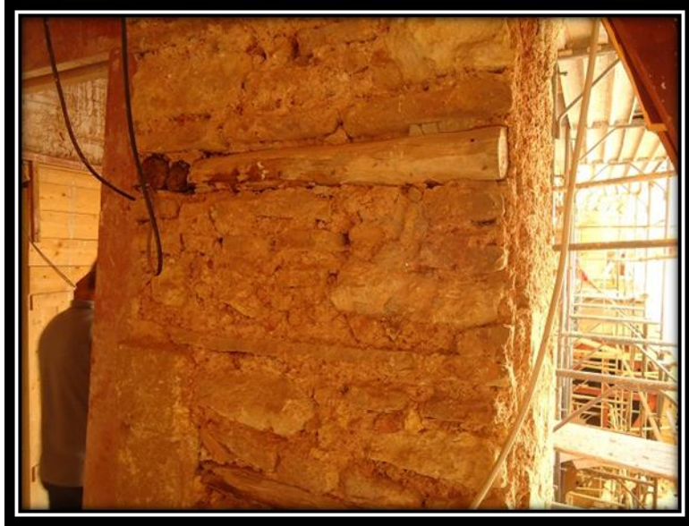
الصورة رقم 130: استعمال الآجر في الدعامات
