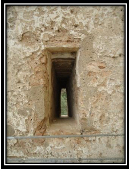
الصورة رقم 67: شكل مزاغل الطبانة
