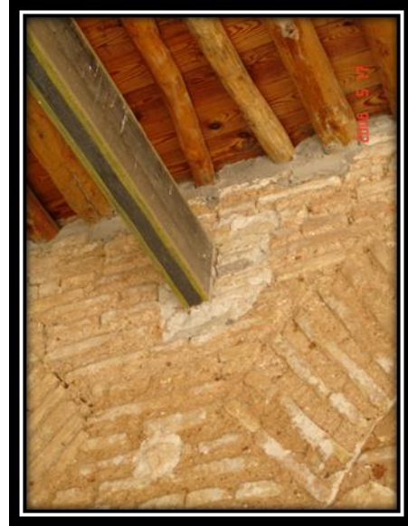
الصورة رقم 159: تقنية آدية و الشناوي
