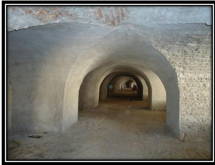
الصورة رقم 106: كيفية استعمال الجص على القباب المتقاطعة والدعامات
