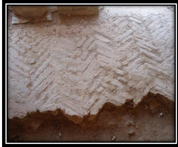
الصورة رقم 163: تقنية البناء السنبلية
