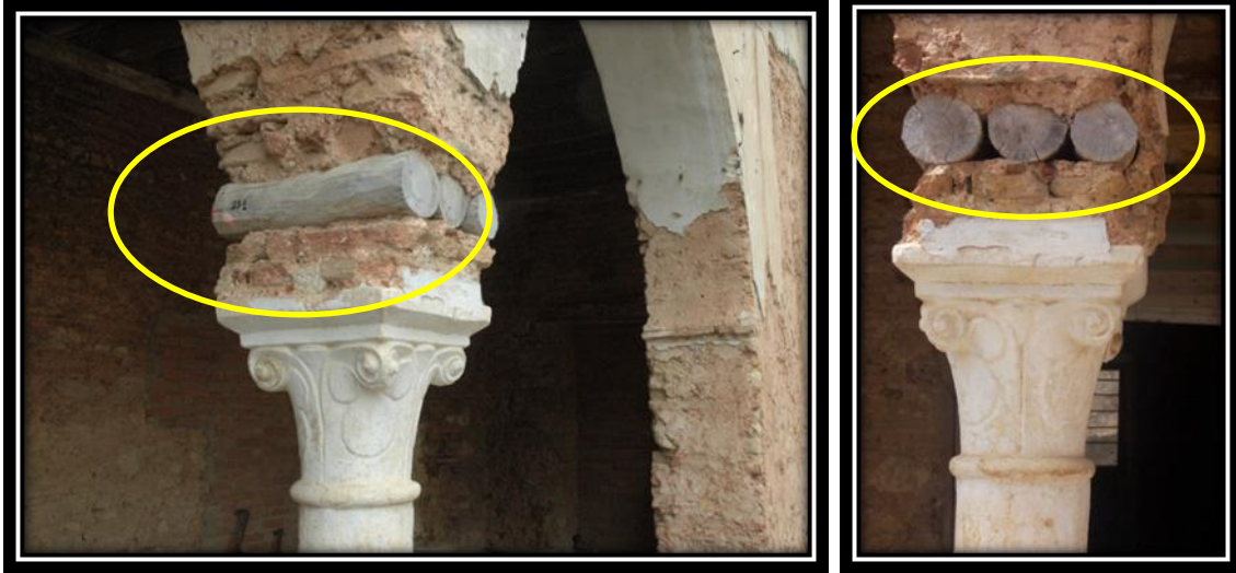
الصورة رقم 198: وضعية الخشب فوق التاج وبداية العقد الصورة رقم 199: كيفية وضع الخشب قبل الترميم
