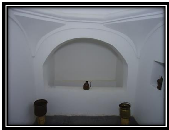
الصورة رقم 46: الغرفة الساخنة لحمام الآغا
