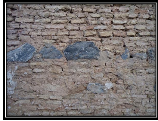
الصورة رقم 100: كيفية استعمال الحجارة في البناء الصورة رقم 101: عينة من الحجارة المستعملة في بناء القلعة
