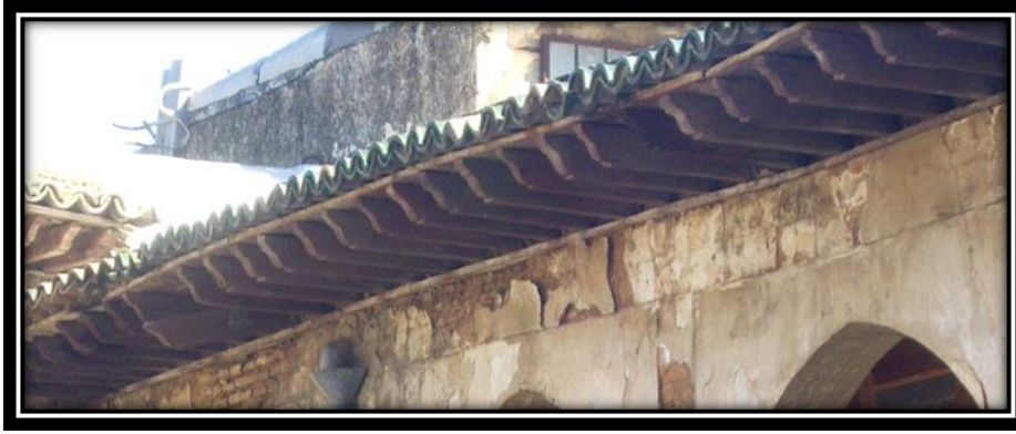
الصورة رقم 153: كيفية استعمال الخشب في الأسقف المائلة
