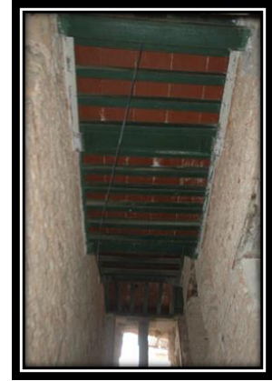
الصورة رقم 182: كيفية تسقيف بعض السلاالم
