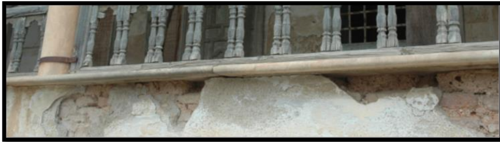
الصورة رقم 193: الطنف الرخامي الذي يفرق الطوابق الداخلية
