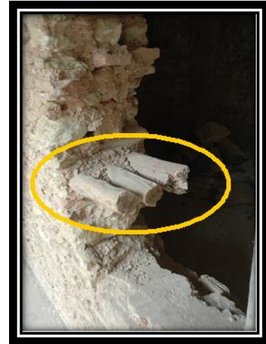
الصورة رقم 154: غرس الخشب في الحائط الصورة رقم 155: استعمال الخشب لمقاومة الضغط
