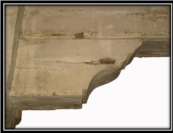
الصورة 204: تفصيل الحوامل الخشبية الضخمة
