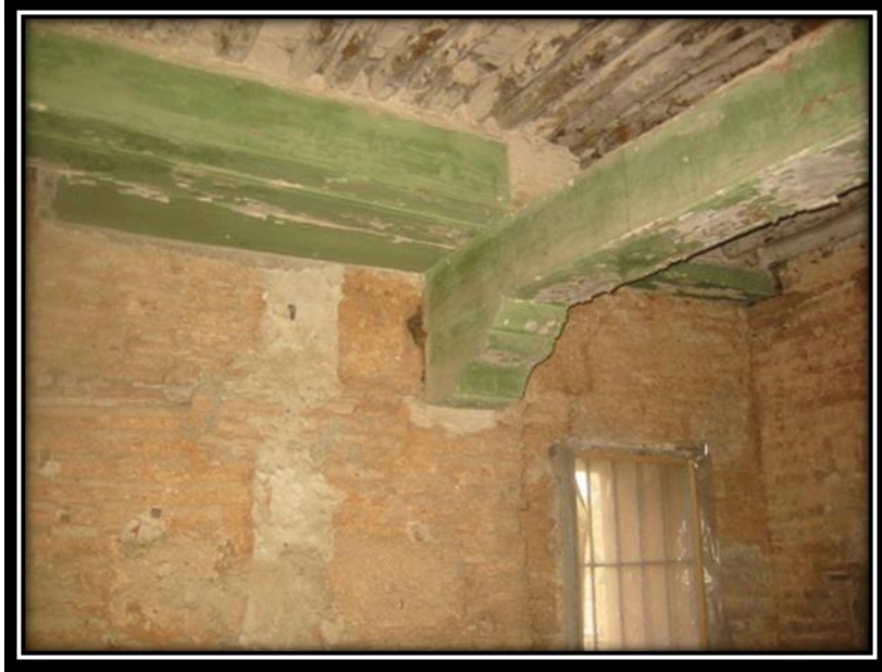
الصورة رقم 205: شد الجدران والتسقيف بالخشب
