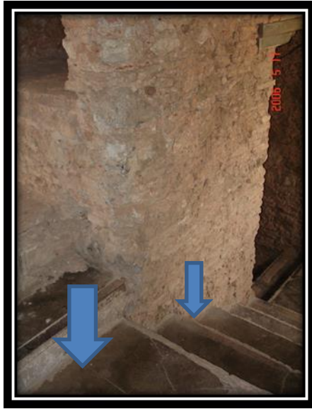
صورة رقم 119: كيفية تبليط الدرج بالأردواز
