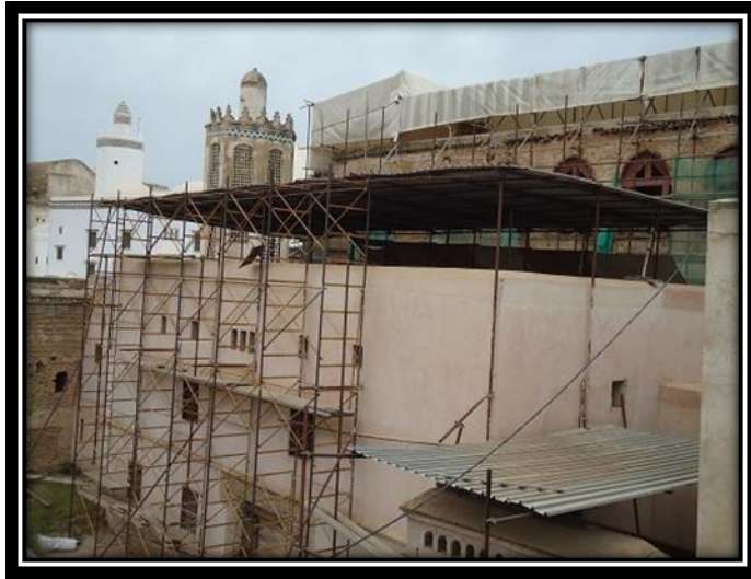
الصورة رقم 12: مسجد الجيش أثناء الترميم بقلعة الجزائر-عن الطلب-
