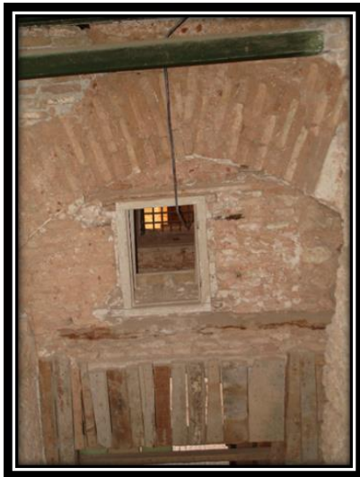
الصورة رقم 167: تقنية البناء المزدوج
