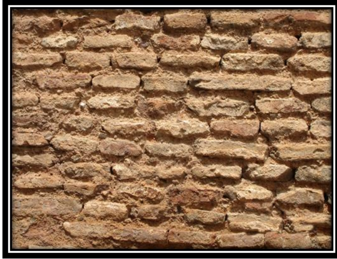
الصورة رقم 126: الأجر المستعمل بالقلعة
