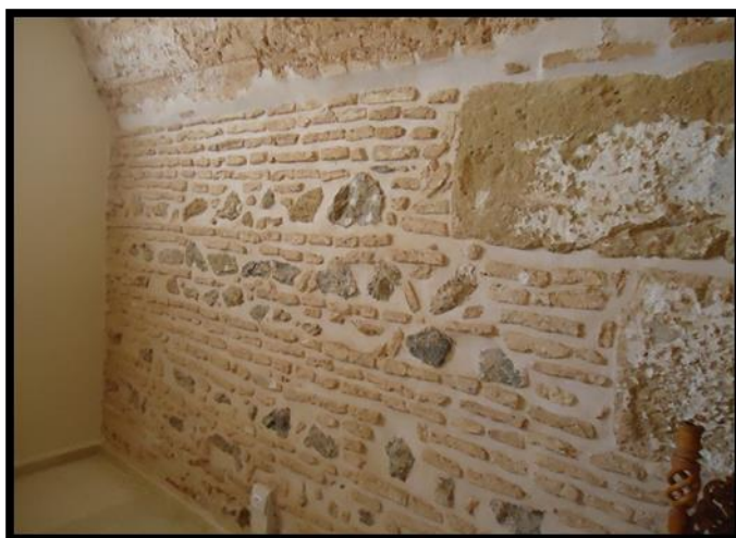
الصورة رقم 164: تقنية البناء بالتناوب بعد الترميم
