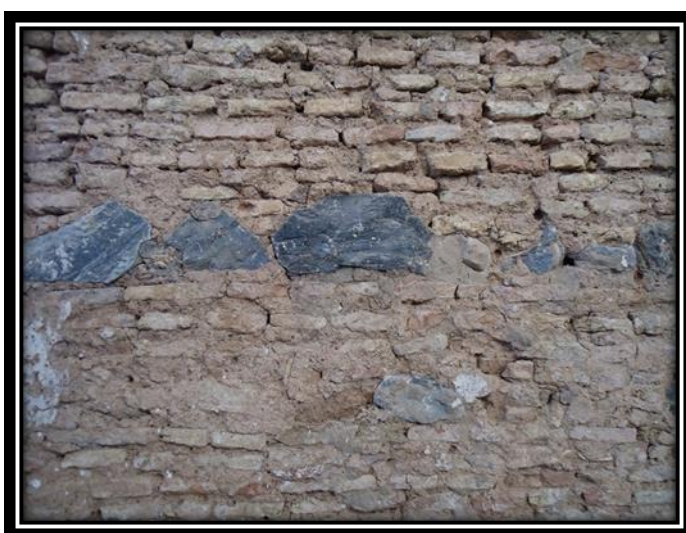
الصورة رقم 165: تقنية البناء بالتناوب
