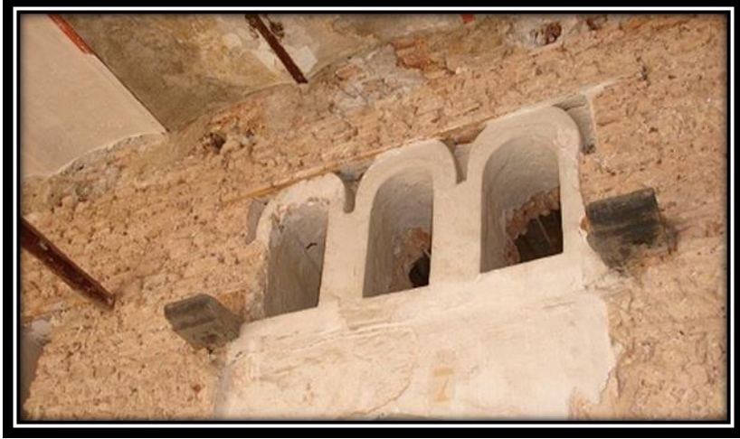
الصورة رقم 187: شمسيات مفرغة نتيجة الترميم
