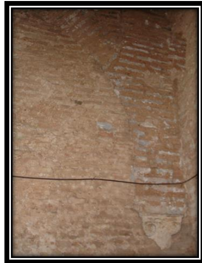
الصورة رقم 166: تقنية البناء المزدوج
