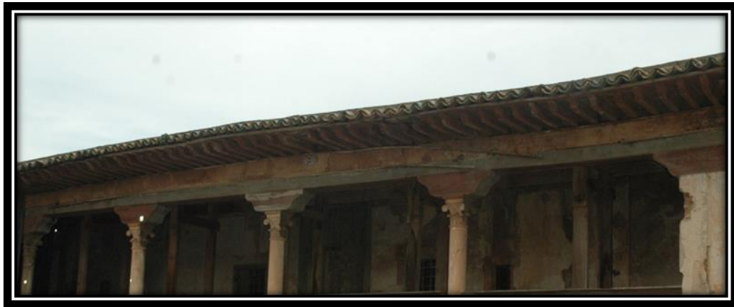
الصورة رقم 133: التسقيف المائل بالقرميد
