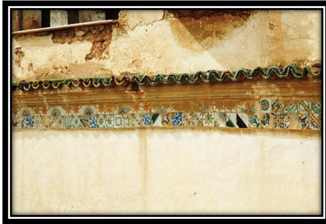
الصورة رقم 33: طنف القرميد للواجهة الجنوبية.
