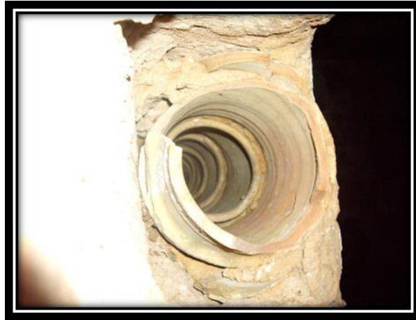
الصورة رقم 134: قناة صرف مياه الأمطار المغروسة في الحائط
