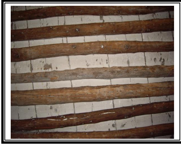
الصورة رقم 29 : التسقيف المسطح في بيت صلاة المسجد البراني
