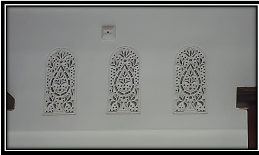
الصورة رقم 189: الشمسيات بعد الترميم قصر الأغا
