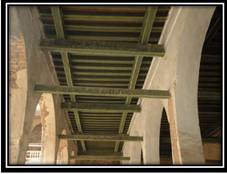
الصورة رقم 181: التسقيف بالخشب المكعب مع الشد
