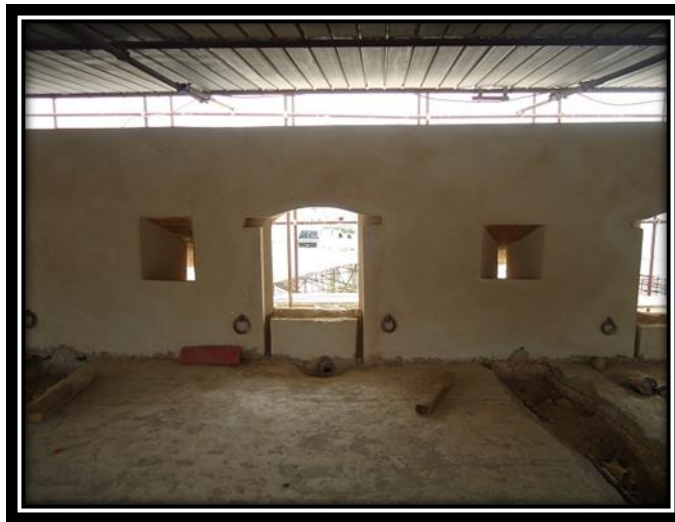
الصورة رقم 65: فتحات المدفعية والحلقات الحديدية فتحة تسريب ماء المطر و المزاغل
