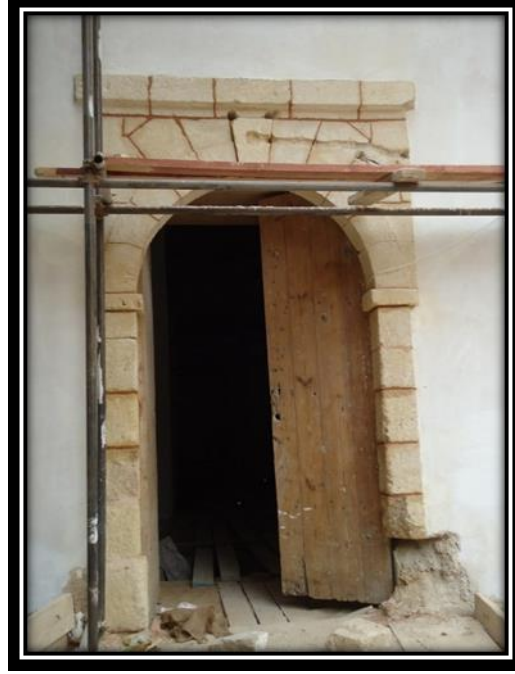
الصورة رقم 104: اطار من الحجر الكلسي
