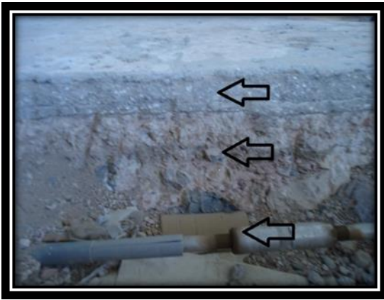
الصورة رقم 69: الأرضية الموجودة أثناء الترميم
