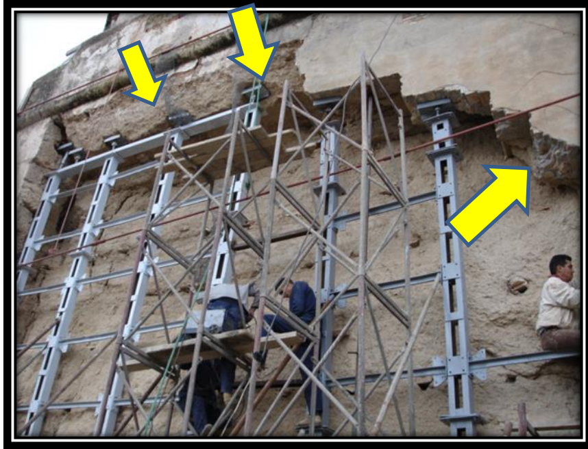
الصورة رقم 125: الصور الخارجي يبين لنا نوع الطابية المستعملة في البناء
