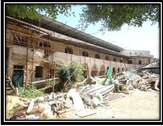
الصورة رقم 61:الجهة الداخلية للطبانة
