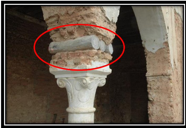
الصورة رقم 154: غرس الخشب في الحائط الصورة رقم 155: استعمال الخشب لمقاومة الضغط
