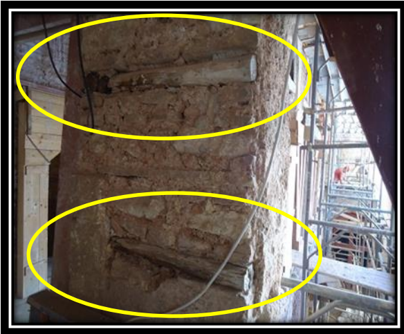
الصورة رقم 197: خشب التونة المحشو في جدار حامل
