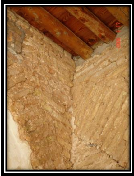
الصورة رقم 160: تقنية آدية و الشناوي في الأركان
