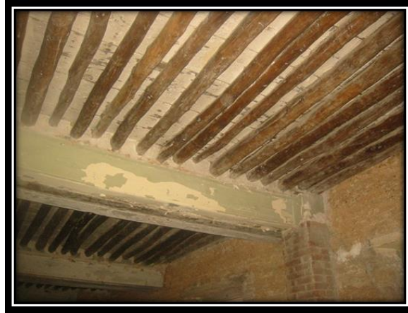
الصورة رقم 157: الحوامل الخشبية المستعملة في التسقيف
