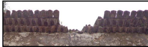
صورة 187 / القلعة الحفصية - طريقة التسقيف بالقرميد.
