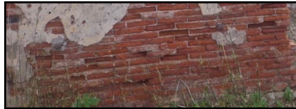
صورة 188 / القلعة الحفصية - تقنية المداميك الآجورية المنتظمة.
