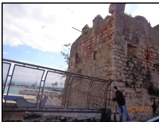
صورة 193 / حصن المغذيين - الواجهة الشمالية.
