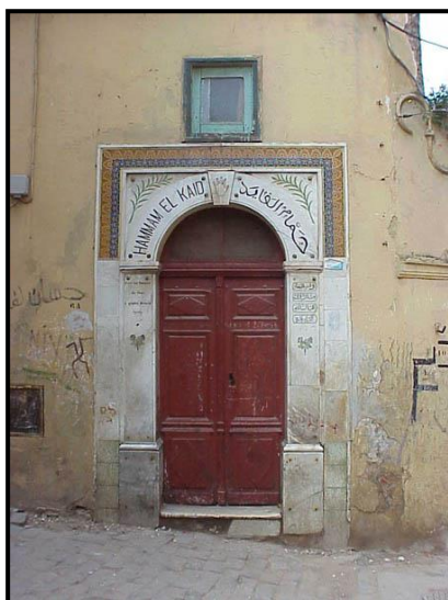
صورة 139 / حمام القايد - المدخل الرئيسي.
