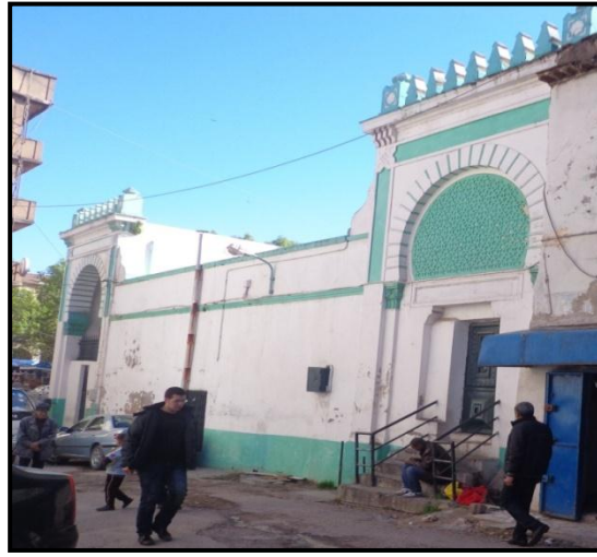
صورة 24 / جامع الباي - الواجهة الجنوبية.
