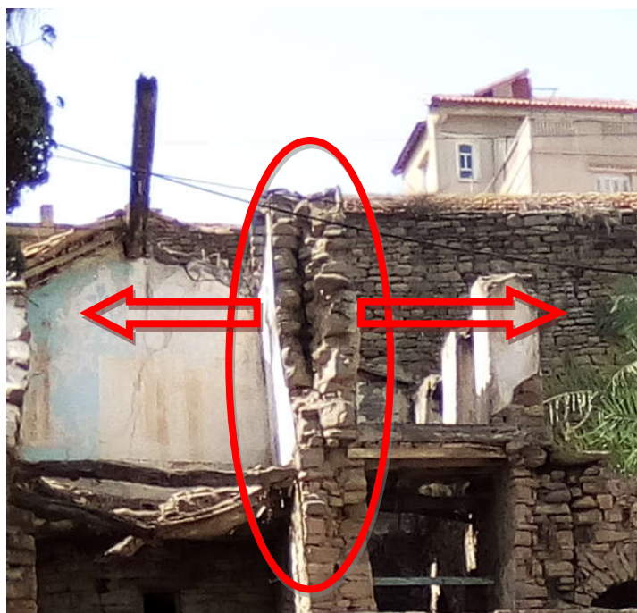
الصورة رقم (01) غياب تقنيات الربط الجيدة في الجدران
