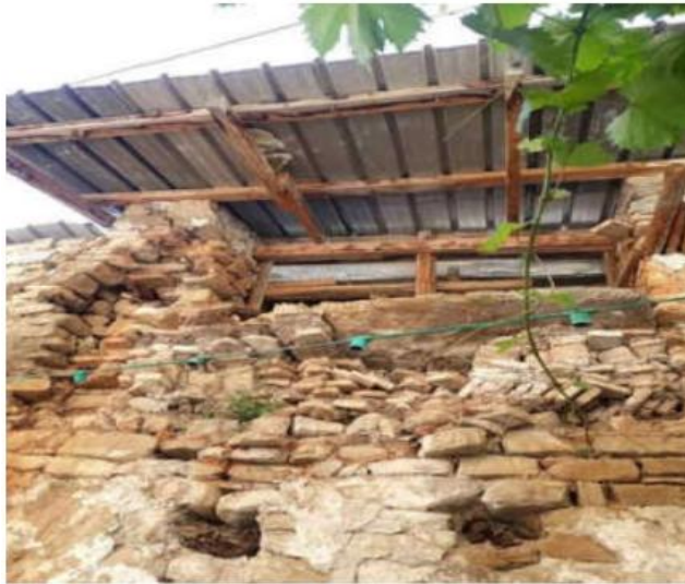
(الصورة رقم 04) استعمال الأجر كطوب لبناء الأقواس
