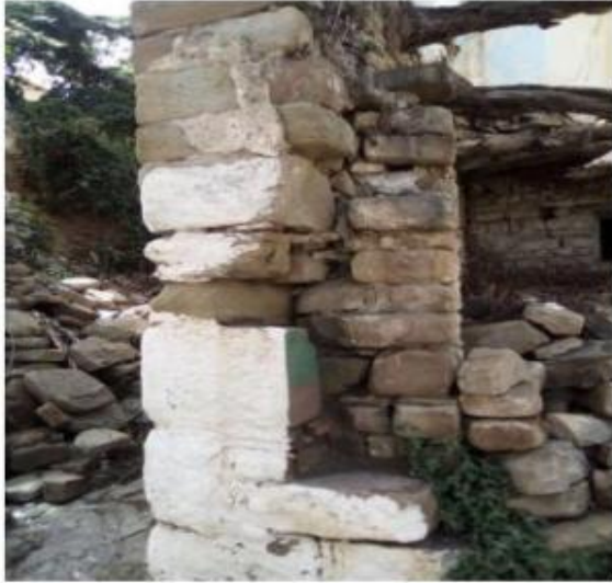
الصورة رقم (08) حجم وتنظيم الحجارة المستعملة في الأساسات
