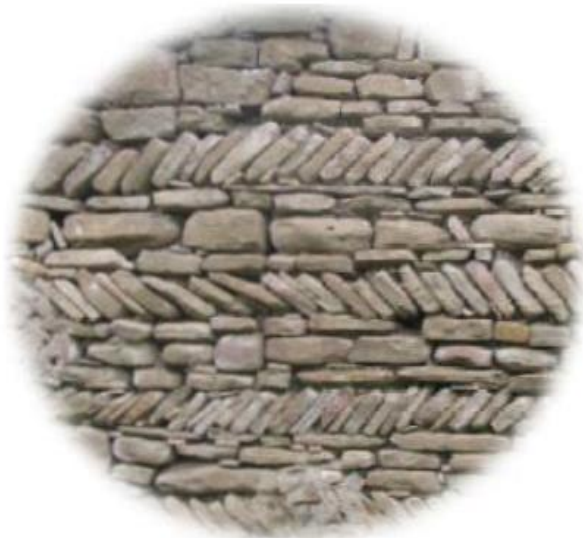
الصورة رقم (09) تقنية السنبله المستعملة في الجدران
