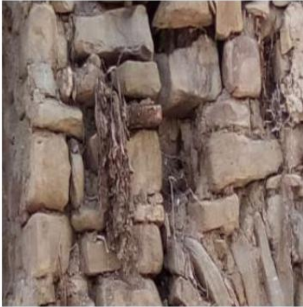
الصورة رقم (10) استعمال التربة في الربط
