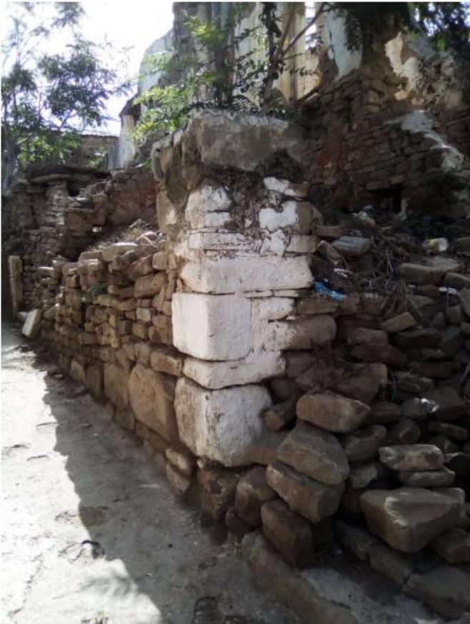
الصورة رقم (01) الحجارة المستعملة في البناء
