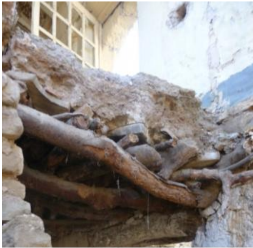
الصورة رقم 03 استعمال التربة في ارضيات الطابق
