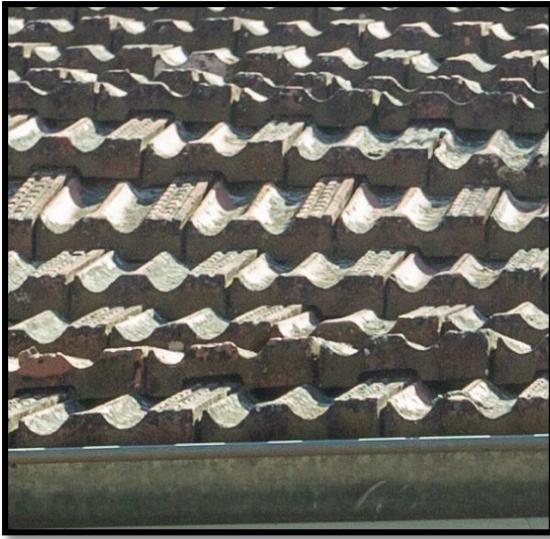
صورة 61:القرميد المستعمل في تغطية سقوف المساكن المدروسة ( عمل الطالبة)
