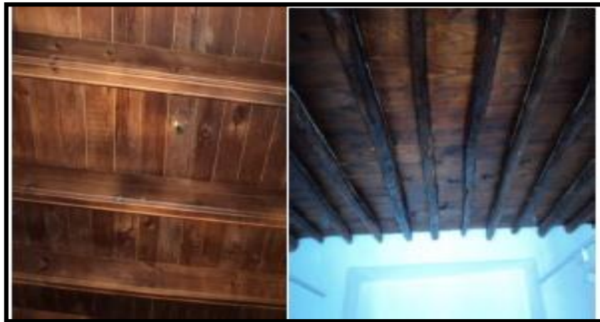
صورة 54: أنواع من التسقيف الخشبي للمساكن المدروسة ( عمل الطالبة)
