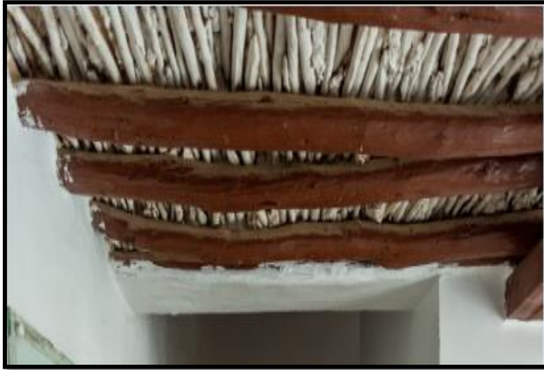
صورة 66: الخشب المستعمل في عملية التسقيف (عمل الطالبة)
