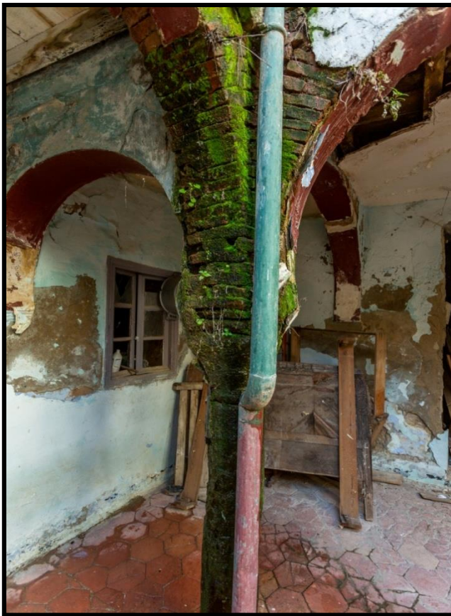
صورة 32: قنوات صرف المياه الموجودة بالأركان (عمل الطالبة)
