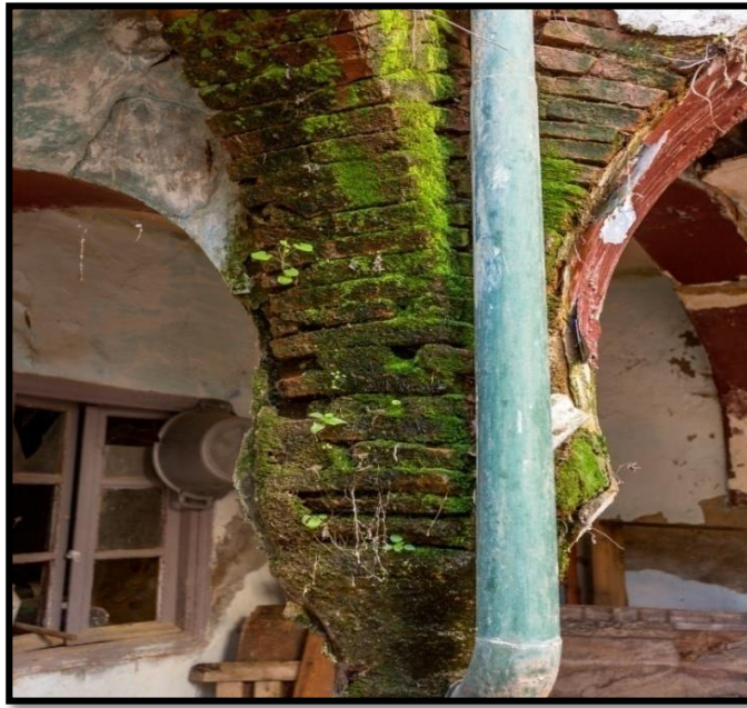
صورة 57 : الآجر المستعمل في بناء الأقواس ( عمل الطالبة )
