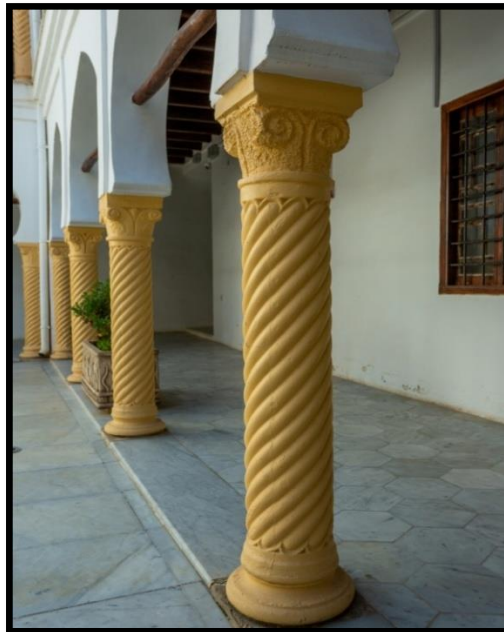
صورة 43: العمود الحلزوني (عمل الطالبة)
