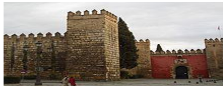
Muralla exterior y Puerta del León.
