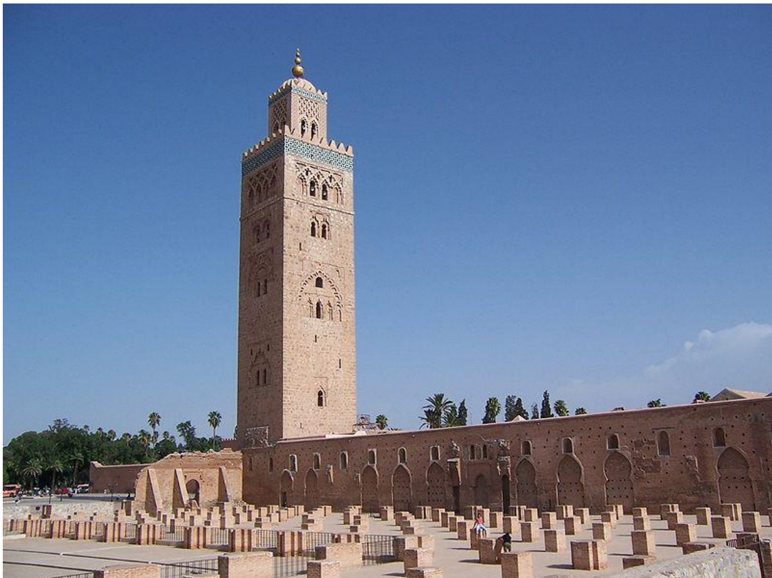
Mezquita Kutubía de Marrakech construida por el emir almohade Abd Al-Mumin sobre el año 1147
