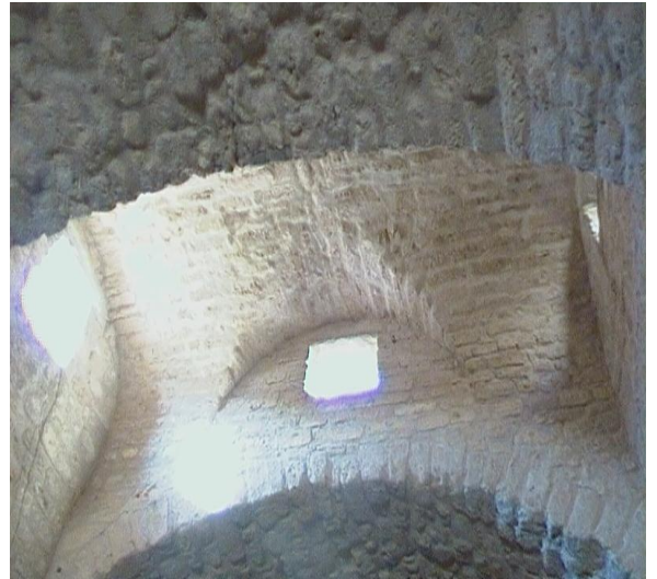
لوحة رقم (99)/ سابط الكحلة - مناور سماوية.
