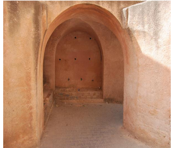
لوحة رقم (73)/ سباط رقم (01) بمدينة الأغواط- طريقة التسقيف بالعواض الخشبية بسباط محدث فوق زنقة .
