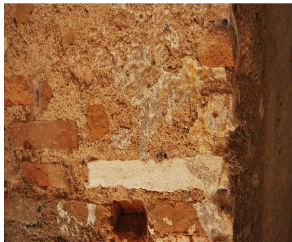
لوحة رقم (67)/ ساباط الكحلة - تكسية من الملاط بجدران الساباط.
