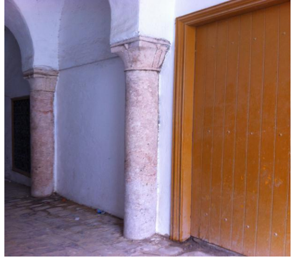
لوحة رقم (63)/ساباط السيارة - عمود من مادة الرخام بجدار السباط.
