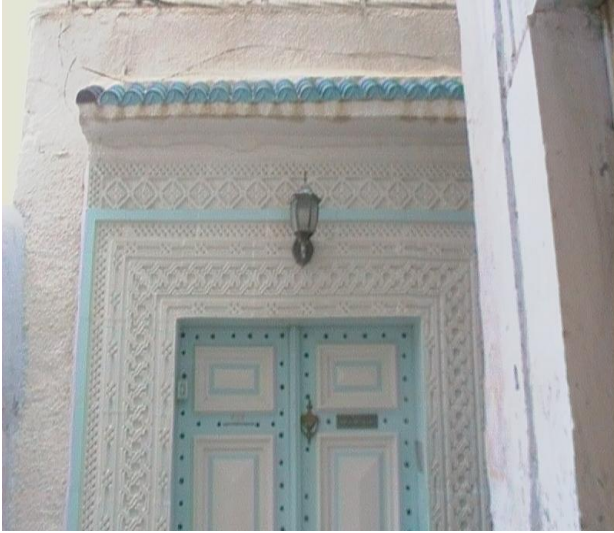
لوحة رقم (64)/ساباط رقم (05) بمدينة القيروان- إطار باب مصنوع من مادة الجص.
