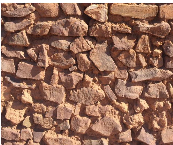
لوحة رقم (72)/ ساباط سيدي بلغيث - البناء بطريقة المزج .
