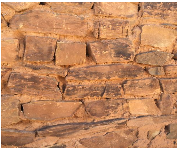
لوحة رقم (68)/ الساباطان المتجاوران - ساباط رقم (01) بمدينة ندرومة - طريقة المداميك المتكررة بالتناوب .
