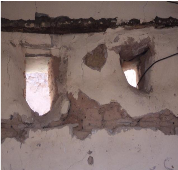
لوحة رقم (96)/ ساباط رقم (09) بمدينة القنادة - فتحات للتهوية والإنارة بالمدخل الجنوبي .
