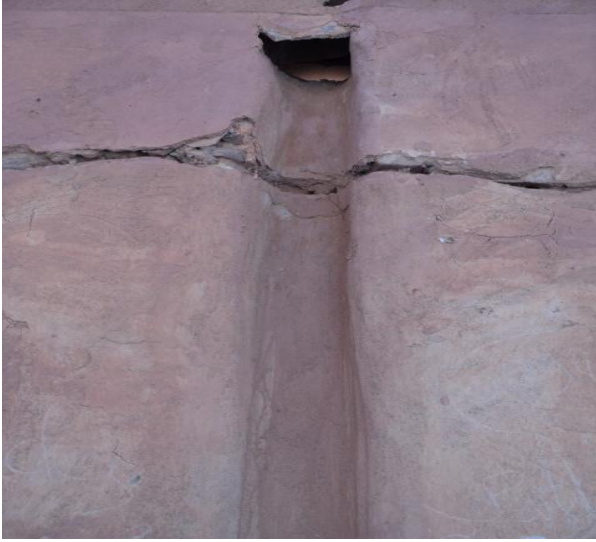
لوحة رقم (98)/ سابط رقم (05) بمدينة القنادة - ميزاب لصرف المياه (السلوقية) .
