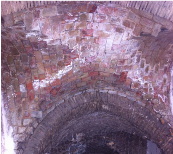
لوحة رقم (76)/ سباط جامع القصر- التسقيف بطريقة الأقبية المتقاطعة.
