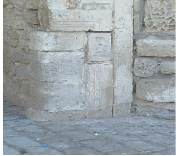
لوحة رقم (61)/ سباط الكحلة - البناء بمادة الحجر المصقول.
