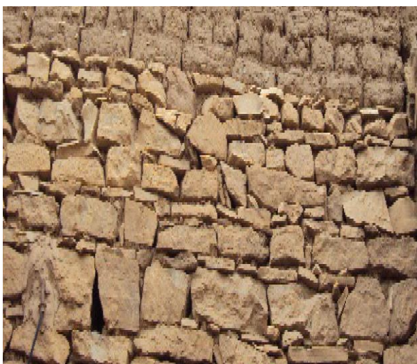
لوحة رقم (70)/ ساباط رقم (06) بمدينة الأغواط - طريقة آدية وشناوي.
