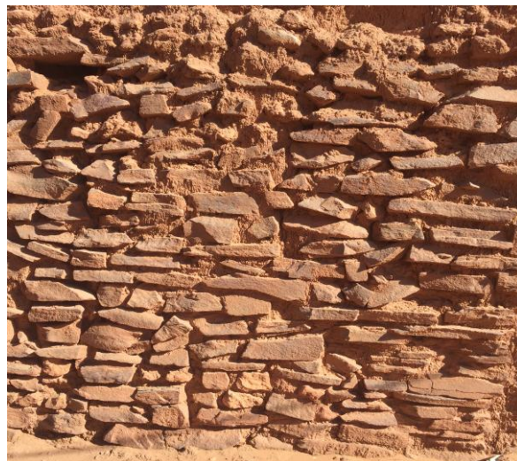
لوحة رقم (69)/ ساباط رقم (01) بمدينة الأغواط - طريقة المداميك العمودية المنتظمة.
