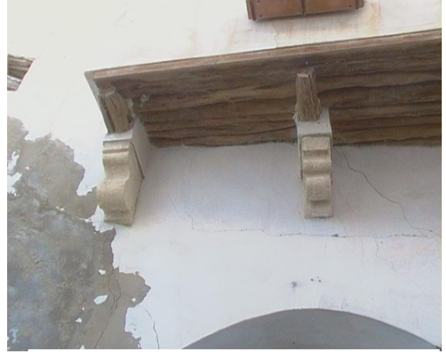
لوحة رقم (91)/ ساباط رقم (01) بمدينة القيروان - الدعامات بالمدخل الغربي.
