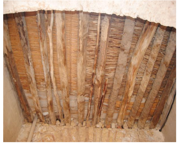
لوحة رقم (73)/ سباط رقم (01) بمدينة الأغواط- طريقة التسقيف بالعواض الخشبية بسباط محدث فوق زنقة .
