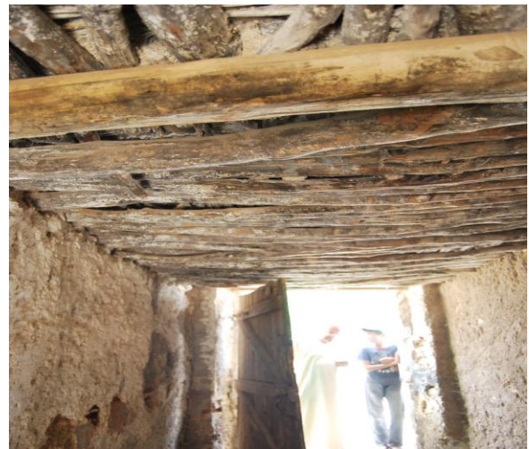
لوحة رقم (77)/ سباط سيدي بلغيث- سقف مسطح بالخشب.
