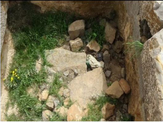
صورة 2: بقايا خزان
