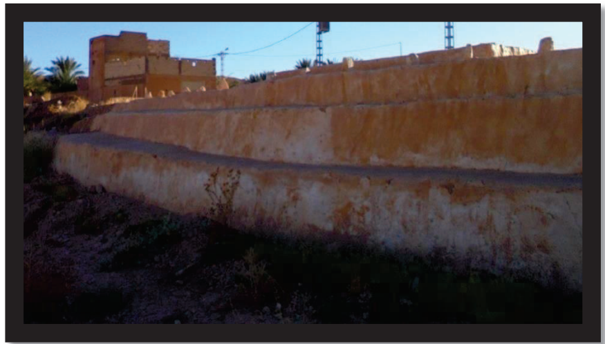
الصورة رقم4- 5: بقايا سد التوزوز
