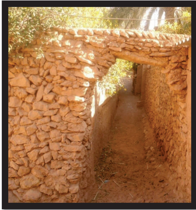
الصورة 41: تقنية بناء السواقي المحمولة باستعمال البلاطات الحجرية مكان العقد
