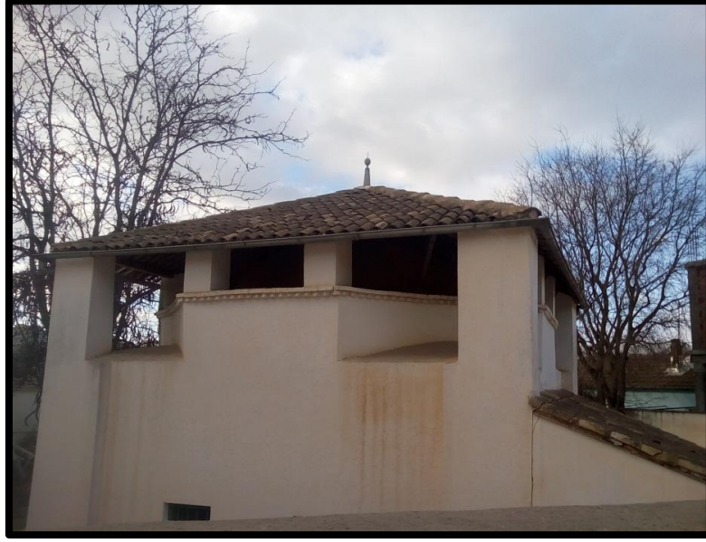
الصورة 60 : طريقة تسقيف ضريح سيدي الصحرابي
