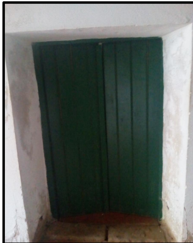
الصورة 26 : مدخل ضريح سيدي الصحراوي
