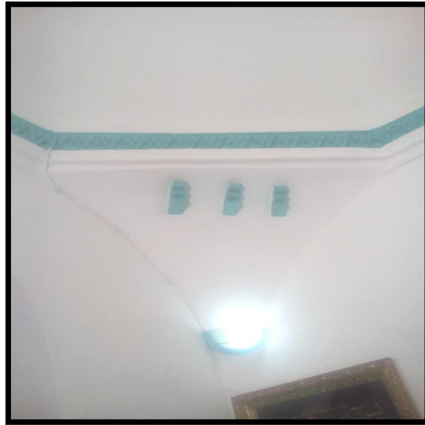
الصورة 51:منطقة الانتقال في قبة ضريح سيدي الهواري
